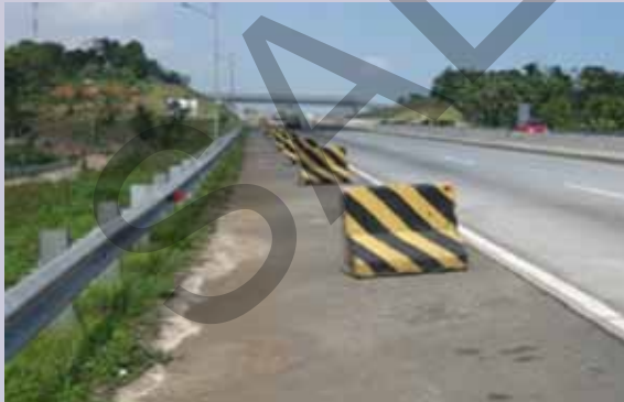
▲ Barikade beton digunakan secara tidak benar.
