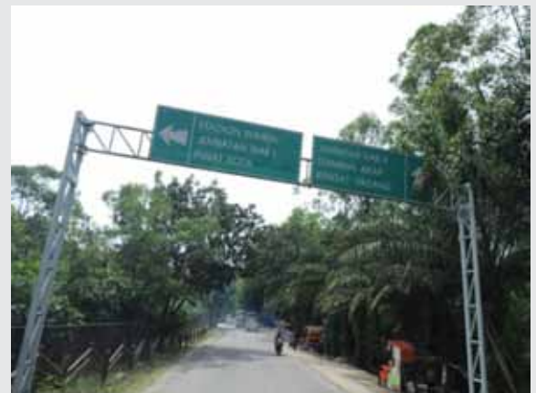
▲ Rambu petunjuk berada di atas jalan dua lajur. Namun, pengemudi/pengemudi berpikir bahwa ini adalah jalan satu arah karena rambu menunjukkan seperti itu. Seharusnya rambu dilokasikan pada sisi kiri dari tiang. Marka garis tengah harus dibubuhkan di jalan.
