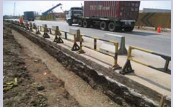
▲ Barikade beton yang tidak tersambung, barikade baja, dan galian sedalam 1 meter.
