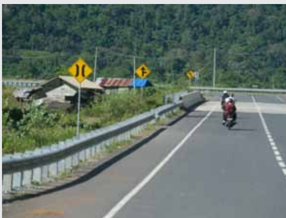
▲ Rambu peringatan jembatan yang tidak diperlukan - potongan melintang jembatan sama lebar dengan jalan.
