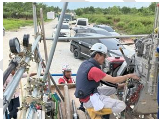
Pekerjaan pengeboran dengan metode pengeboran hibrida
