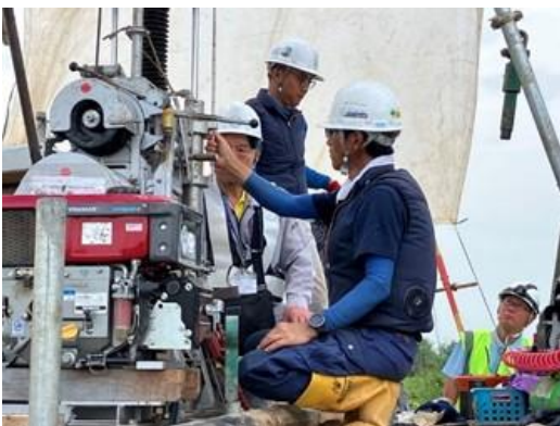
Pekerjaan pengeboran dengan metode pengeboran hibrida
