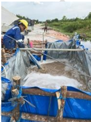
Penyimpanan fluida pengeboran untuk metode pengeboran hibrida
