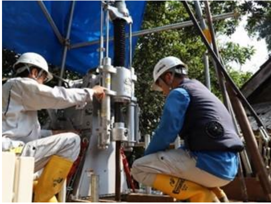
Pekerjaan pengeboran dengan metode pengeboran hibrida
