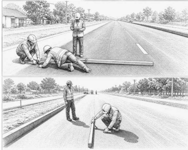
Gambar 13 - Pemeriksaan rata-rata permukaan perkerasan
