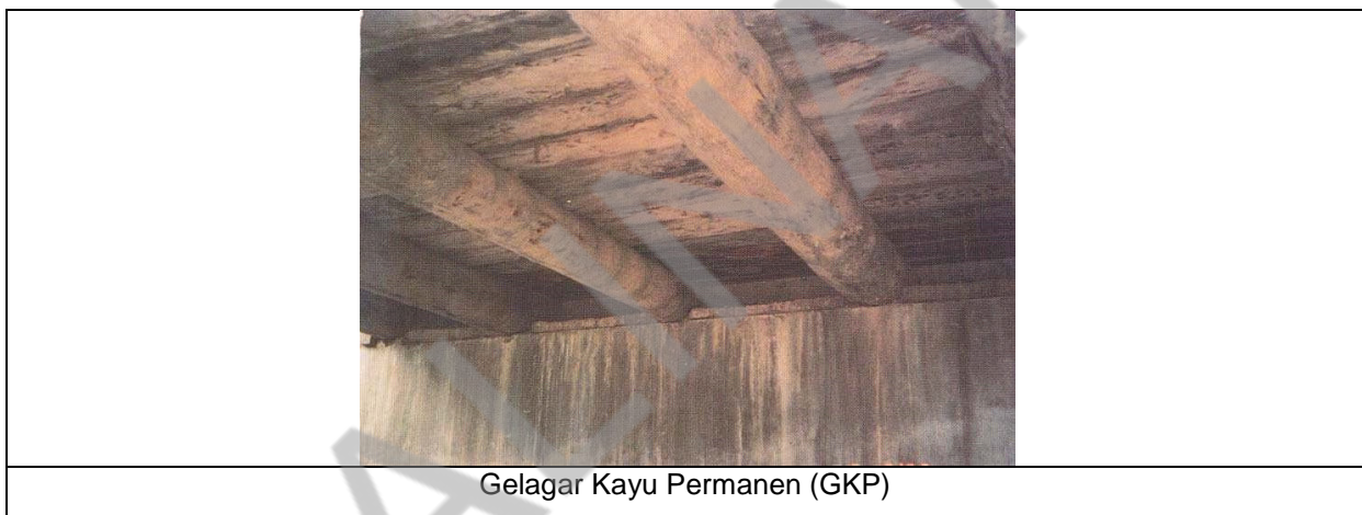
Gambar I. 5 Bangunan Atas Gelagar Kayu Permanen
