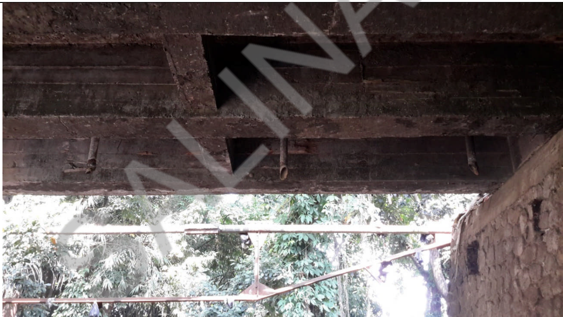
Pipa Cucuran yang Kurang Panjang
