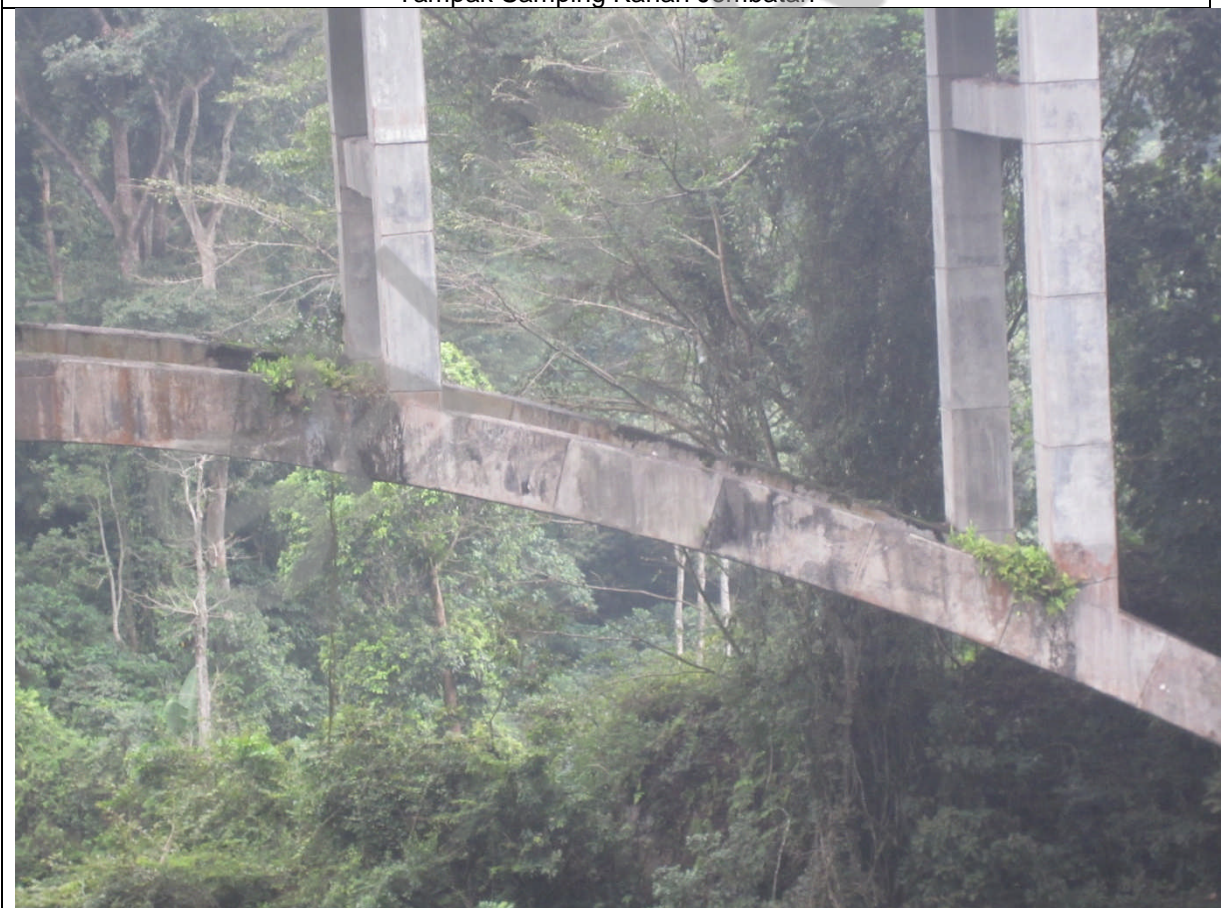
Kondisi Balok Pelengkung Jembatan
