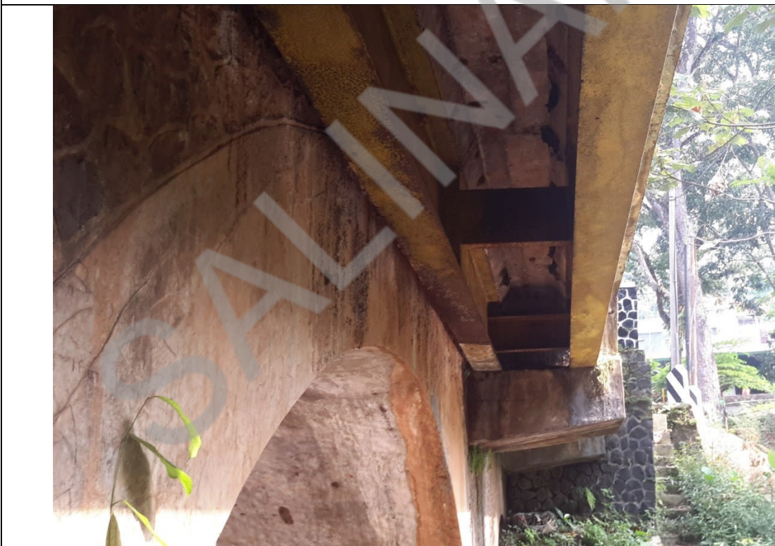
Tampak Bawah (terlihat pelebaran dengan gelagar baja)
