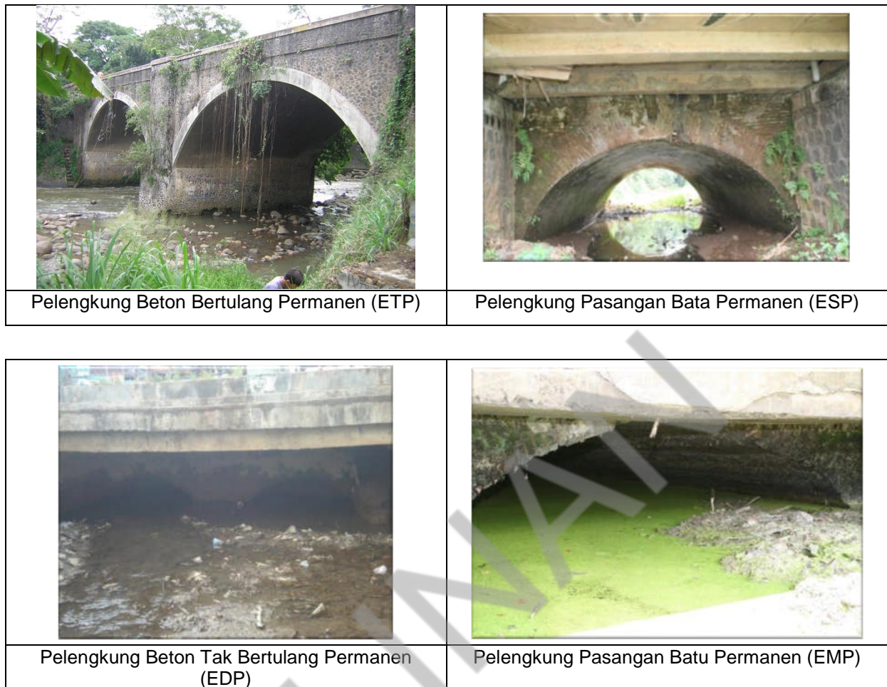
Gambar I. 10 Bangunan Atas Pelengkung
