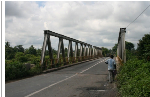
Rangka Baja Belanda Baru (RBP) (tanpa Batang Vertikal)
