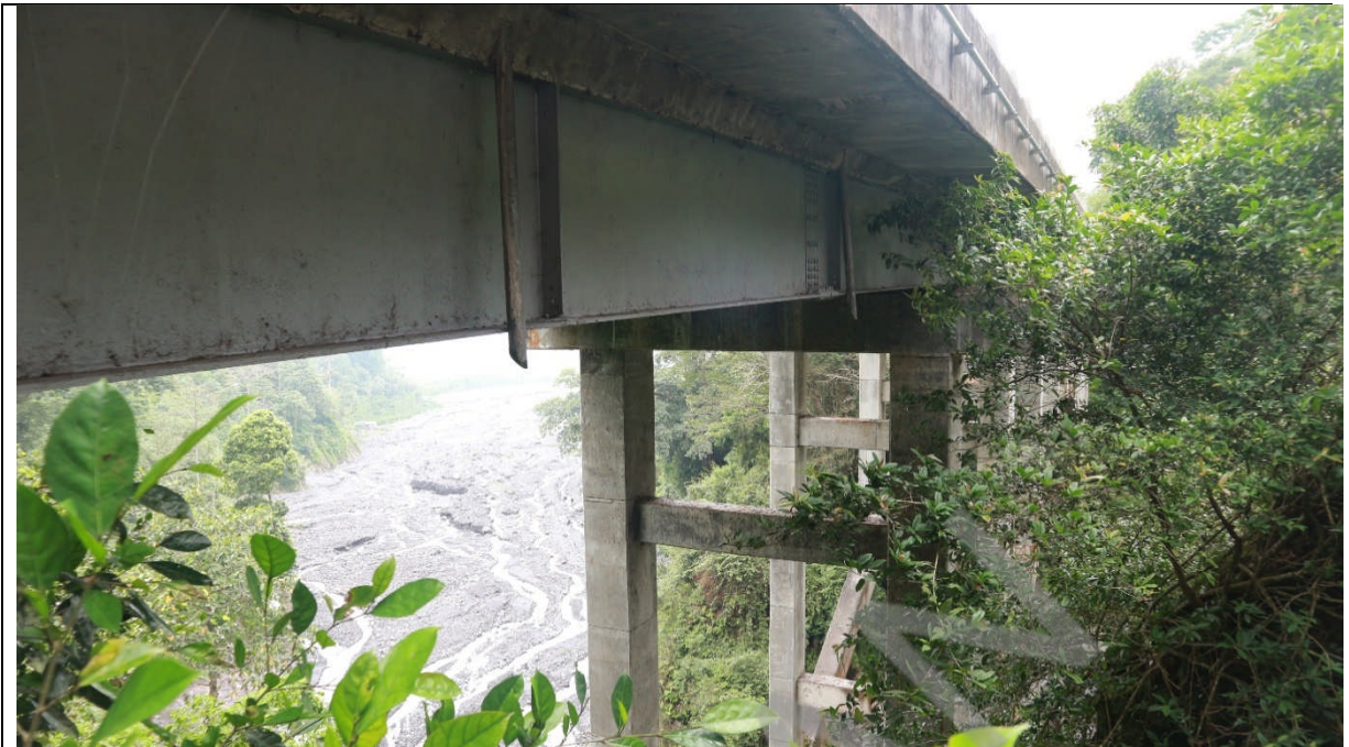
Tampak Gelagar Baja Komposit Jembatan
