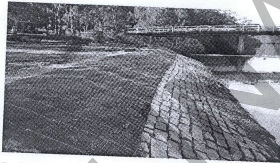
Contoh pelindung tebing sungai dengan Rivetmen beton.
