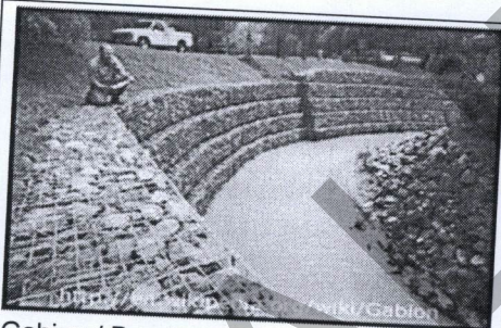
Gabion / Bronjong pencegah erosi
