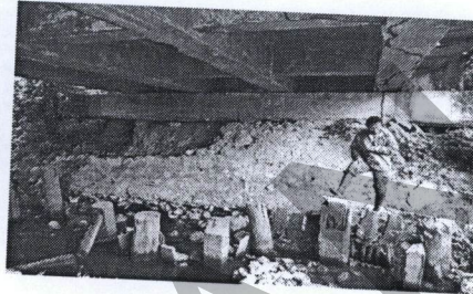
Gambar Gerusan pada Abutmen Jembatan
