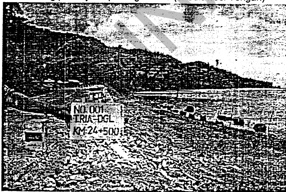
Gambar 3-2. Kasus kegagalan struktur kaki dari bangunan pengaman tebing pantai jenis tembok laut (di Sulawesi Tengah)
