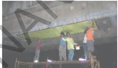
b) pelapisan serat dengan epoksi resin
