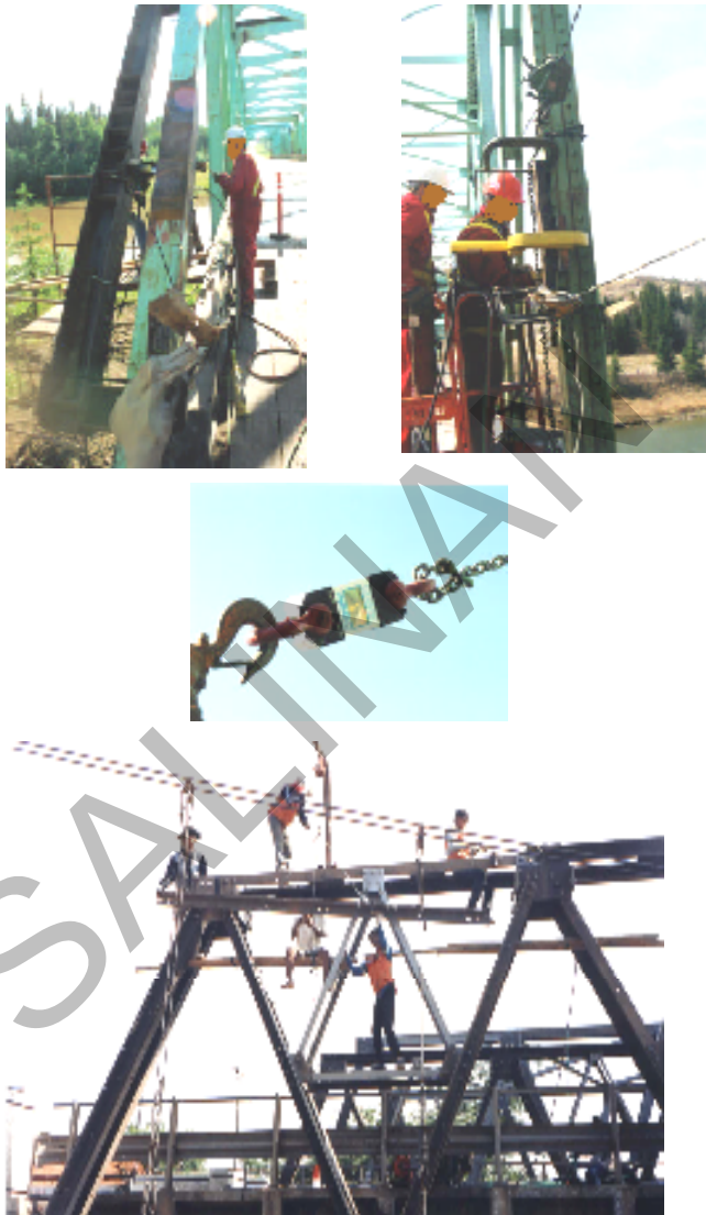
Gambar 13 Contoh Metode Pelepasan Batang dan Pemambahan Batang
