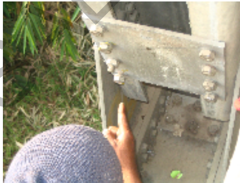
Gambar 2 Penggantian elemen profil I terbalik dengan profil kanal ganda pada batang diagonal jembatan rangka baja
