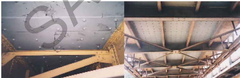
Gambar 17 Contoh Perkuatan Lantai dengan Steel Plate Bonding
