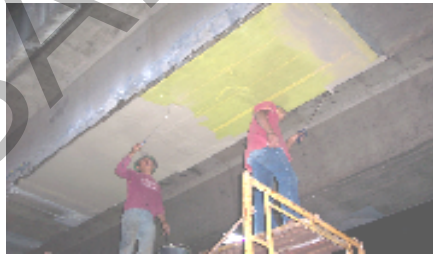
c) penutupan dengan bahan anti UV
