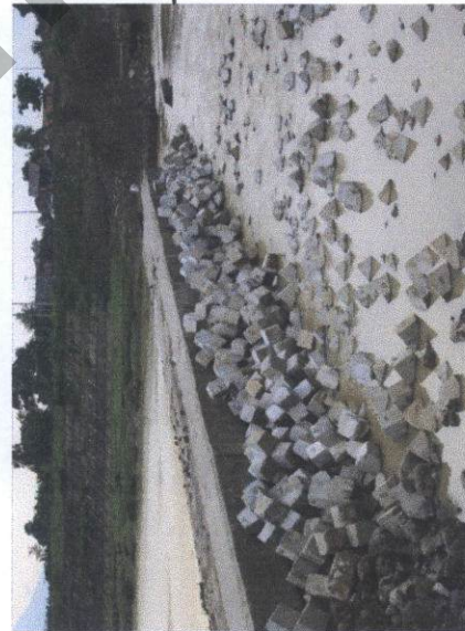
Contoh Tipikal Penerapan Blok Beton Kubus Kaki 6 : Disusun Acak di Sekitar Bangunan
