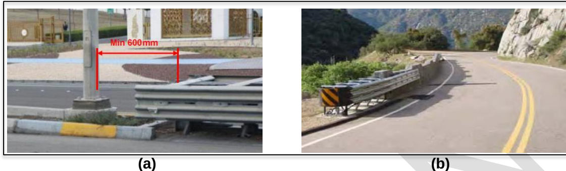
Gambar 15 - Jarak antara bagian belakang terminal dengan bantalan tabrakan dan objek bahaya jenis tunggal (a) dan jenis objek memanjang (b)
