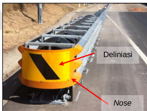
Gambar 9 - Komposit perangkat peredam benturan nose
