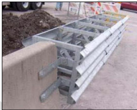
Gambar 4 - Pengaku pada pagar keselamatan
