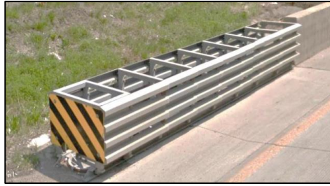
Gambar 1 - Contoh terminal dengan bantalan tabrakan
