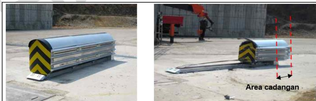
Gambar 14 - Sistem terminal dengan bantalan tabrakan sebelum tertabrak (a) dan setelah tertabrak (b)
