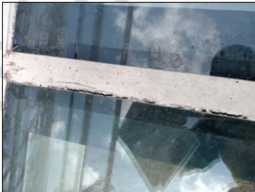
Gambar 29 - Kerusakan pada penutup sealant
