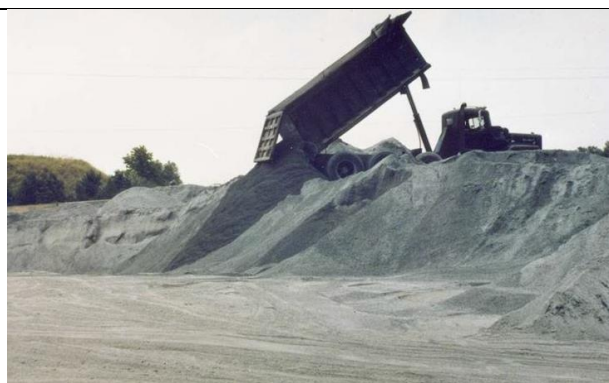
2.14 Agregat tidak ditambah ke stockpile secara berlapis potensi
