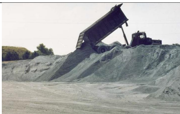
2.14 Agregat tidak ditambah ke stockpile secara berlapis; potensi segregasi
