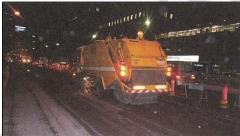
Gambar 71 – Pembersihan permukaan jalan (dengan road sweeper )
