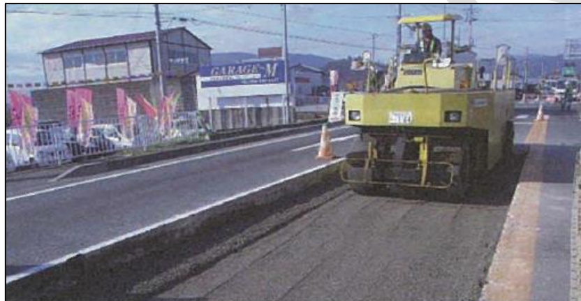
Gambar 65 – Konstruksi lapis fondasi (dengan mesin roller )
