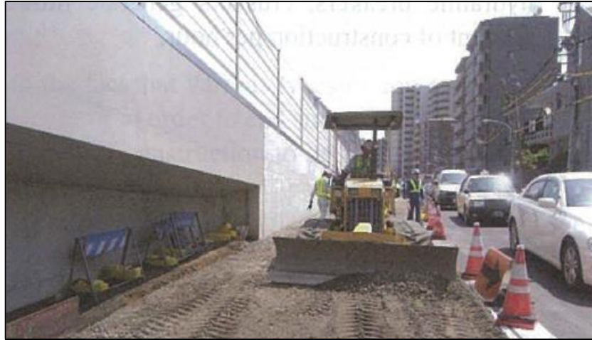
Gambar 64 – Konstruksi lapis fondasi (dengan mesin spreader )
