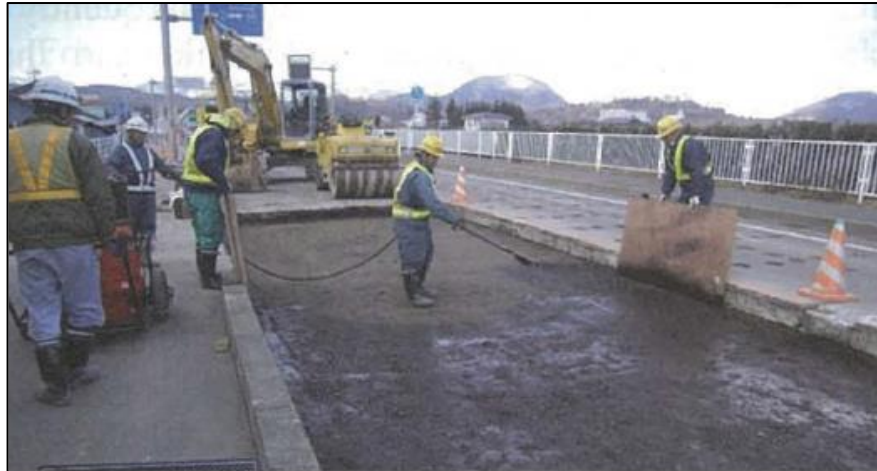
Gambar 67 – Aplikasi emulsi (dengan mesin sprayer )
