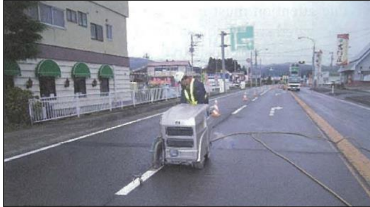
Gambar 59 – Pemotongan perkerasan
