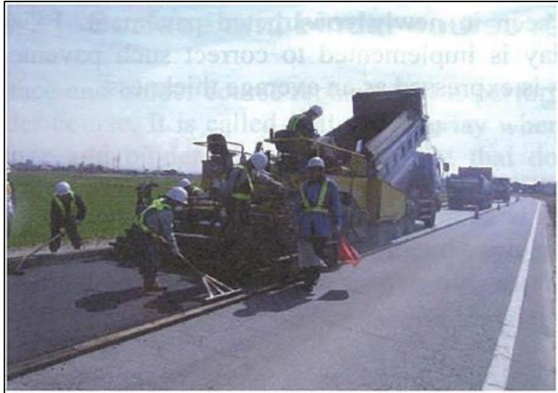
Gambar 73 – Overlay (dengan mesin/alat penghampar
