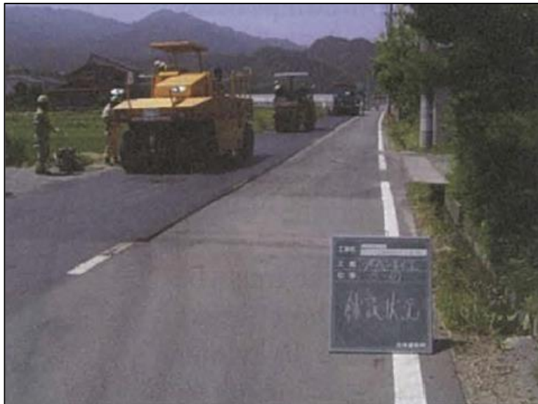
Gambar 47 – Pekerjaan lapis tipis beton aspal ( carpet-coat )
