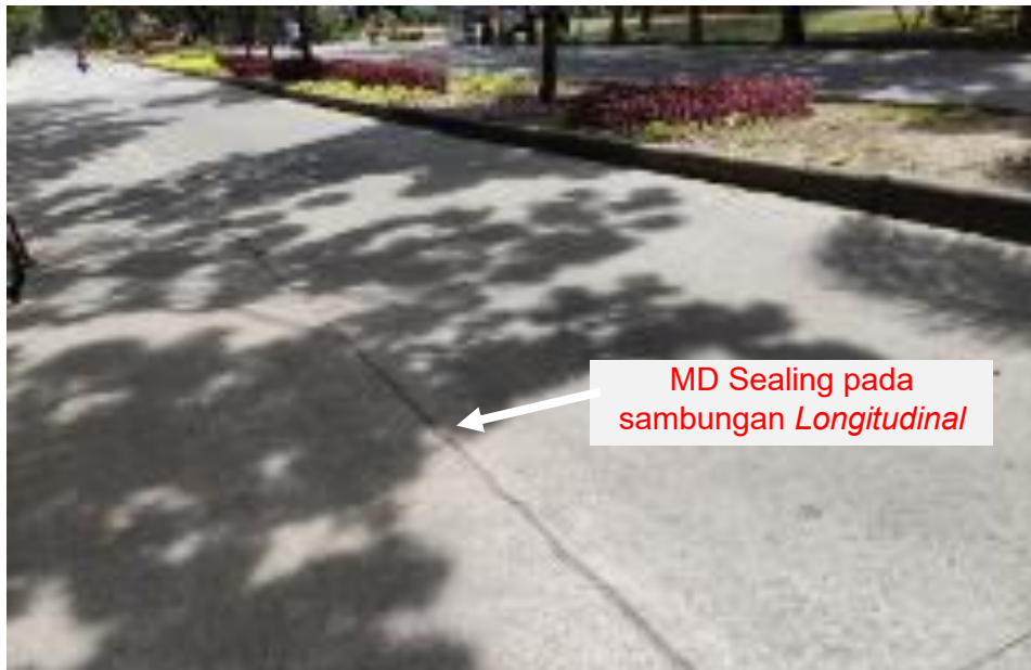
Gambar P – Crack sealant (sebelum) di Kota Tebing Tinggi
