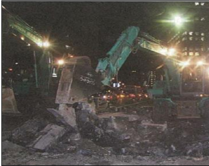
Gambar 61 – Pembongkaran perkerasan (dengan mesin crusher )
