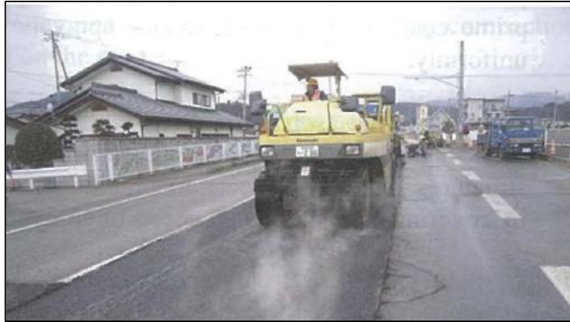
Gambar 70 – Pemadatan (dengan roller ban pneumatik)
