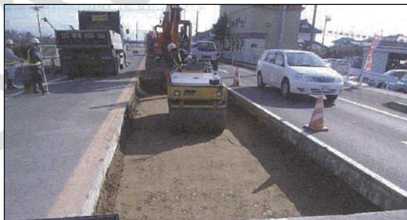
Gambar 63 – Konstruksi subgrade (dengan mesin roller )
