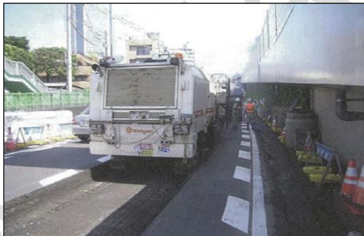
Gambar 60 – Pembongkaran perkerasan (dengan mesin pemotong jalan)
