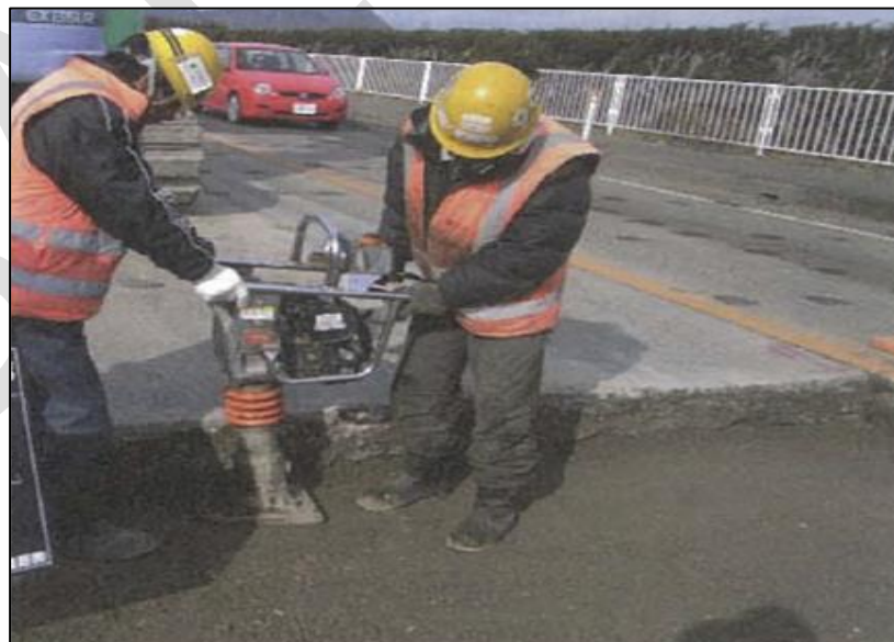
Gambar 66 – Konstruksi lapis fondasi (pemadatan pada tepi)
