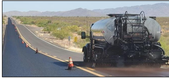
Gambar 41 – Implementasi fog seal
