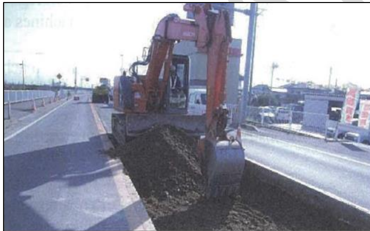
Gambar 62 – Ekskavasi perkerasan
