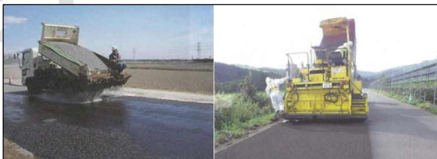
Gambar 42 – Pekerjaan chip seal (kiri); Pekerjaan chip seal menggunakan mesin khusus (kanan)
