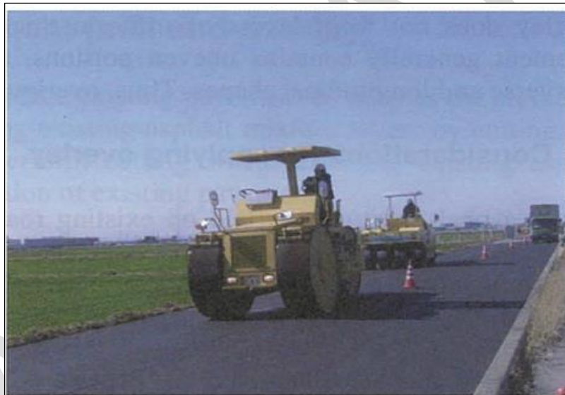
Gambar 74 – Overlay (dengan roller)
