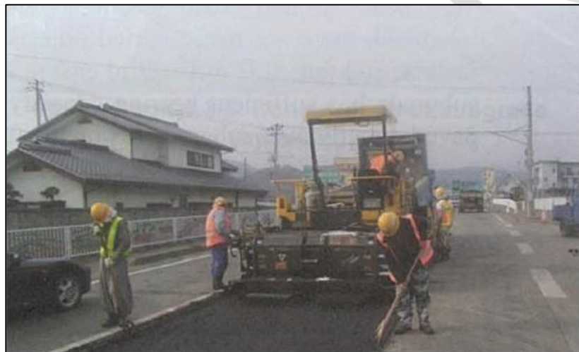
Gambar 68 – Mesin paving (penghamparan)
