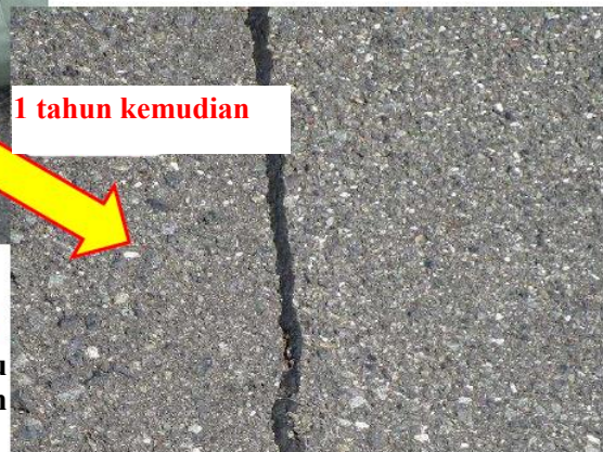
Gambar M – Status setelah penggunaan MD seal
