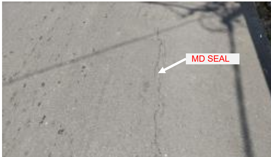
Gambar N – Crack sealant (sebelum) di Kota Sukabumi
