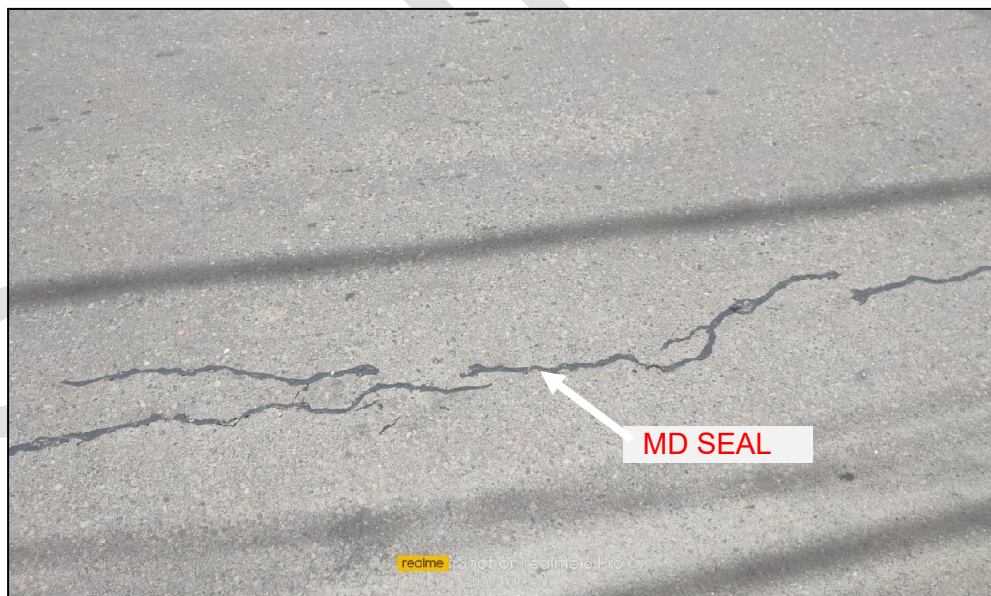
Gambar O – Crack sealant (setelah 1 bulan) di Kota Sukabumi
