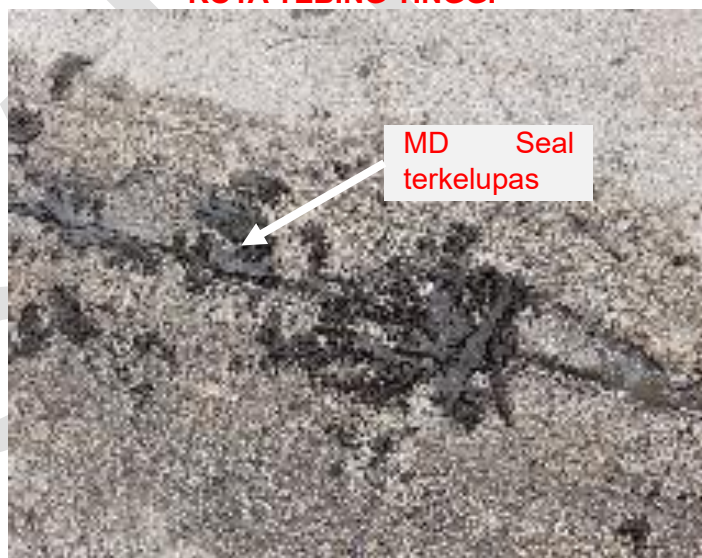
Gambar Q – Crack sealant (setelah 1 bulan) di Kota Tebing Tinggi
