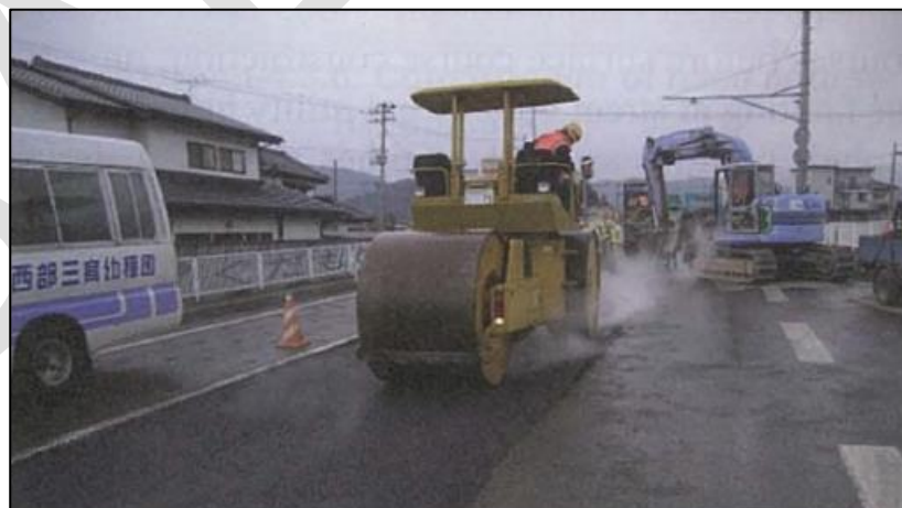
Gambar 69 – Pemadatan (dengan roller makadam )
