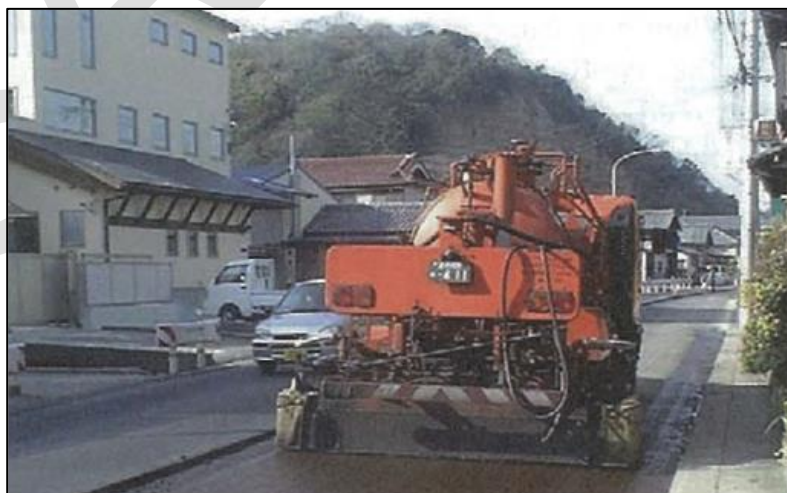
Gambar 72 – Pengaplikasian tack coat (dengan mesin distributor )
