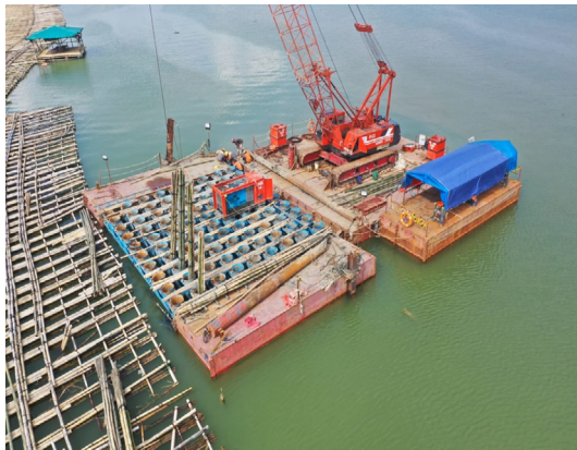
Gambar 7. Pemancangan cerucuk bambu (Sumber: Metode pelaksanaan pekerjaan , Satker PJT Semarang-Demak, 2023)
