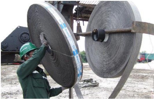
Gambar 17. Pemasangan PVD ke PVD rig (Sumber: Work Method Statement , Satker PJT Semarang-Demak, 2023)
