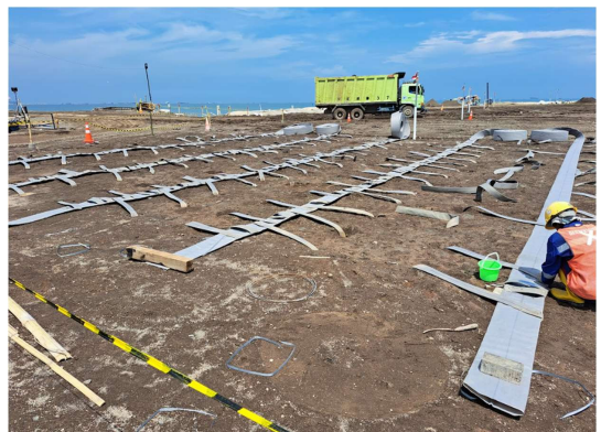
Gambar 19. Penyambungan PVD dan PHD (Sumber: Work Method Statement , Satker PJT Semarang-Demak, 2023)
