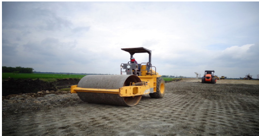
Gambar 26. Pemadatan timbunan hingga kepadatan 100% (Sumber: Metode pelaksanaan pekerjaan, Satker PJT Semarang-Demak, 2023)
