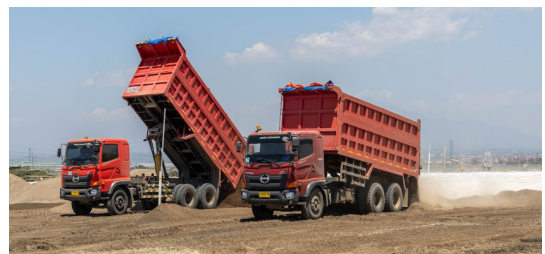
Gambar 25. Pendatangan material timbunan dari quarry (Sumber: Metode pelaksanaan pekerjaan, Satker PJT Semarang-Demak, 2023)
