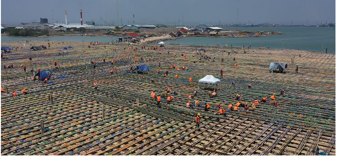
Gambar 10. Penyusunan matras bambu (Sumber: Metode pelaksanaan pekerjaan, Satker PJT Semarang-Demak, 2023)
