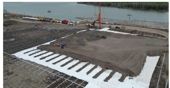
Gambar 22. Penimbunan pasir lapis 2 di atas geotekstil 1200 kN/m transversal (Sumber: Work Method Statement , Satker PJT Semarang-Demak, 2023)
