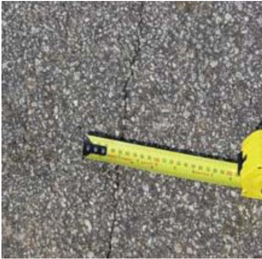
Gambar 1. Retak refleksi berukuran kecil
