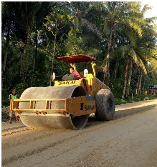
Gambar 1. Pemadatan tanah dengan vibro roller
