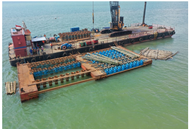
Gambar 7. Pemancangan cerucuk bambu (Sumber: Metode pelaksanaan pekerjaan , Satker PJT Semarang-Demak, 2023)
