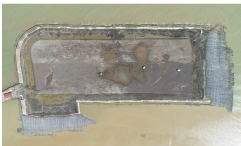
Gambar 15. Hasil Uji Lapangan Timbunan untuk Platform Lantai Kerja pada Lapis Kedua (Sumber: Tim Teknis Full Scale Trial Embankment Pembangunan Jalan Tol Semarang-Demak, 2023)
