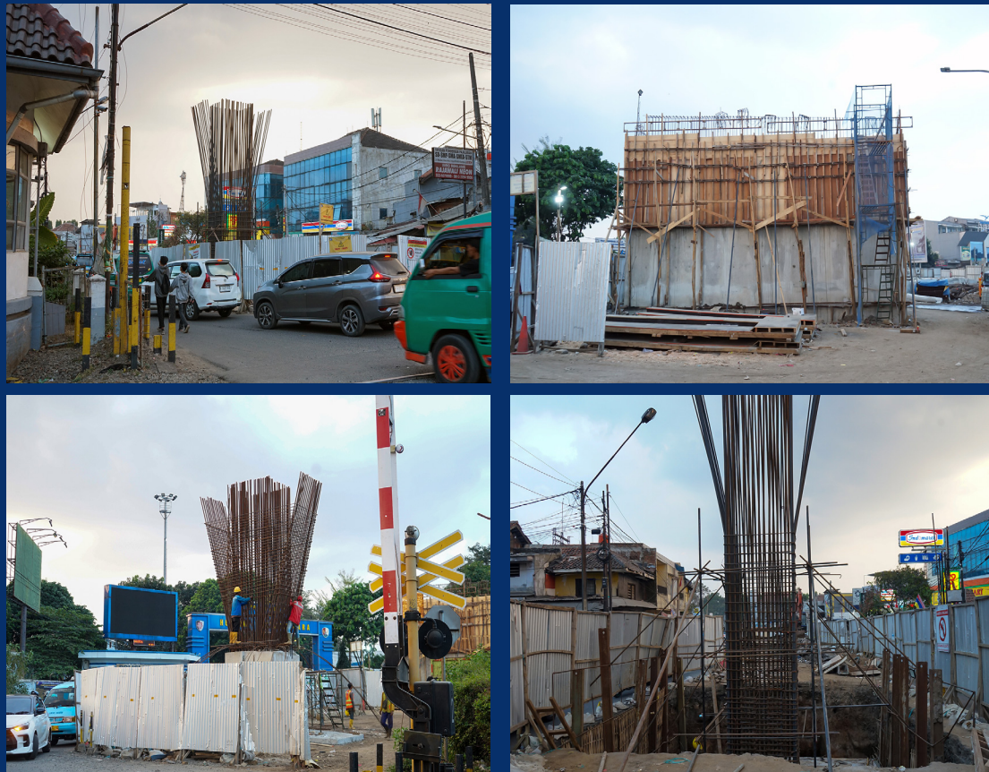
Foto-foto, pekerjaan struktur Simpang Susun Jalan Abdurahman Saleh – Jalan Garuda (Nurtanio) Kota Bandung
