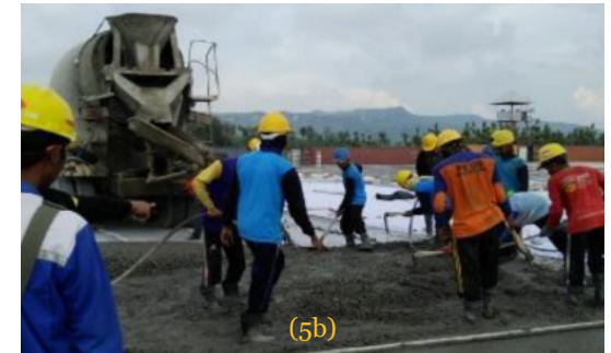
Gambar (5a) dan (5b). Proses Pengecoran dan Penghamparan
