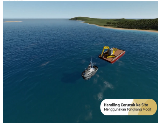
Gambar 7. Pengangkutan Cerucuk Bambu ke Lokasi (Sumber: Video Metode Konstruksi Trial Embankment, PT PPSD, 2021)
