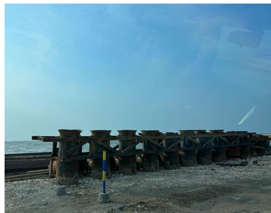
Gambar 8. Mal Baja Untuk Memandu Letak
