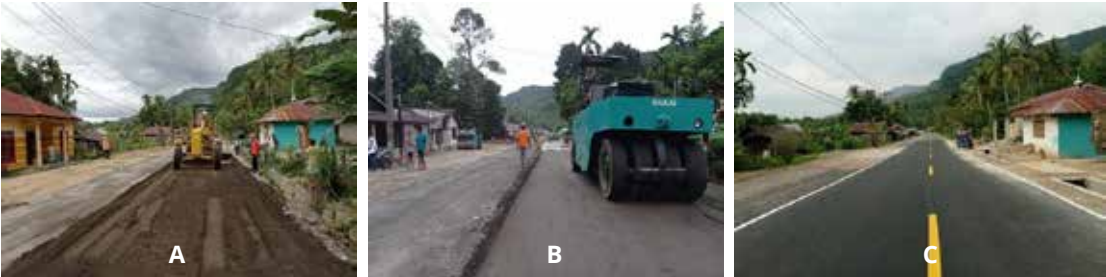
Gambar 6. Dokumentasi penghamparan (a), pemadatan (b), dan kondisi terkini (c) lapis fondasi abu batubara semen
