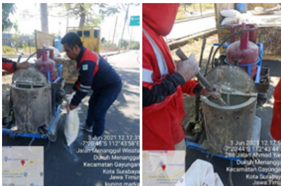
Gambar 3. Proses Persiapan Campuran Cat Marka Jalan
