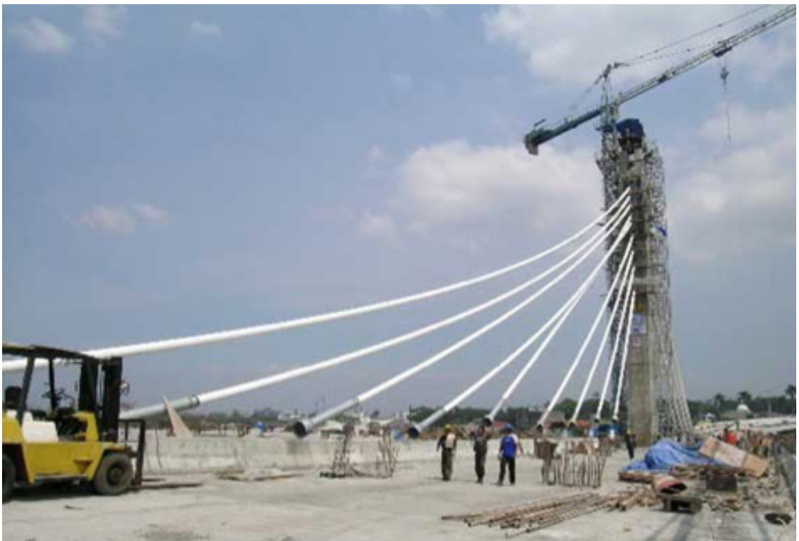
Gambar 3. Pembangunan Jembatan Layang Prof. Dr. Mochtar Kusumaatmadj (Sumber: Freyssinet Indonesia, 2016) a
