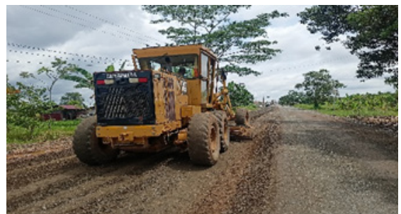
Gambar 6. Pembentukan Badan Jalan dengan Motor Grader (Sumber: PPK 2.2 Prov. Kalsel, 2021)
