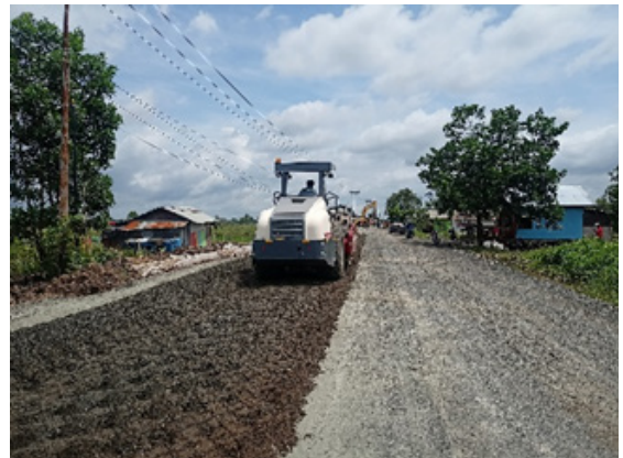
Gambar 5. Pemadatan Awal Dilakukan dengan Padfoot Roller (Sumber: PPK 2.2 Prov. Kalsel, 2021)
