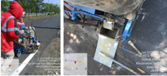
Gambar 6. Proses Pengecatan Marka Jalan
