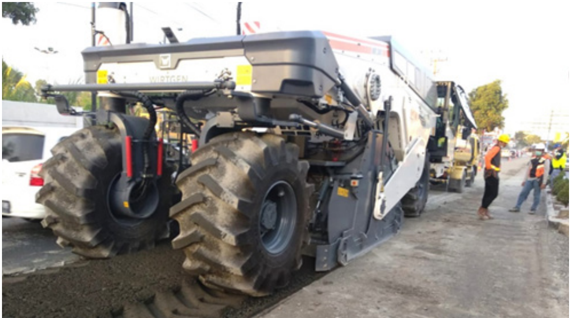
Gambar 1. Proses Penanganan Jalan di Ruas A. Yani Banjarbaru menggunakan metode CTB ( Foto : PPK 2.1 Prov Kalsel)
