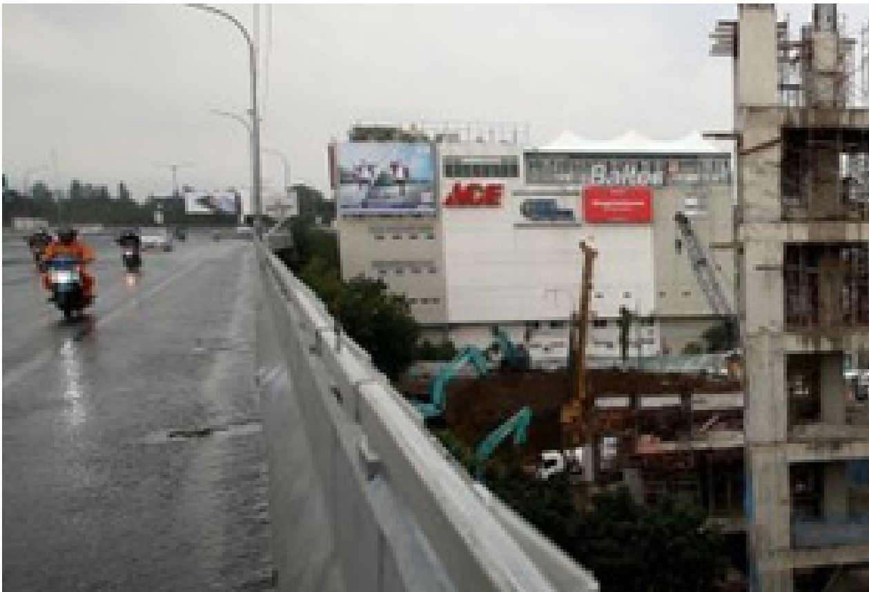
Gambar 6. Pembangunan Rumah Deret di Daerah Taman Sari Kota Bandung (Sumber: Dok. Siswanti, 2021)
