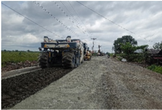
Gambar 3. Perbaikan Jalan Marabahan - Margasari menggunakan Metode CTB (Sumber: PPK 2.2 Prov. Kalsel, 2021)
