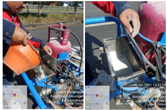
Gambar 4. Proses Persiapan Campuran Cat Marka Jalan
