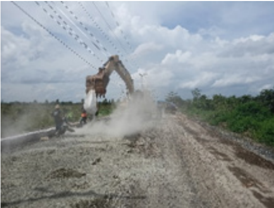
Gambar 4. Material Semen Digelar Dengan Semen Cement Spreader (Sumber: PPK 2.2 Prov. Kalsel, 2021)
