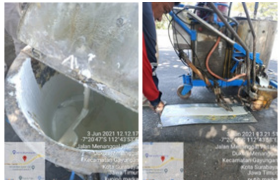
Gambar 5. Cat Marka yang Telah Mencair dan Proses Pengaplikasian Pada Plat Besi
