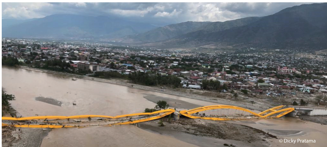
Gambar 4. Kerusakan Berat Jembatan Kuning Palu Sulawesi Tengah Akibat Gempa Berkekuatan 7,4 SR (Sumber: https://detakpos.com )
