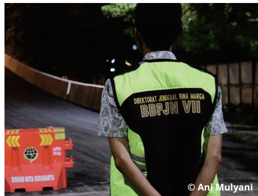
Gambar 5. Pelaksanaan Pekerjaan Perkerasan Flyover Manahan
