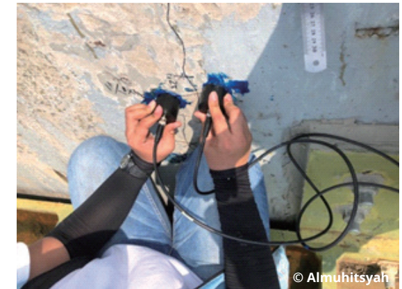
Gambar 11. Pelaksanaan Pengujian Retak Beton Dengan Alat Ultrasonik
