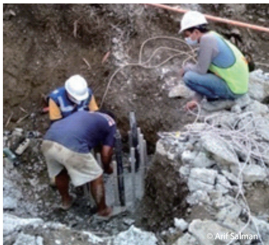
Gambar 18. Contoh Pengujian Sonic Logging Pada Pondasi Bore Pile
