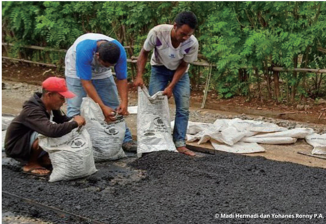
Gambar 4. CPHMA dalam Kemasan Kantong Saat Dihamparkan Secara Manual
