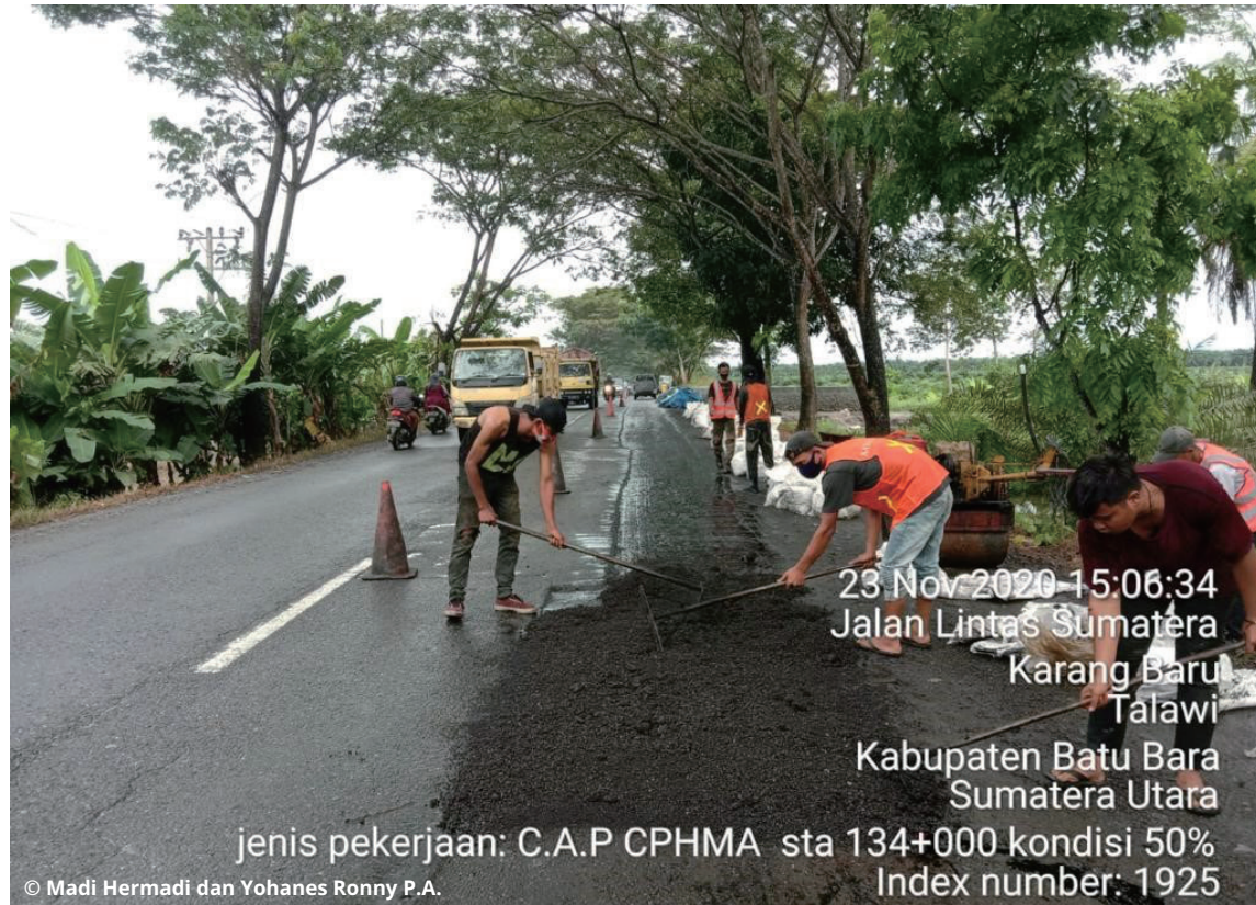
Gambar 6. Pelaksanaan Penambalan Jalan dengan CPHMA Secara Manual.
