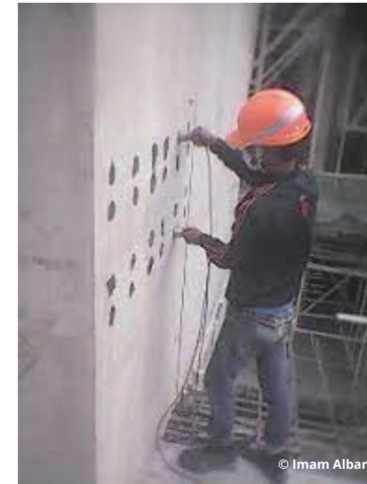
Gambar 7. Posisi Probe UPV Pada Uji Retak Beton
