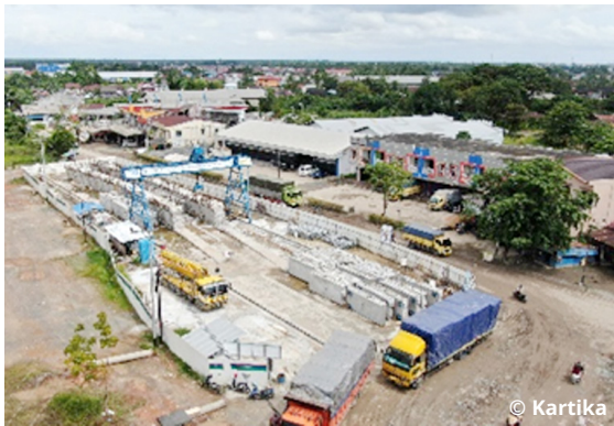
Gambar 3. Aktivitas Pengerjaan Penggantian Jembatan Sei Alalak
