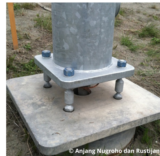
Gambar 4 Contoh Modifikasi Struktur Dari Patok Jalan Menjadi Breakaway (Sumber: transpo.com)
