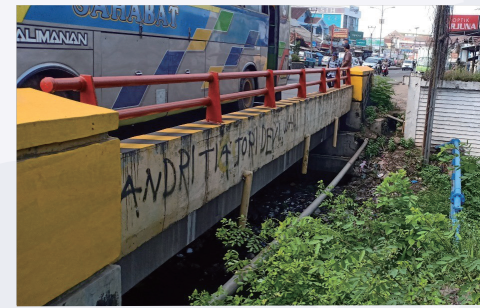
Sumber : Jembatan Kaliwaru A
