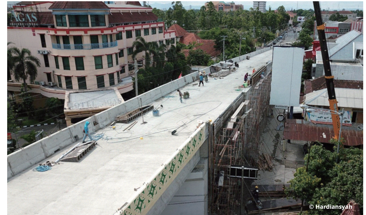
Gambar 3. Proses pembangunan Flyover Manahan sisi Jalan DR. Moewardi
