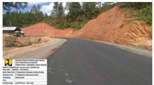
Gambar 5. Perkerasan Jalan Hot Mix Asbuton B 50/30 di Sulawesi Tenggara
