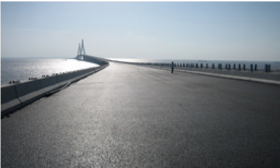
Gambar 6. Perkerasan Jalan Hot Mix Asbuton B 5/20 di Jiangshu China Tahun 2010
