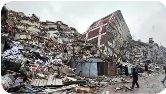
Gambar 12. Reruntuhan Bangunan Pasca Gempa dapat sebagai Sumber Beton Daur Ulang
