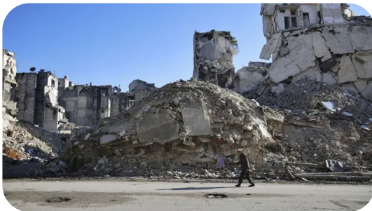
Gambar 13. Reruntuhan Bangunan Pasca Perang dapat sebagai Sumber Beton Daur Ulang
