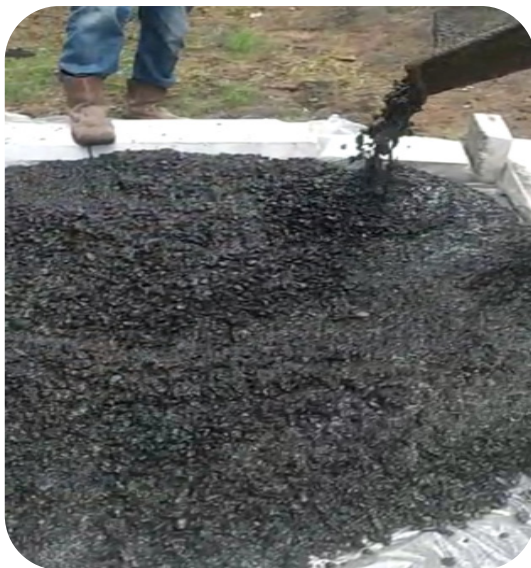
Gambar 2. Uji Coba Beton TSP untuk Jalan Beton Sumber: Bambang Daryoso
