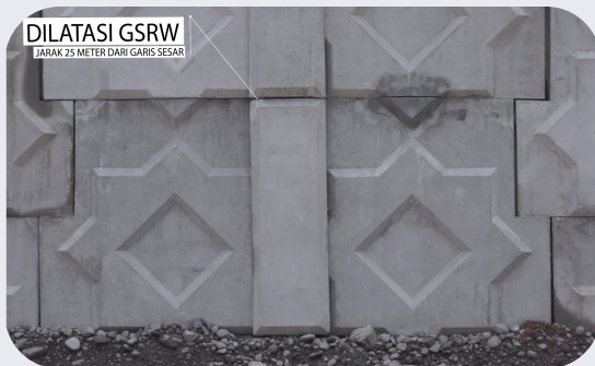
Gambar 11. Dinding Penahan Tanah dengan Dilatasi
