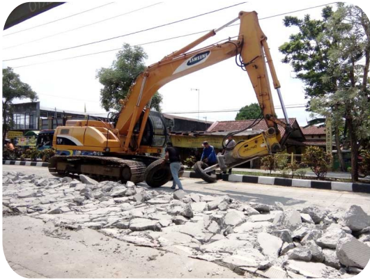
Gambar 11. Bongkahan Jalan Beton dapat sebagai Sumber Beton Daur Ulang
