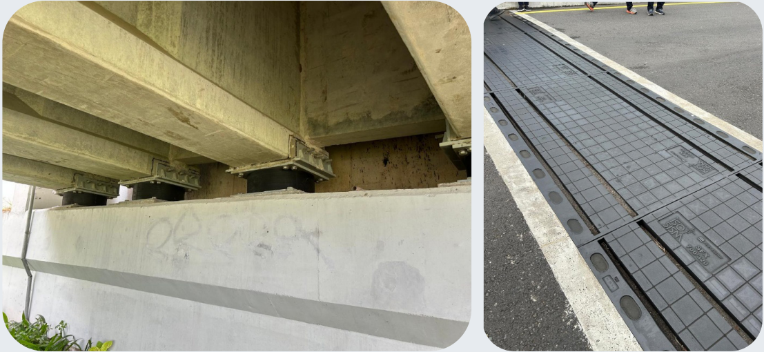
Gambar 12. LRB dan Expansion Join
