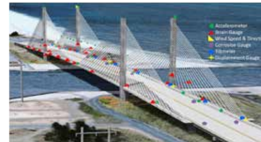
Gambar 4. Penempatan berbagai jenis sensor pada sebuah jembatan (sumber: Al-Khateeb, 2015).
