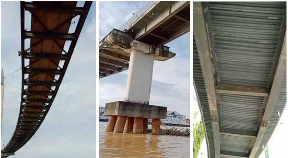
Gambar 7. Bangunan Atas Jembatan (Sistem Lantai dan Gelagar/ Girder ) (Sumber: dokumentasi pribadi)
