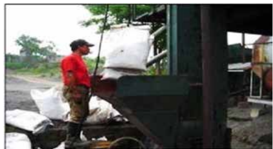
Gambar 15. Pemasukan Asbuton B 5/20 di AMP Melalui Silo Filler
