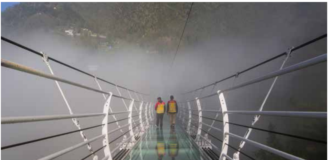
Gambar 3. Struktur Baja Galavanis dan Lantai Kaca Berlaminasi sumber foto: Kompu DJBM
