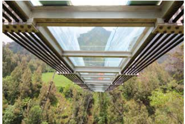
Gambar 2. Penampakan Lantai Kaca dengan Lapisan SGP sumber foto: Kompu DJBM
