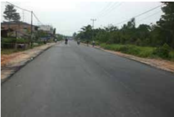
Gambar 17. Perkerasan Jalan Asbuton B 5/20 di Jalan Nasional di Riau (2009)
