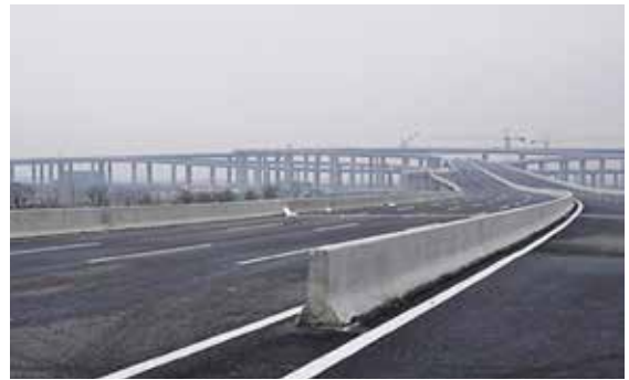
Gambar 4. Perkerasan Jalan Dengan Campuran Beraspal Panas Asbuton B 5/20 di Anhui Tiongkok Tahun 2012
