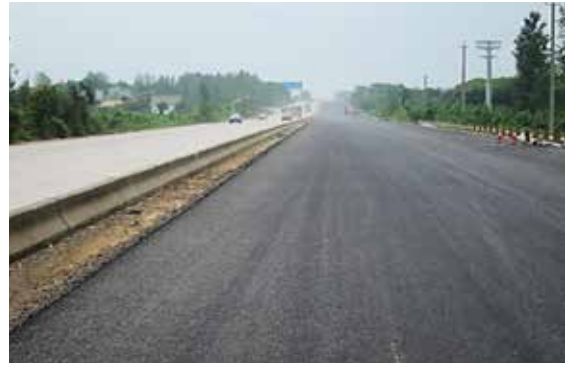
Gambar 3. Perkerasan Jalan dengan Campuran Beraspal Panas Asbuton B 5/20 di Shanghai Tiongkok Tahun 2010
