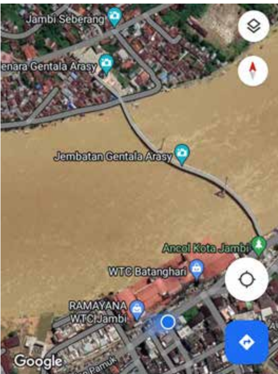
Gambar 5. Jembatan Gentala Arasy tampak atas (Sumber: Google Maps)
