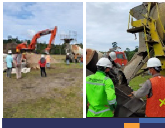
Gambar 4. Proses Pencampuran FABA
