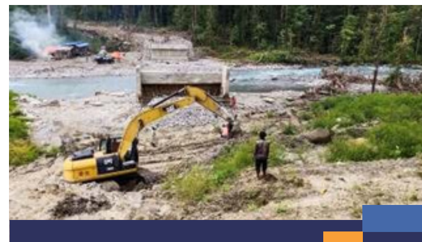
Sumber: Bahan Monitoring PPK 5.2 Gambar 2. Foto Rangka Jembatan Kali Yegi (Tahap II)
