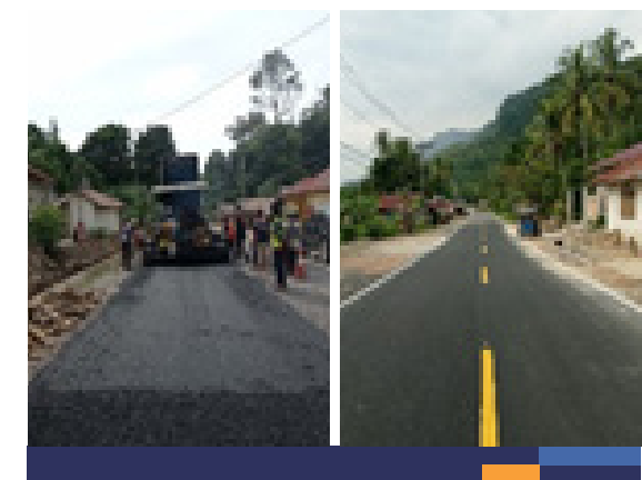
Gambar 7. Pekerjaan Lapis Beraspal
