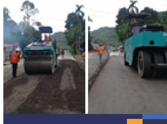
Gambar 6. Proses Pemadatan
