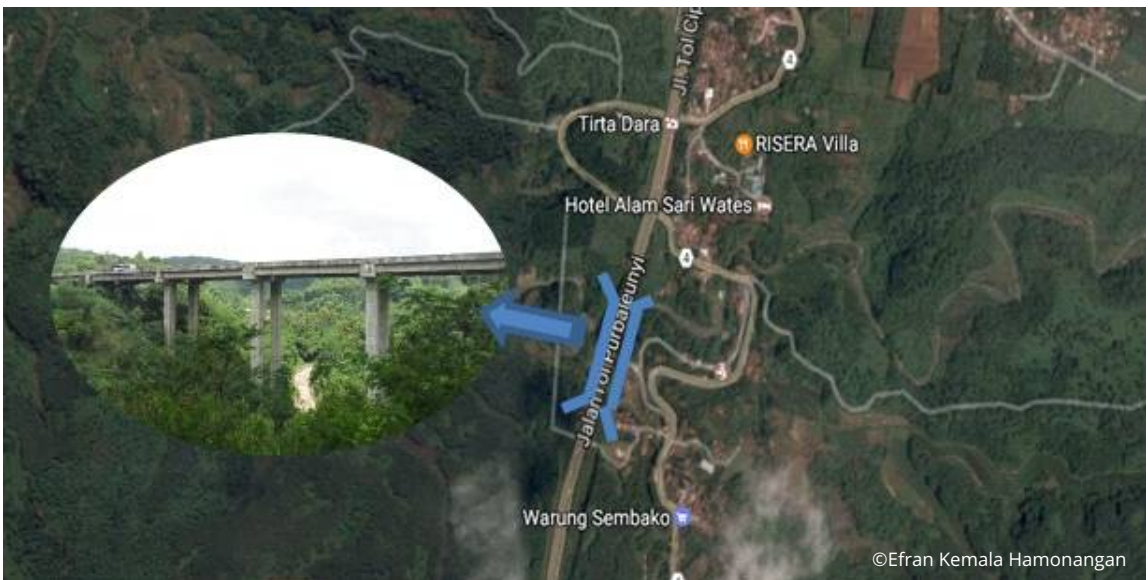
Gambar 1. Lokasi dan Foto Jembatan Cisomang
