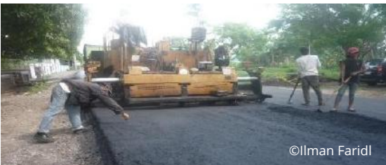
Gambar 7. campuran beraspal panas menggunakan asbuton butir B 5/20 (Gorontalo 2006)
