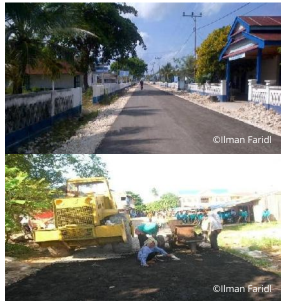
Gambar 13. Lapis Tipis Asbuton Butur (Butur Seal)
