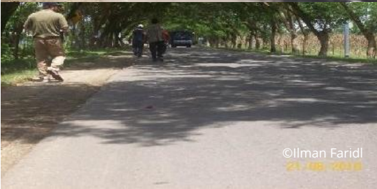
Gambar 7. campuran beraspal panas menggunakan asbuton butir B 5/20 (Gorontalo 2006)
