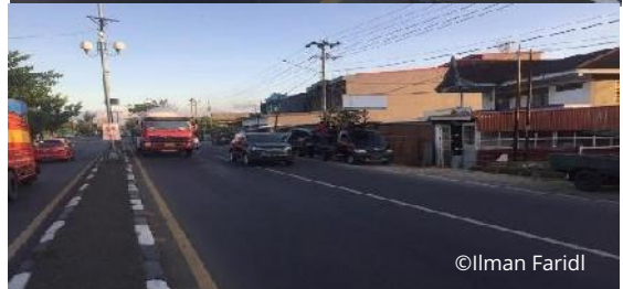
Gambar 10. Campuran beraspal panas menggunakan asbuton murni (Makassar 2019)
