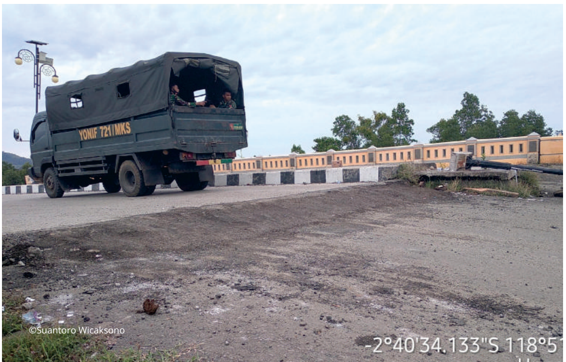
Gambar 6. Oprit Jembatan Losa 1
