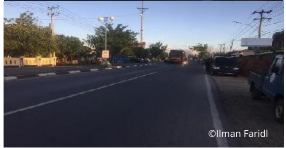
Gambar 9. Campuran beraspal panas menggunakan asbuton pracampur (Makassar 2019)
