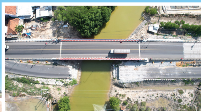
Foto: Dok. Ditjen Bina Marga
