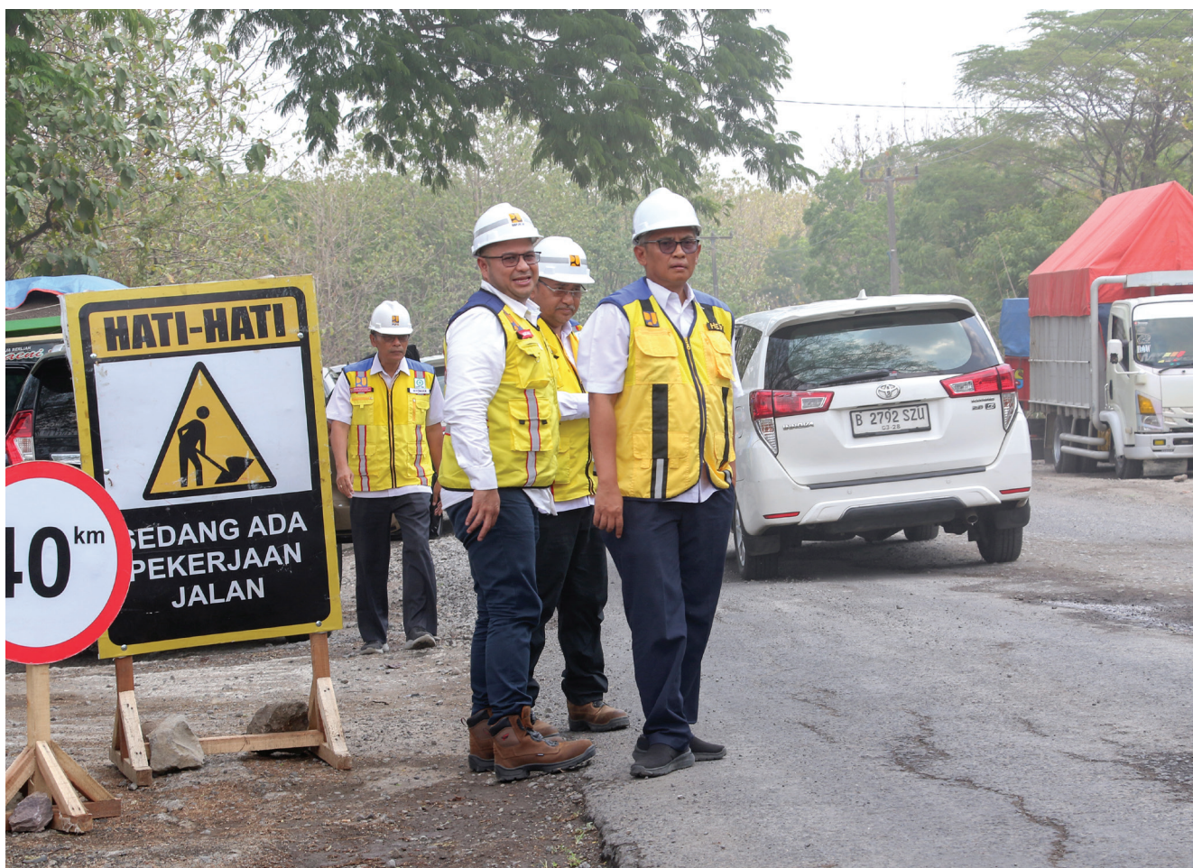
Foto: Dok. Ditjen Bina Marga
