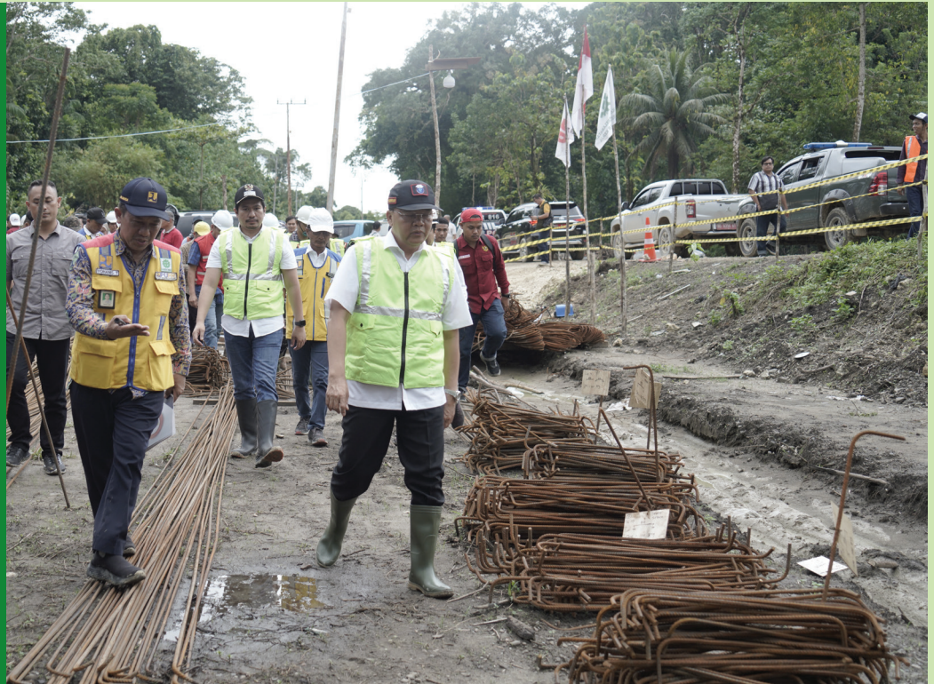
Foto: Dok. Ditjen Bina Marga
