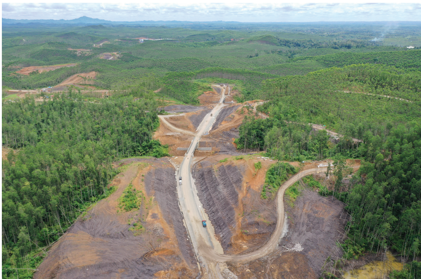
Foto: Dok. Ditjen Bina Marga
