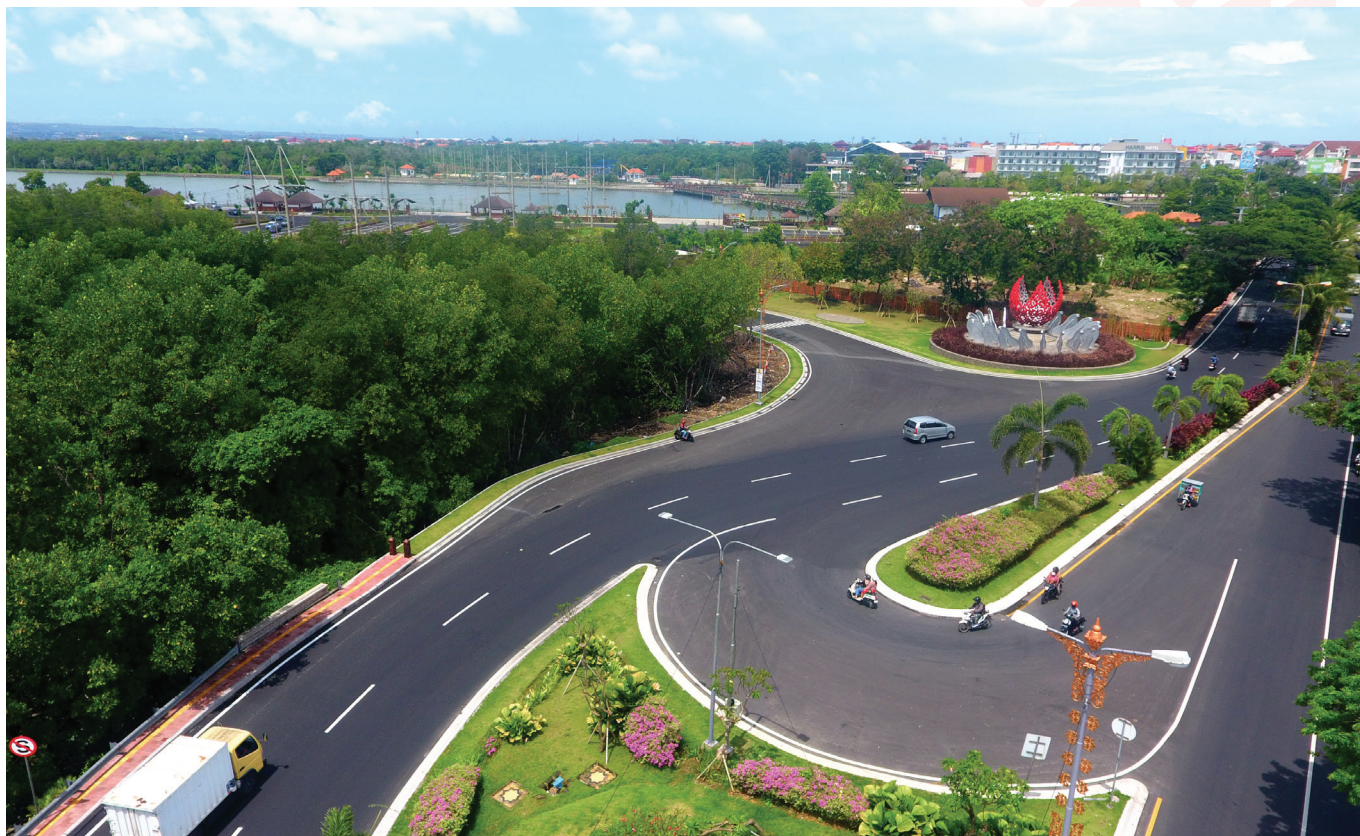
Foto: Dok. Ditjen Bina Marga
