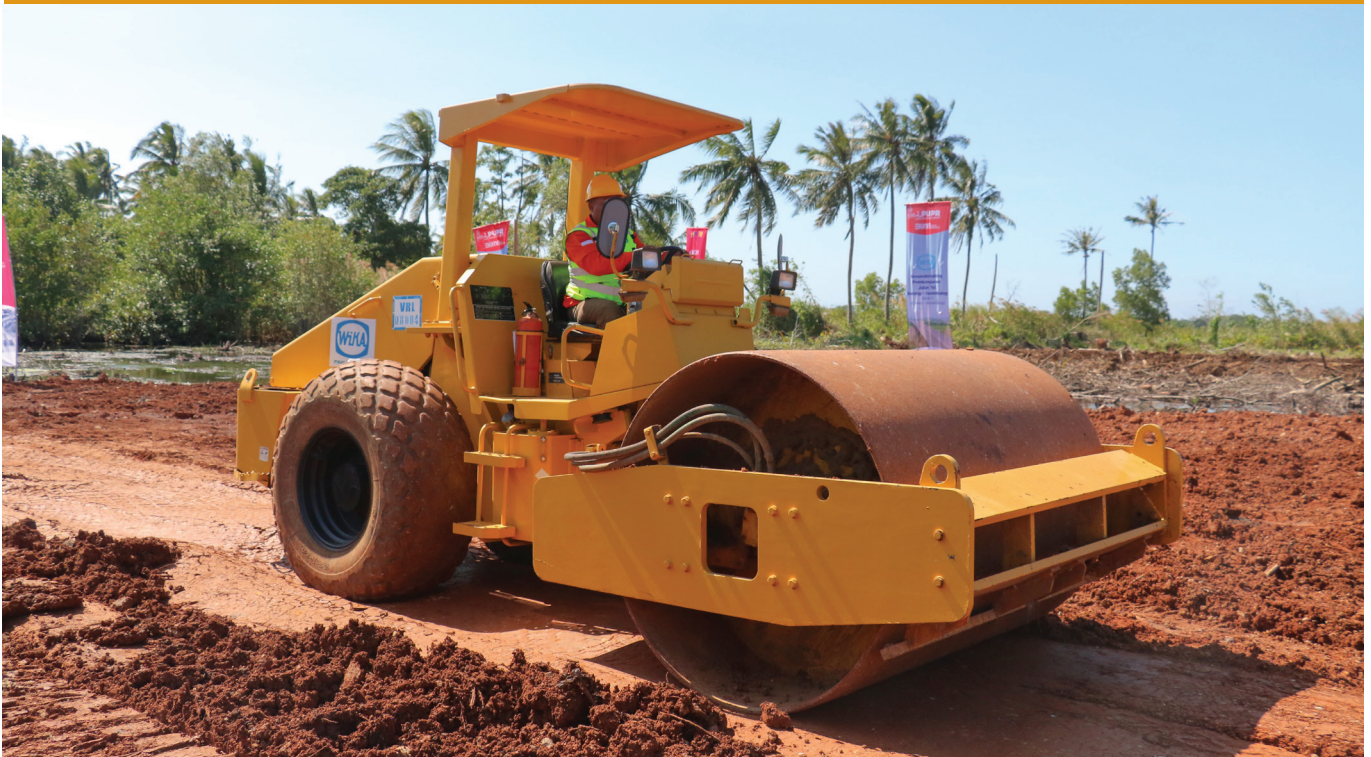
Foto: Dok. Ditjen Bina Marga
