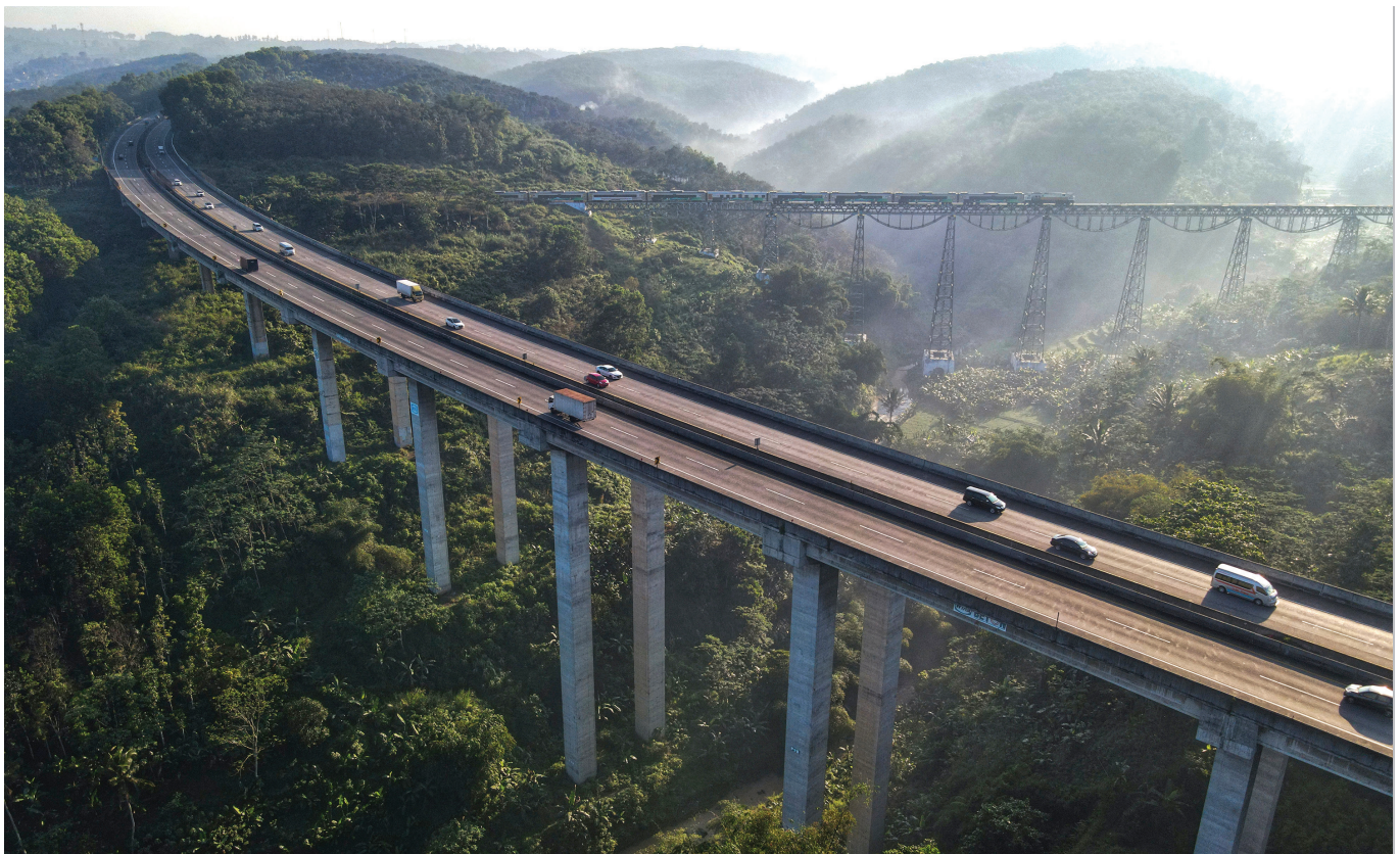
Foto: Aceng Sofian - Tol Jembatan Cikubang Cipatat Kab. Bandung Barat
