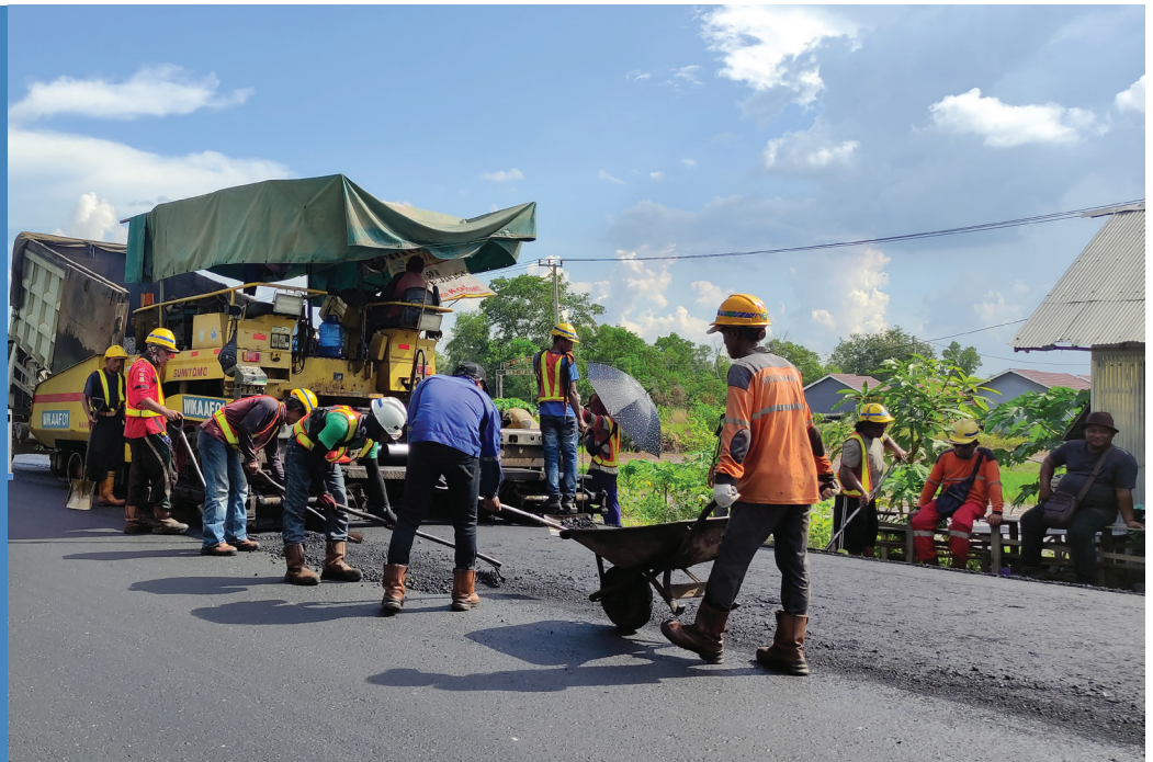
Foto: Dok. Ditjen Bina Marga
