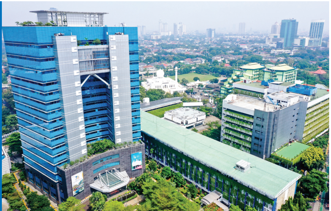
Foto: Dok. Ditjen Bina Marga
