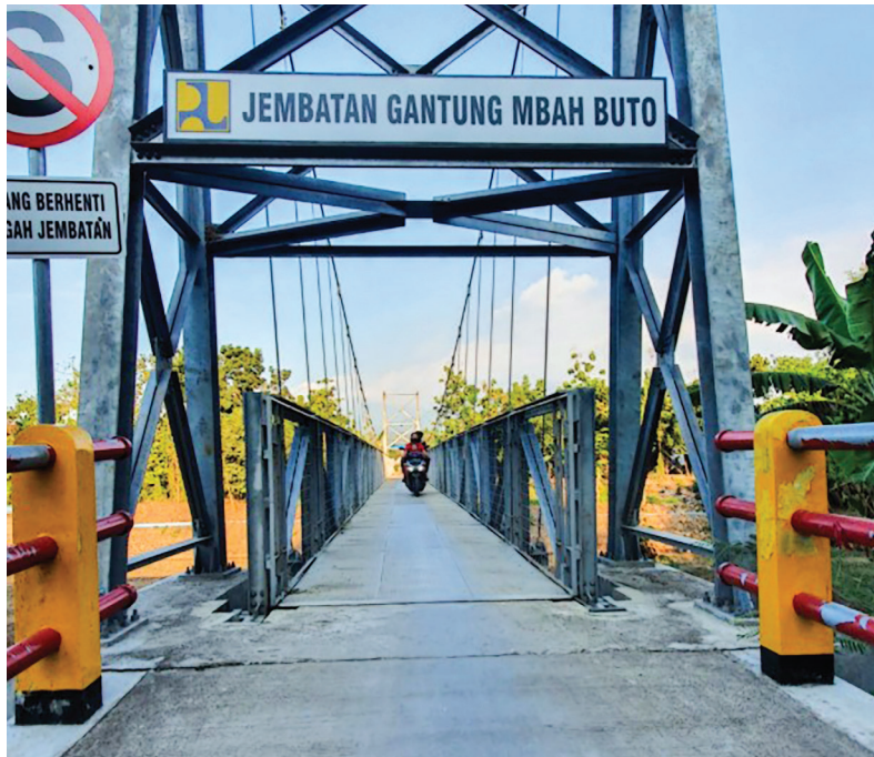
Foto: Dok. Ditjen Bina Marga
