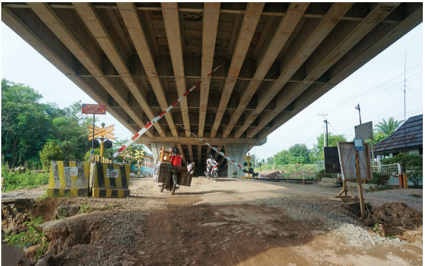
Foto: Dok. Ditjen Bina Marga
