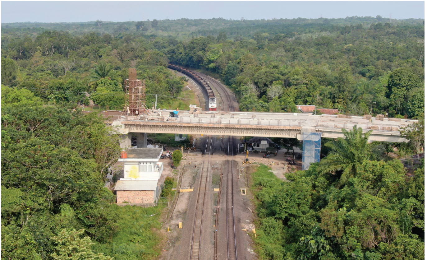
Foto: Dok. Ditjen Bina Marga
