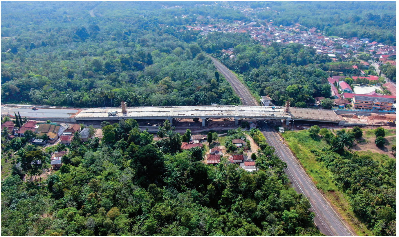
Foto: Dok. Ditjen Bina Marga
