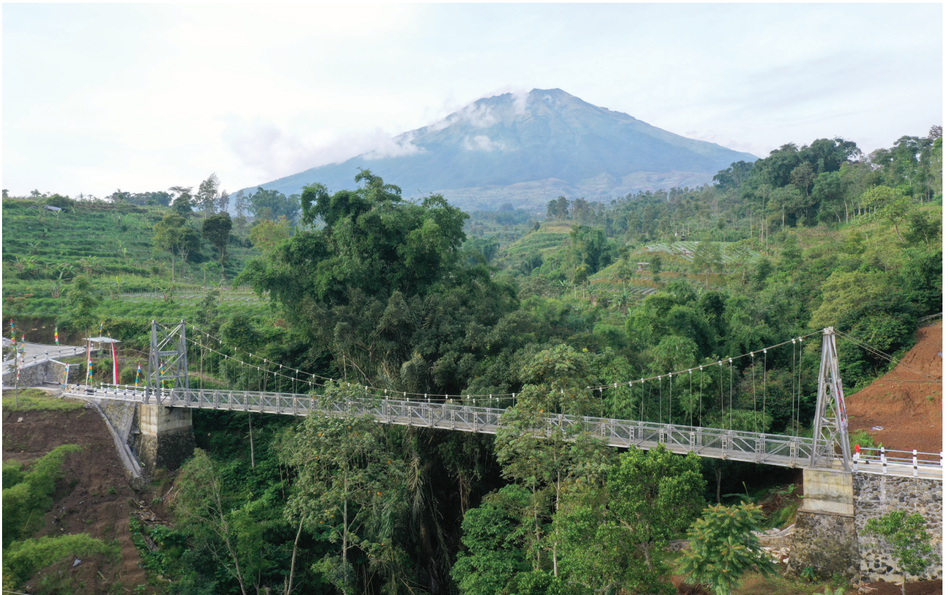
Foto: Dok. Ditjen Bina Marga
