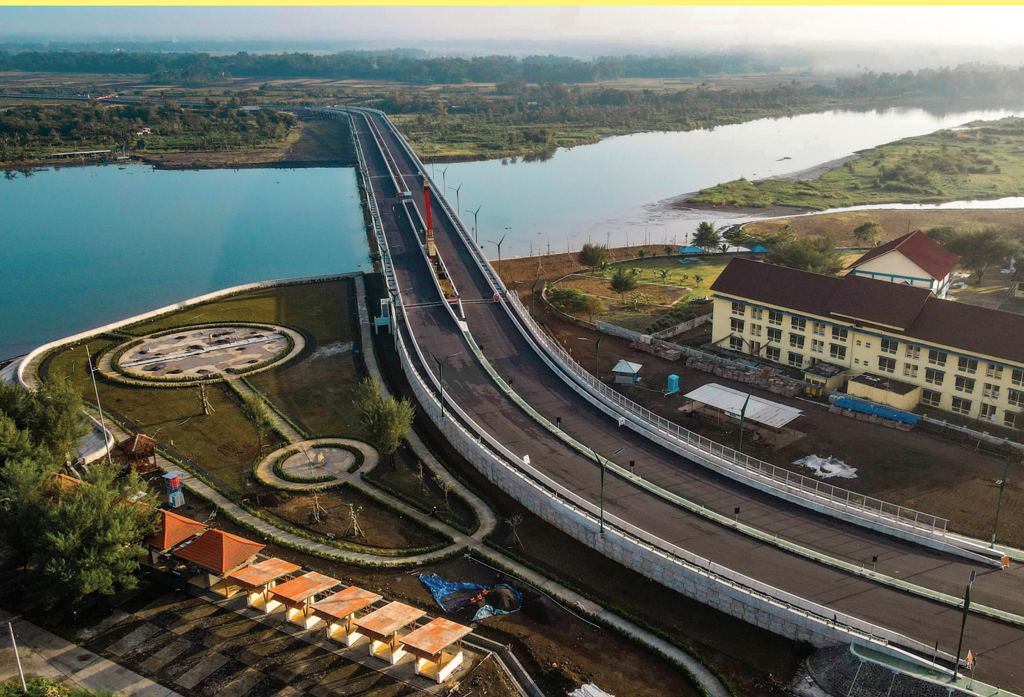
Foto: Dok. Ditjen Bina Marga
