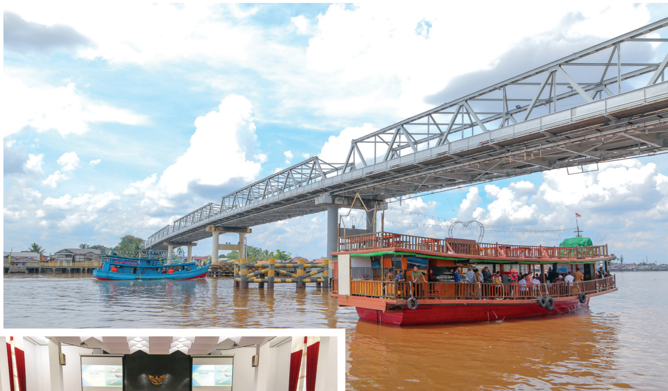
Foto: Dok. Ditjen Bina Marga
