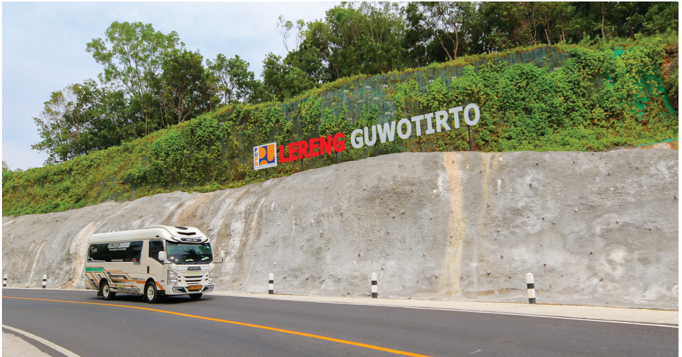
Foto: Dok. Ditjen Bina Marga
