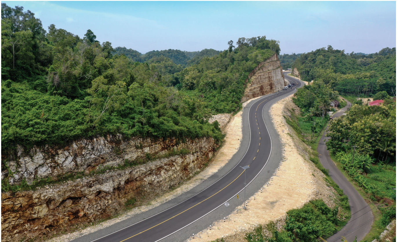
Foto: Dok. Ditjen Bina Marga
