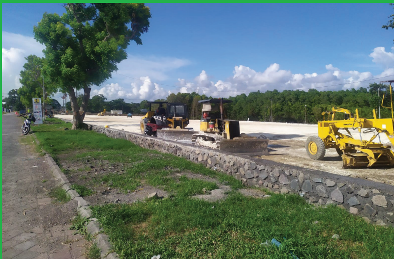
Foto: Dok. Ditjen Bina Marga
