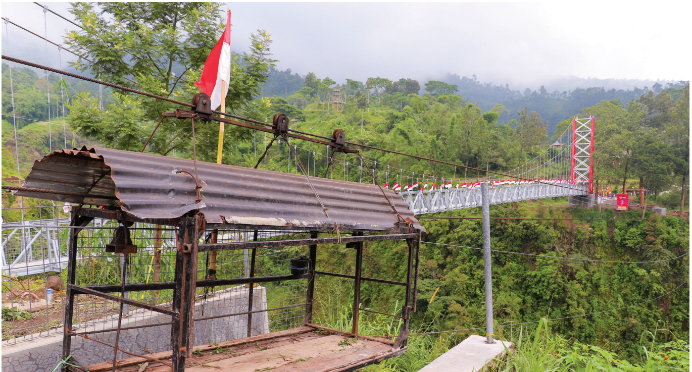
Foto: Dok. Ditjen Bina Marga
