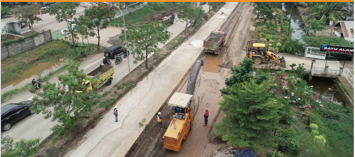
Foto: Dok. Ditjen Bina Marga
