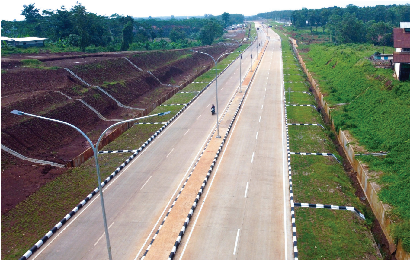
Foto: Dok. Ditjen Bina Marga
