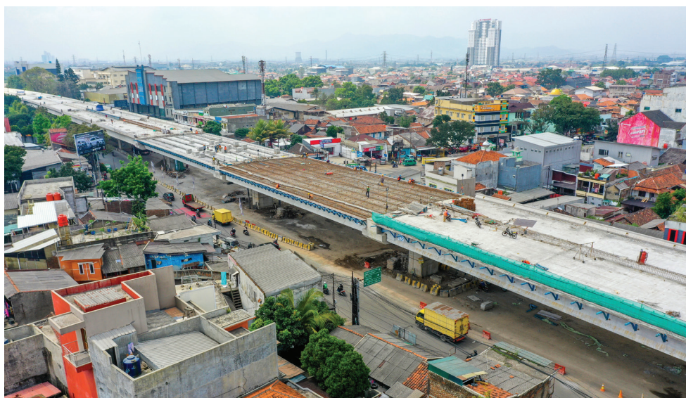
Foto: Dok. Ditjen Bina Marga
