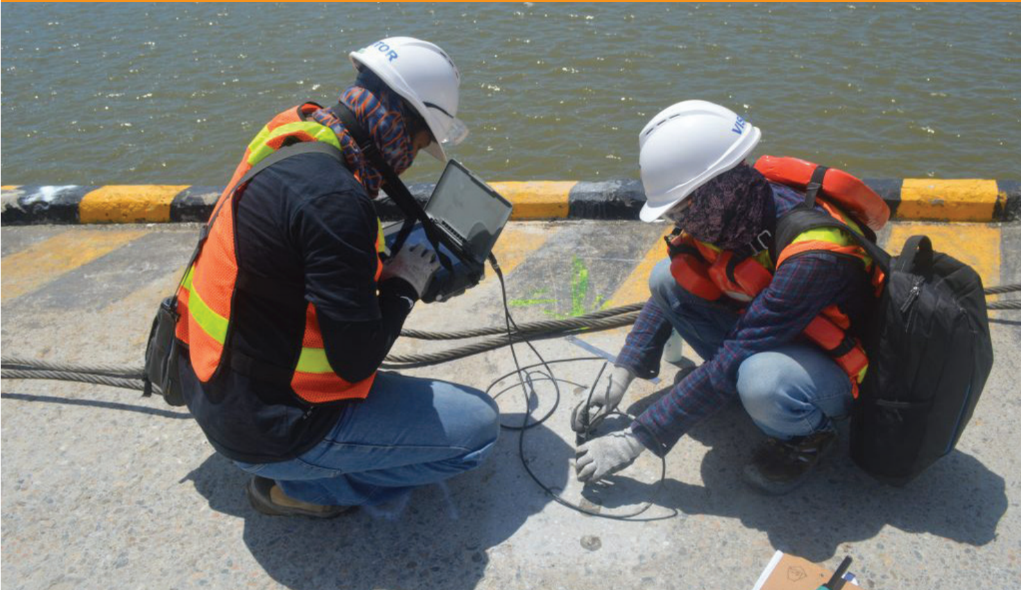
Foto: Dok. Ditjen Bina Marga
