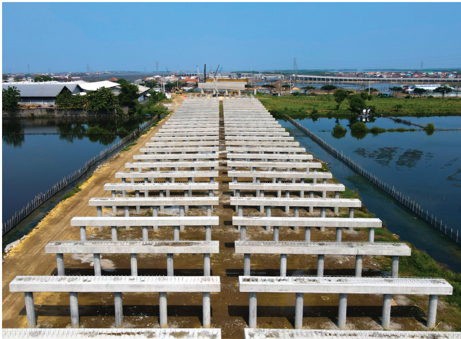
Foto: Dok. Ditjen Bina Marga
