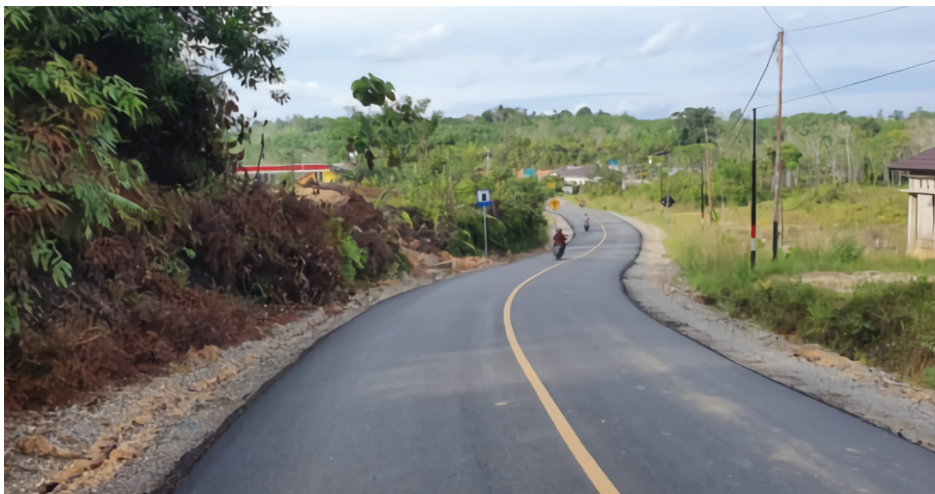
Foto: Dok. Ditjen Bina Marga
