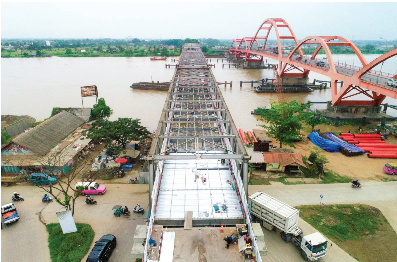
Foto: Dok. Ditjen Bina Marga
