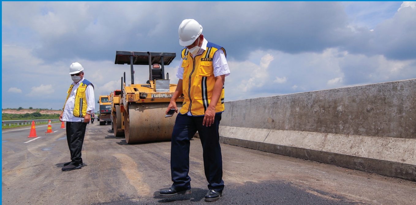
Foto: Dok. Ditjen Bina Marga
