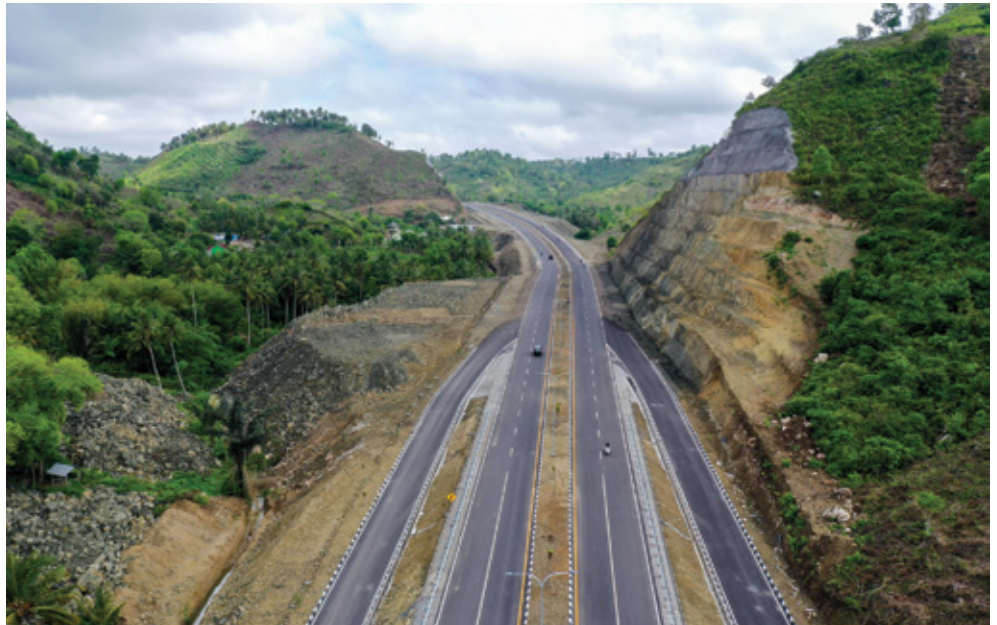
Foto: Dok. Ditjen Bina Marga
