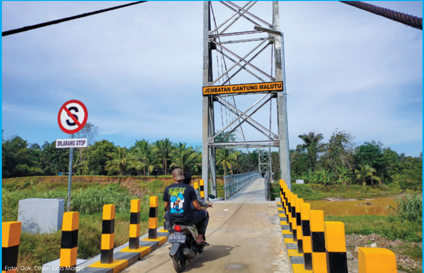
Foto: Dok. Ditjen Bina Marga
