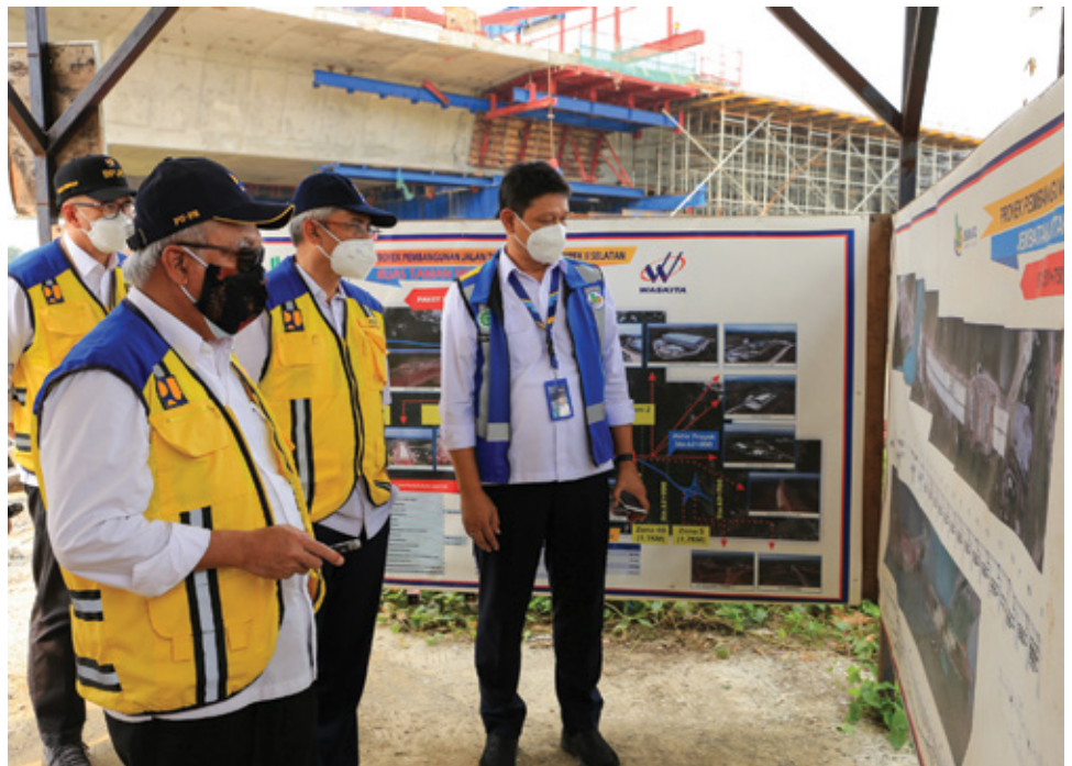
Foto: Dok. Ditjen Bina Marga
