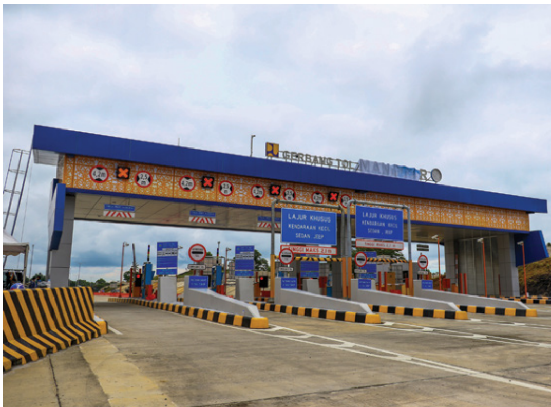
Foto: Dok. Ditjen Bina Marga
