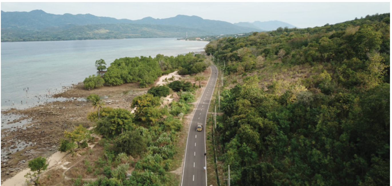
Foto: Dok. Ditjen Bina Marga
