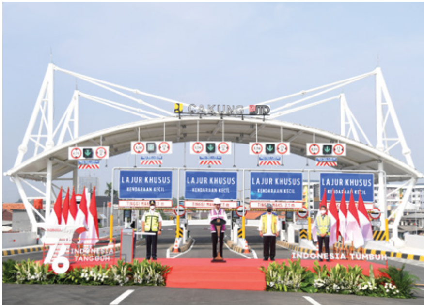
Foto: Dok. Ditjen Bina Marga
