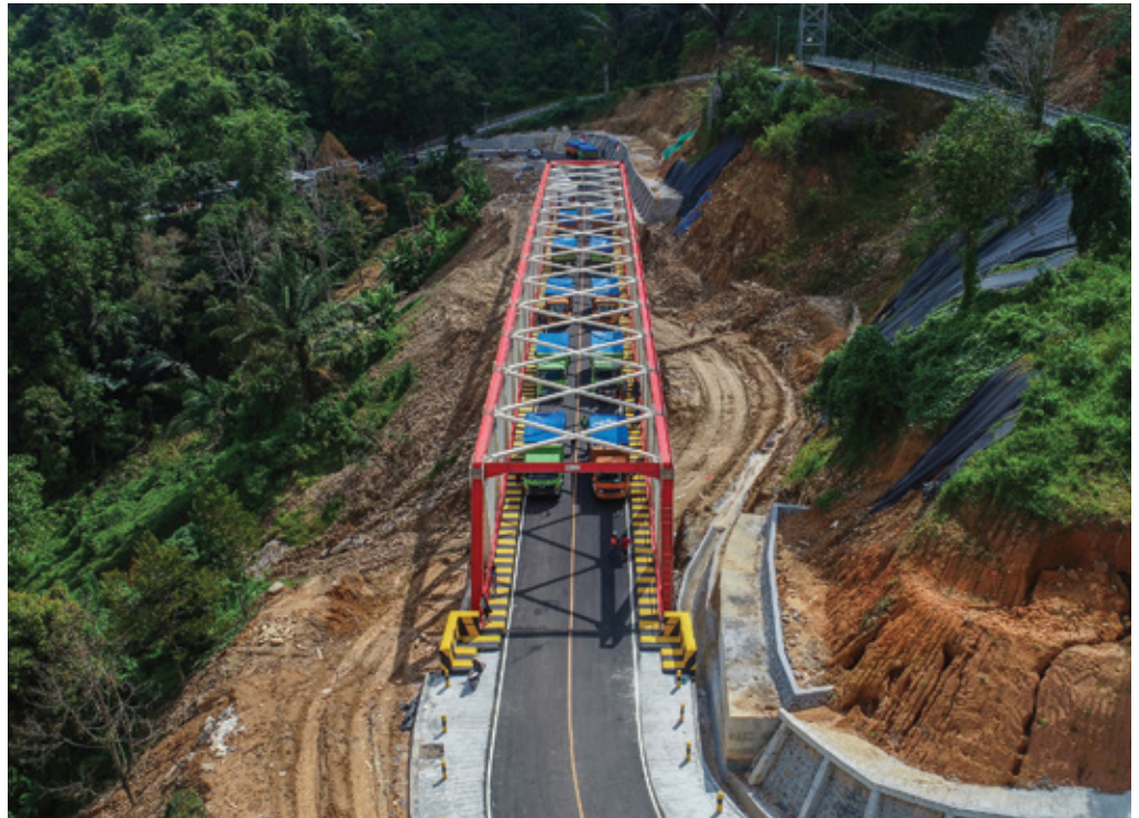
Foto: Dok. Ditjen Bina Marga
