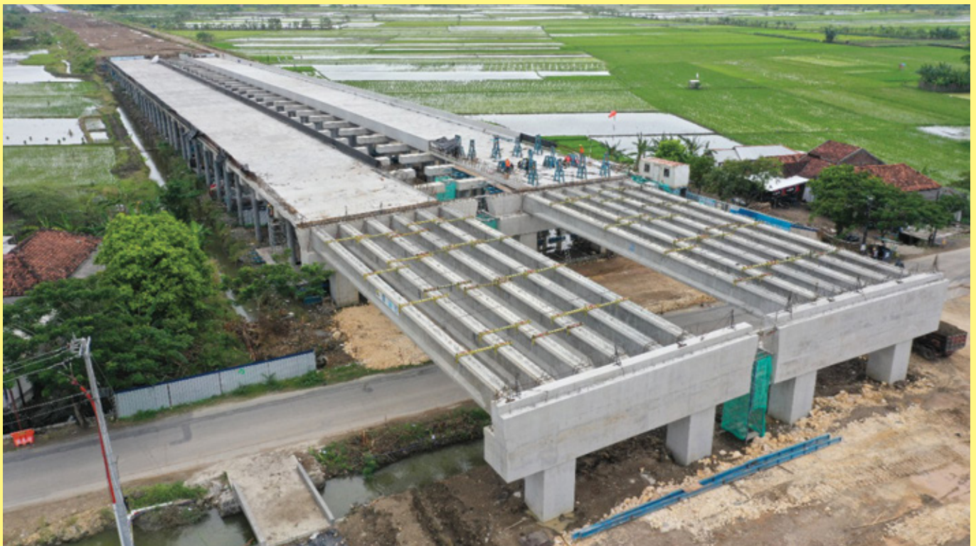
Foto: Dok. Ditjen Bina Marga
