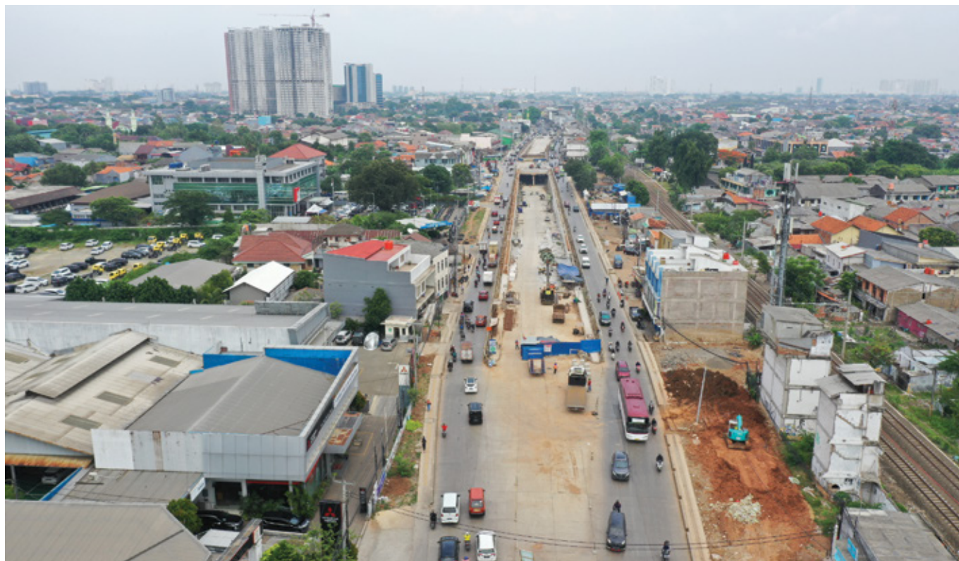
Foto: Dok. Ditjen Bina Marga
