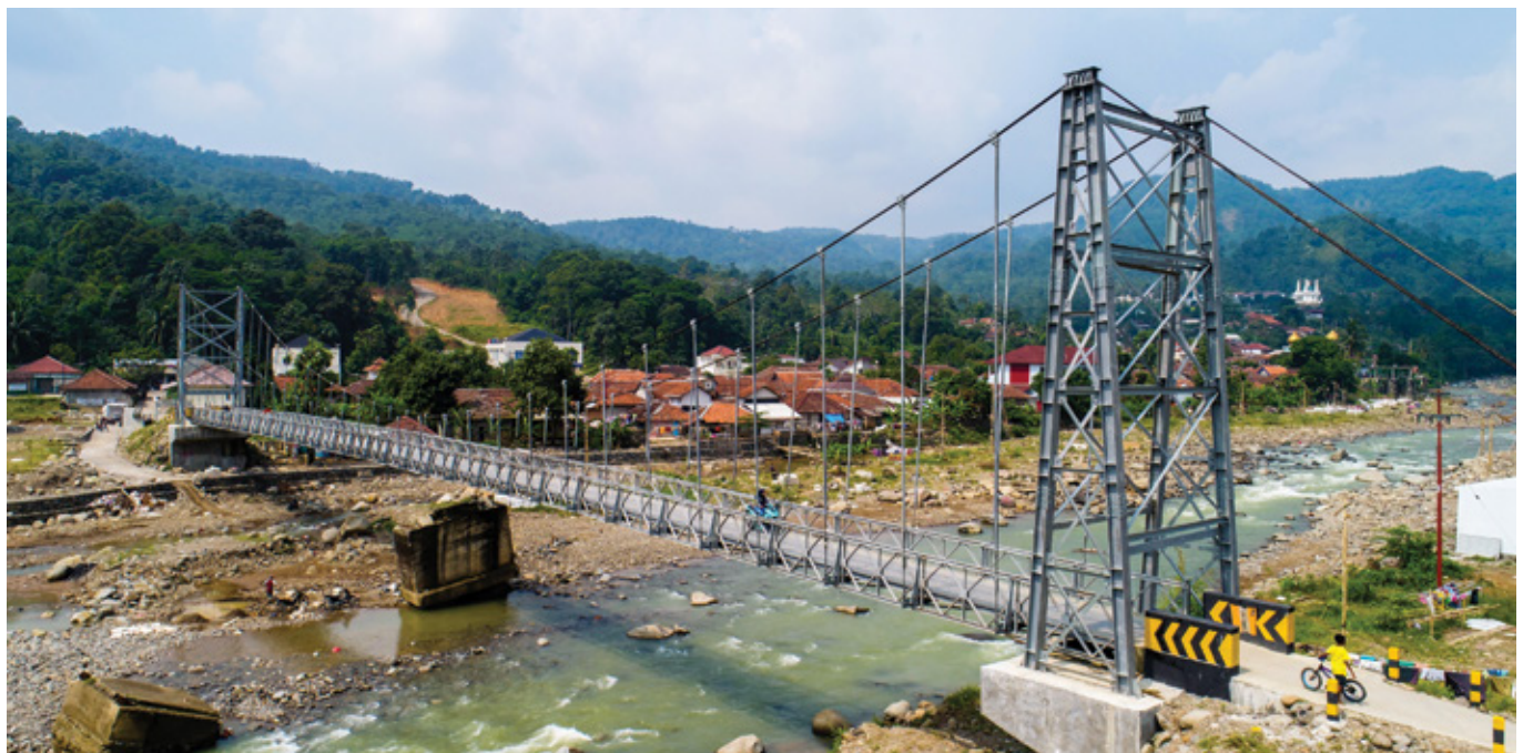
Foto: Dok. Ditjen Bina Marga
