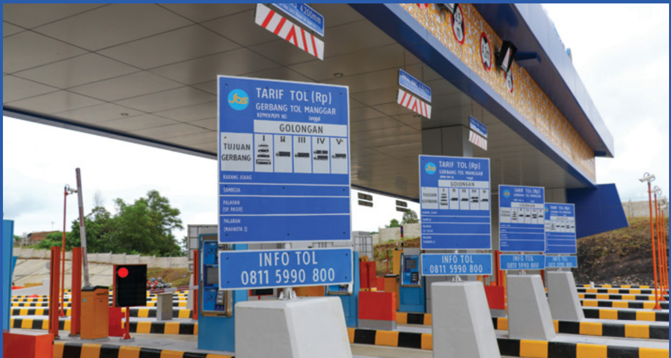
Foto: Dok. Ditjen Bina Marga
