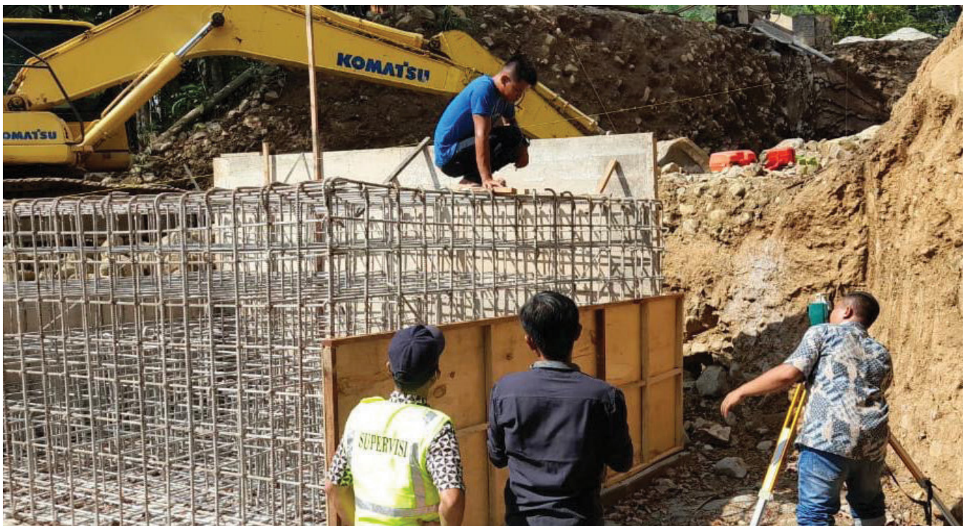
Foto: Dok. Ditjen Bina Marga
