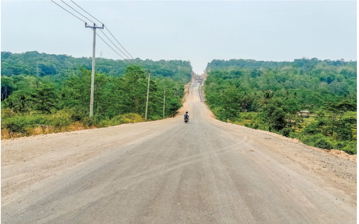
Foto: Dok. Ditjen Bina Marga
