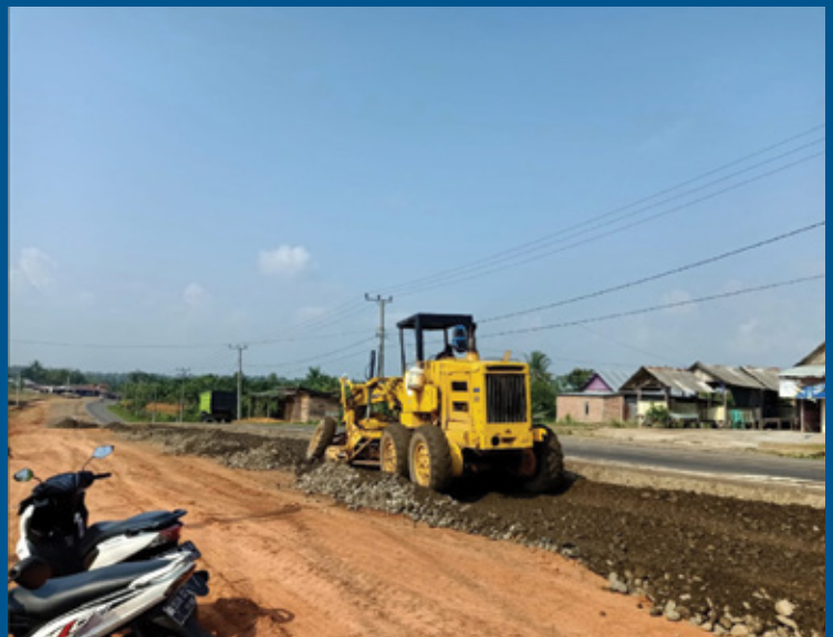
Foto: Dok. Ditjen Bina Marga
