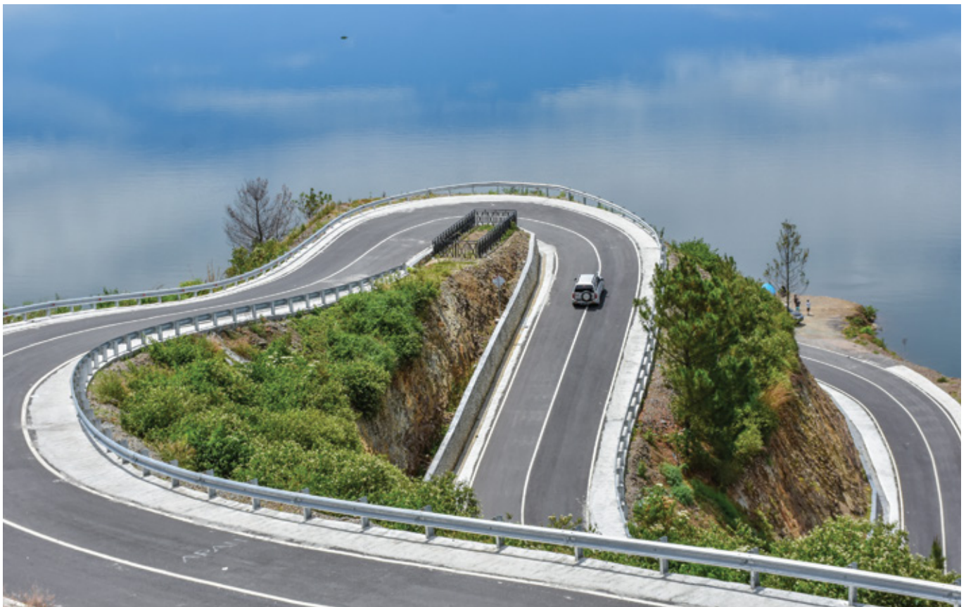
Foto: Dok. Ditjen Bina Marga
