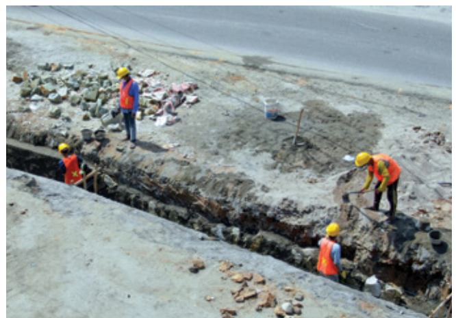
Foto: Dok. Ditjen Bina Marga
