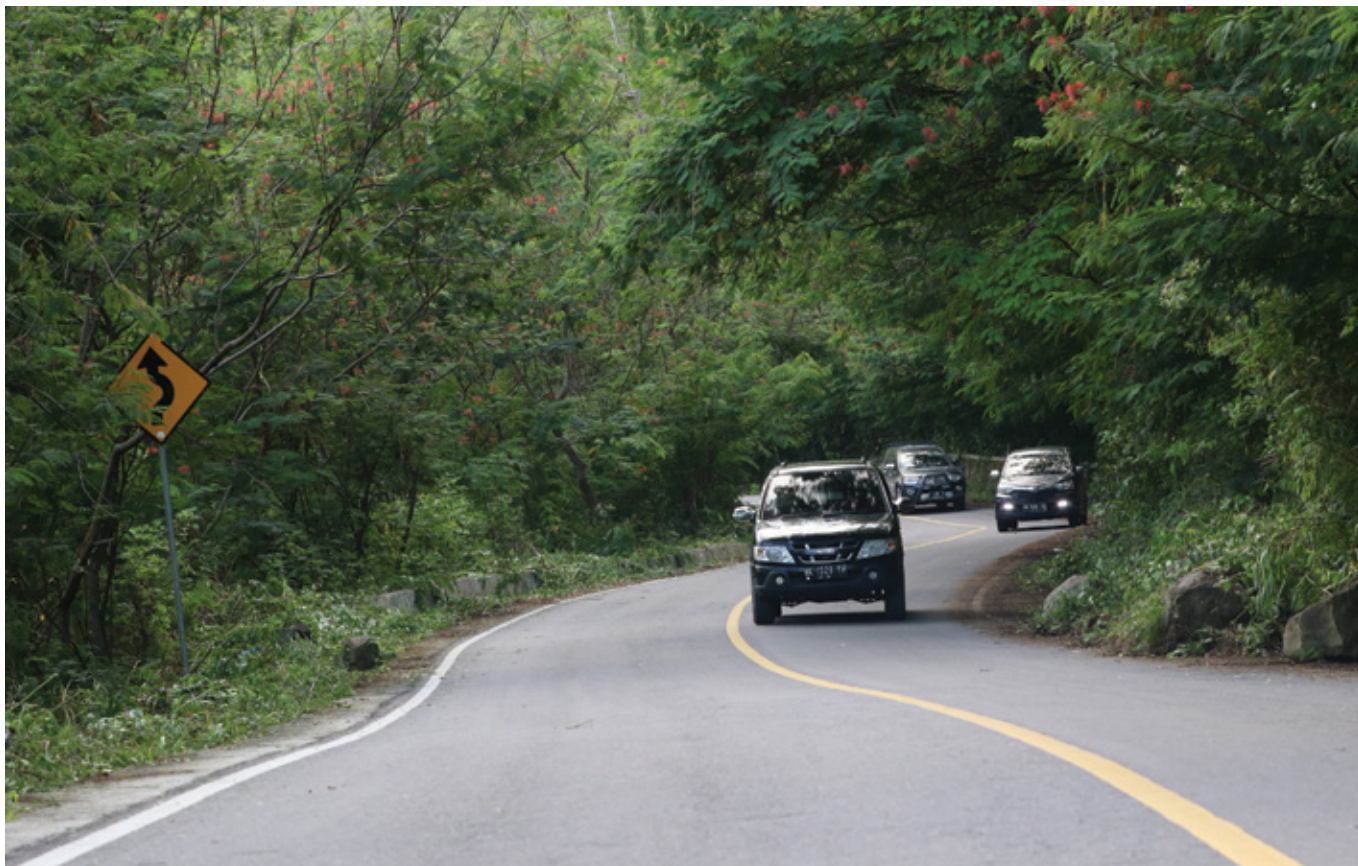
Foto: Dok. Ditjen Bina Marga
