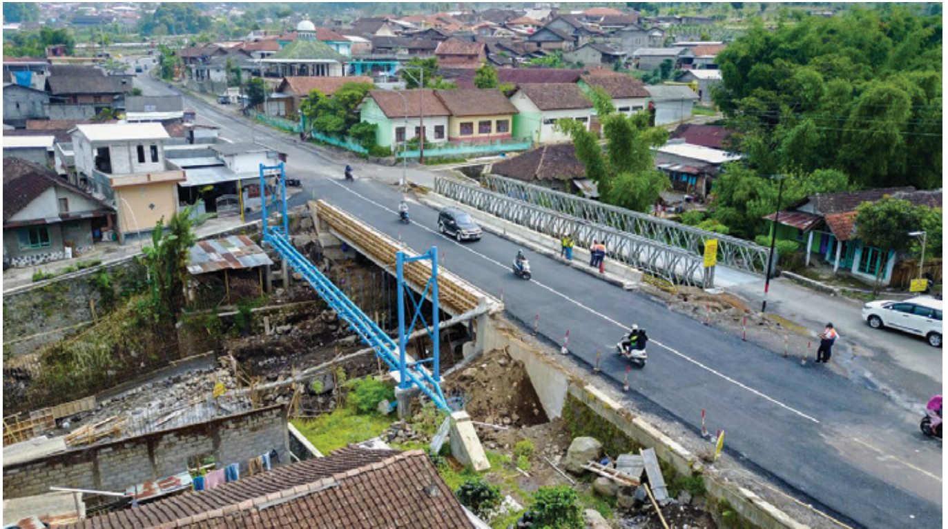
Foto: Dok. Ditjen Bina Marga
