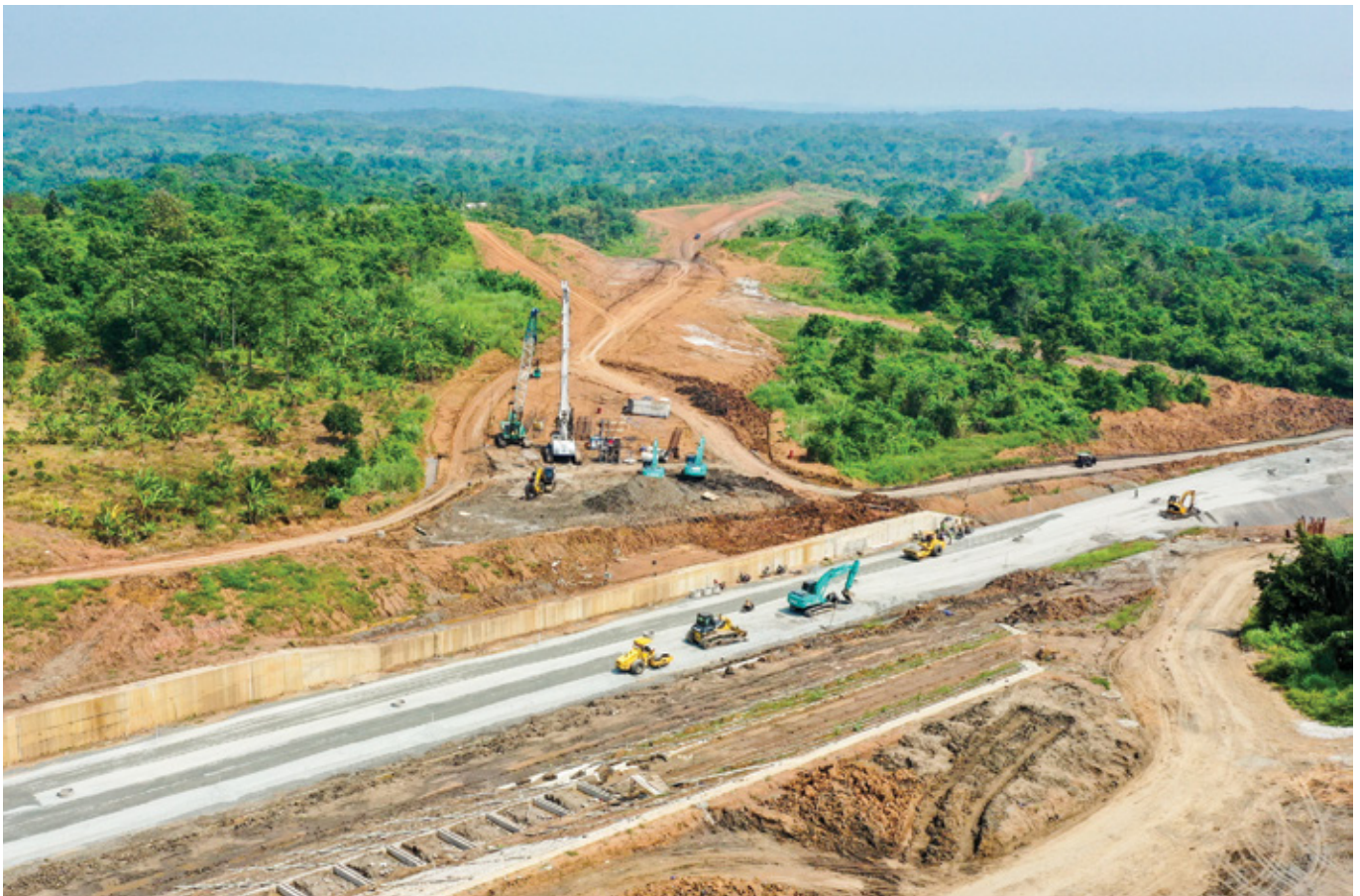
Foto: Dok. Ditjen Bina Marga
