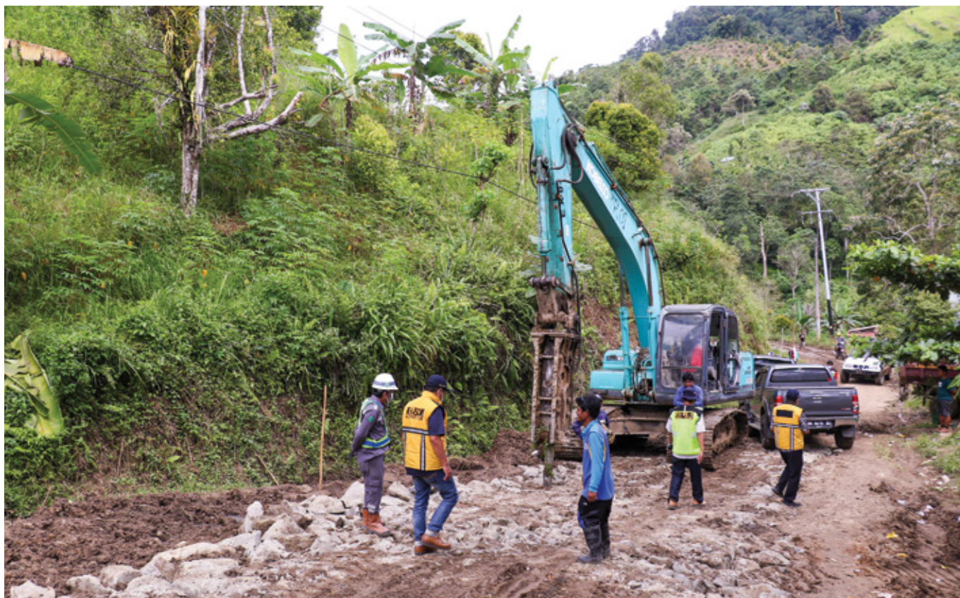
Foto: Dok. Ditjen Bina Marga
