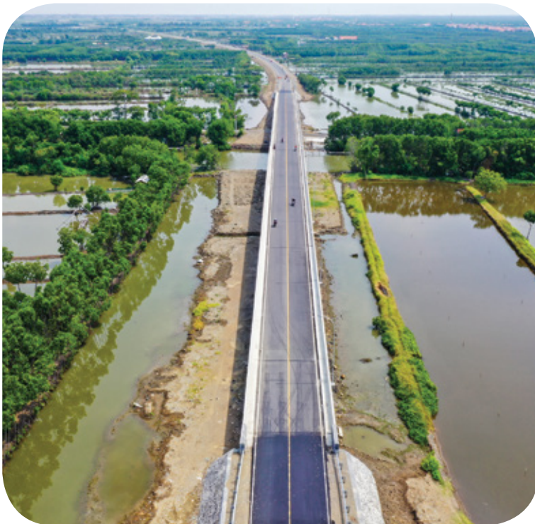
Foto: Dok. Ditjen Bina Marga
