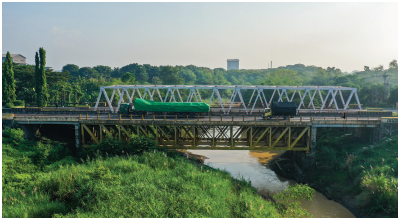
Foto: Dok. Ditjen Bina Marga
