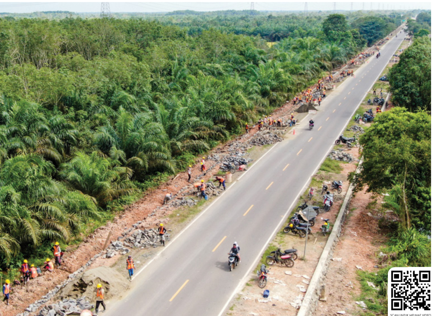
Foto: Dok. Ditjen Bina Marga
