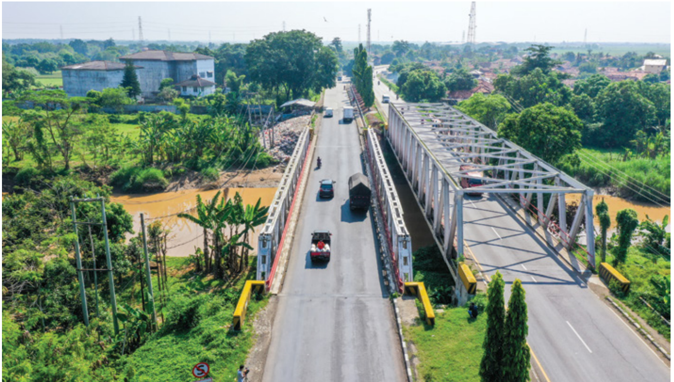
Foto: Dok. Ditjen Bina Marga
