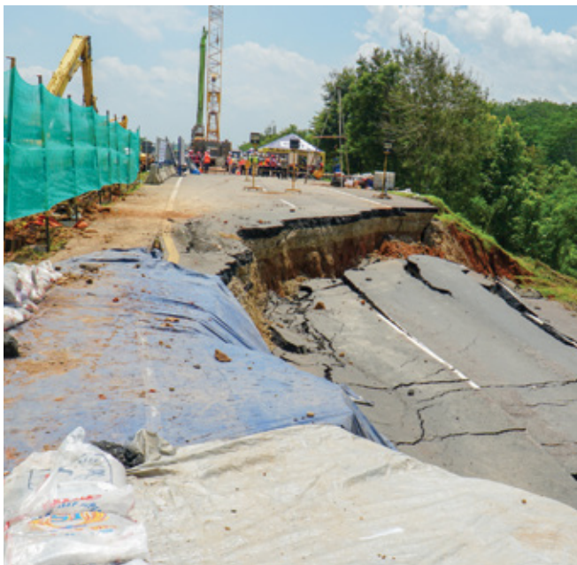
Foto: Dok. Ditjen Bina Marga
