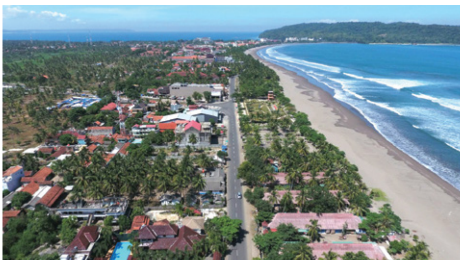
Foto: Dok. Ditjen Bina Marga
