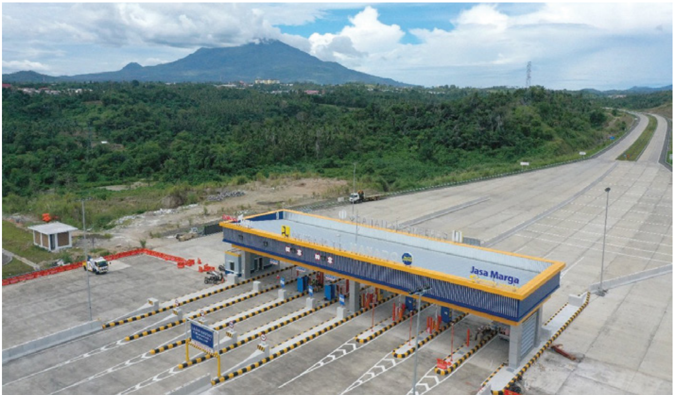
Foto: Dok. Ditjen Bina Marga
