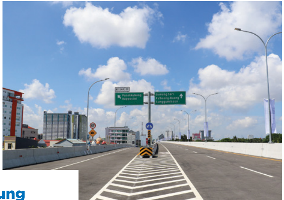
Foto: Dok. Ditjen Bina Marga
