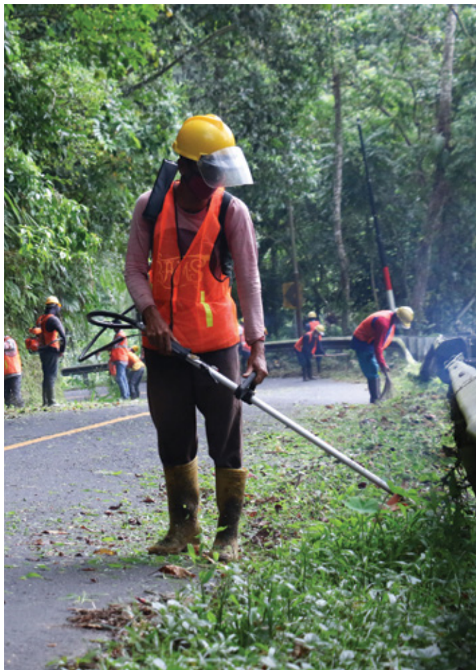
Foto: Dok. Ditjen Bina Marga
