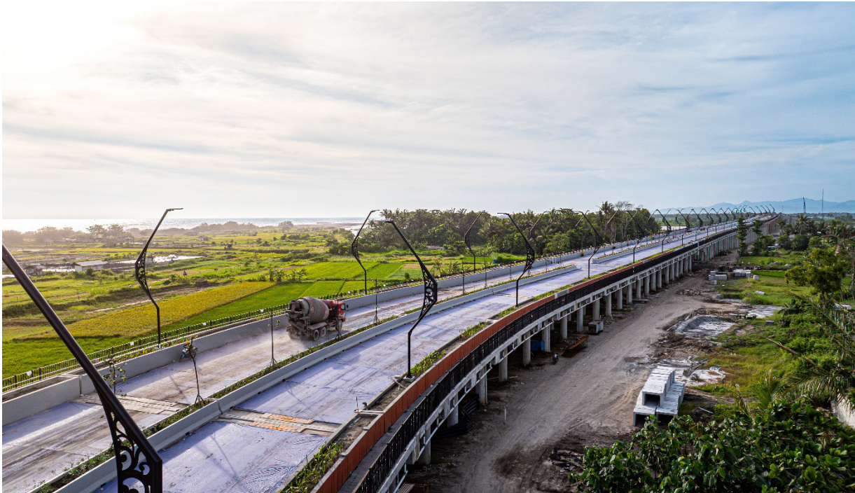
Gambar 2. Pembangunan Jembatan Pandansimo
