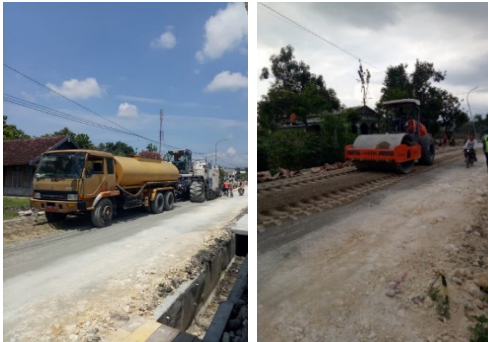
Gambar 4. Proses pencampuran material tanah, semen dan air yang telah mengandung aditif berbasis garam anorganik
