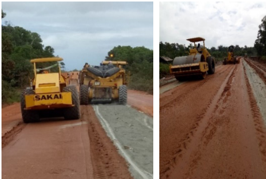
Gambar 6. Stabilisasi tanah tahap 2 dengan semen
