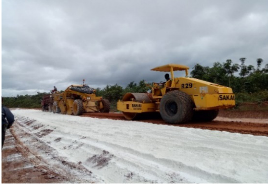
Gambar 5. Stabilisasi tanah tahap 1 dengan kapur
