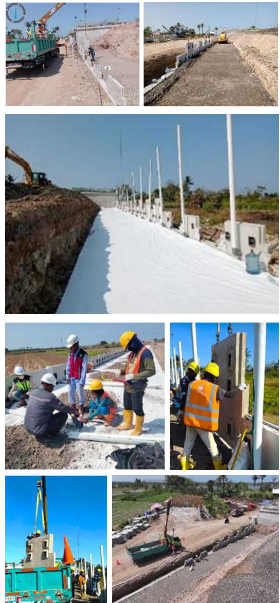
Gambar 7. Pemasangan MSE Wall
