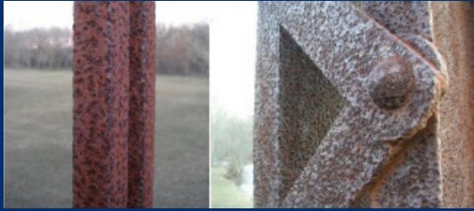
Gambar 2. Anggota Struktur Berupa Tiang Penopang yang Mengalami Korosi | (Jang Shinae dan F. Spencer, Jr. Billie, NSEL Report Series, 2015).
