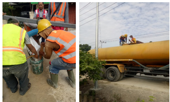
Gambar 3. Pelarutan aditif berbasis garam anorganik dalam air dan penguangannya ke dalam truk tangki air
