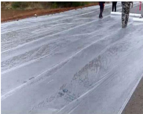
Gambar 1. Proses pencampuran material tanah dengan semen dan air, pemadatan dan perawatan
