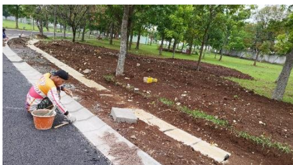
Pemasangan Kerb Beton
