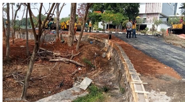
Proses penanganan gradien dan pembuatan struktur pendukung pagar
