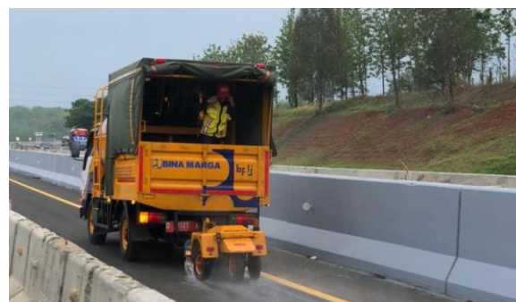
Pengujian Kekesatan Jalan
