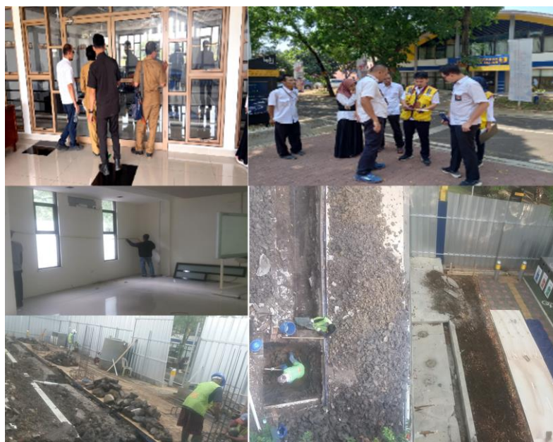
Gambar 4.5 Pemeliharaan Gedung Balai dan Laboratorium Tahun 2023
