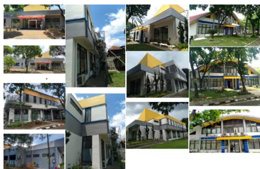
Gambar 4.3 Paket Pemeliharaan dan Pengecatan Gedung
