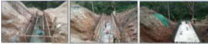
Pelaksanaan Pekerjaan Box Culvert Fc' 20 MPa
