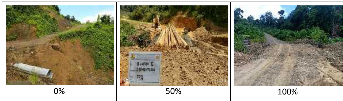
Gambar 3.18 Dokumentasi Pemeliharaan Rutin Pembangunan (Jalan Perbatasan)
