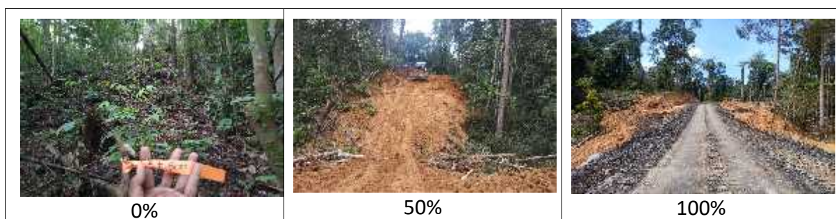
Gambar 3.19 Dokumentasi Pembangunan Jalan Tiong Ohang – Long Pahangai 2
