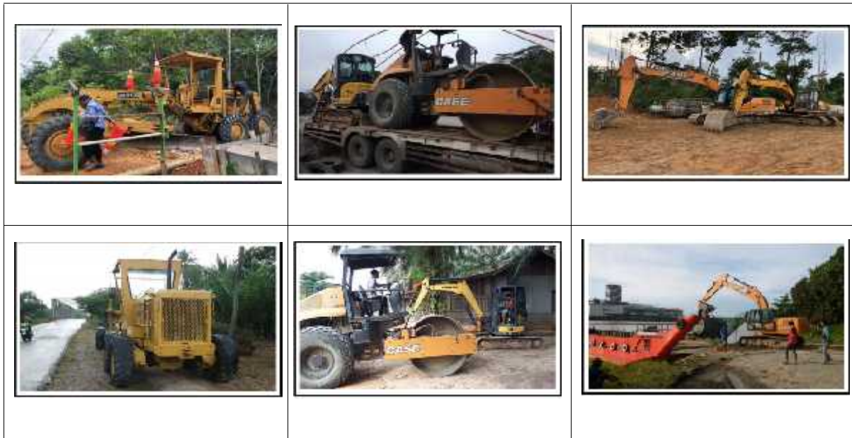
Gambar 3.9 Dokumentasi Preservasi Jalan Gusig – Sp. Blusuh (Mobilisasi Bulan Oktober 2020)
