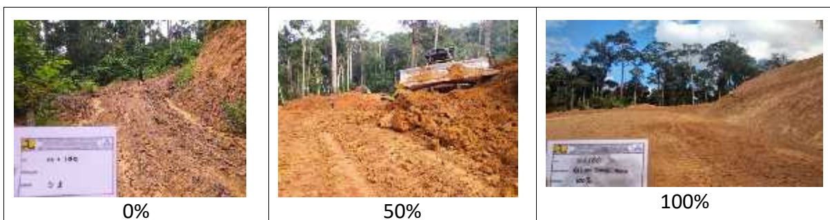
Gambar 3.21 Dokumentasi Jalan Batas Kalbar – Tiong Ohang 1
