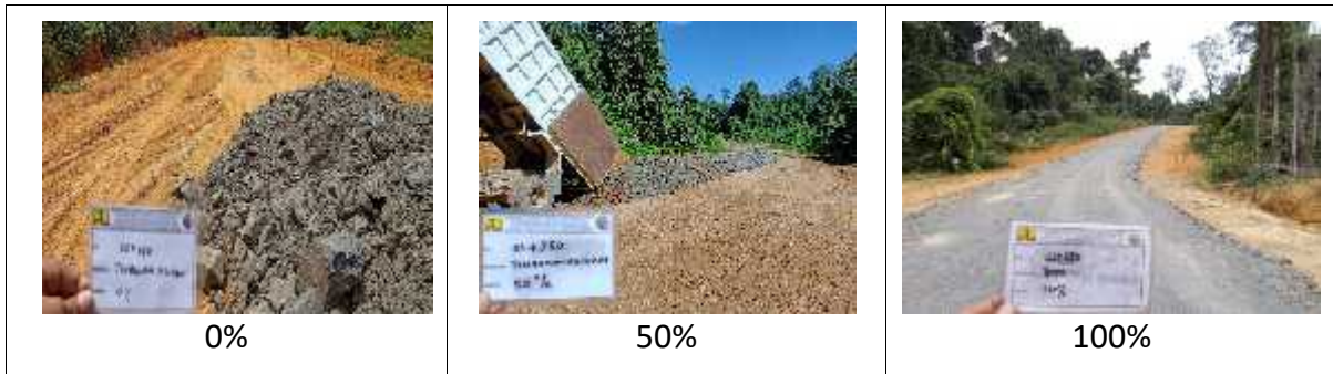
Gambar 3.22 Dokumentasi Jalan Long Pahangai – Long Boh 1
