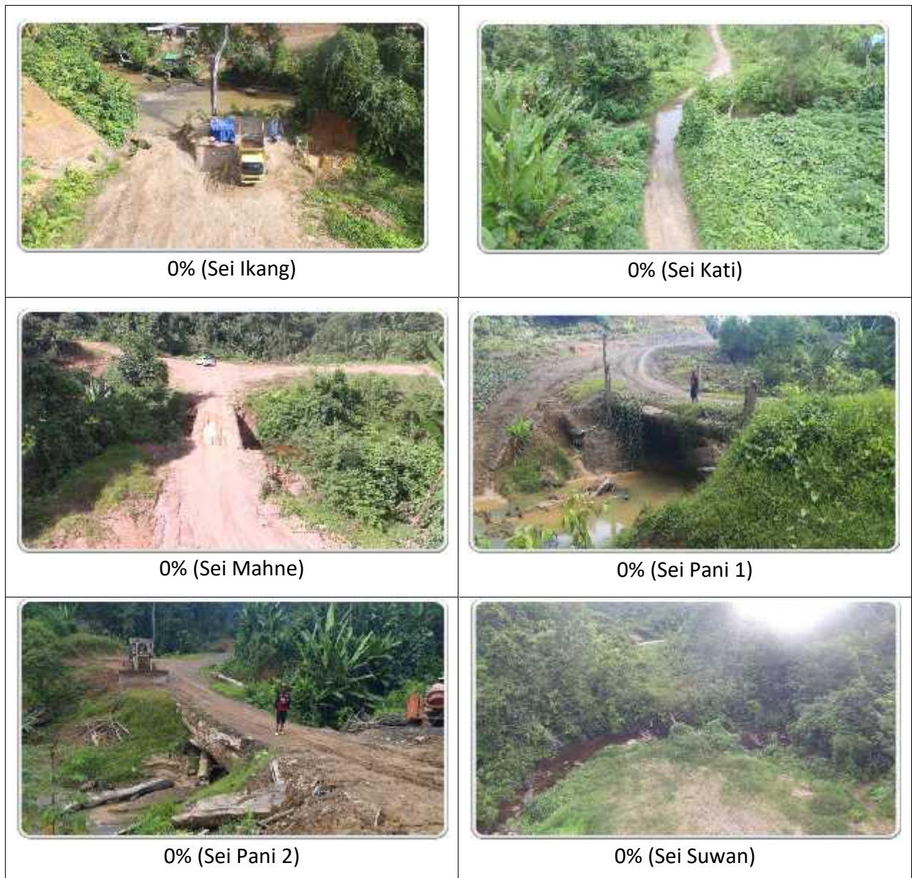
Gambar 3.13 Dokumentasi Pembangunan Jembatan Paralel Perbatasan II
