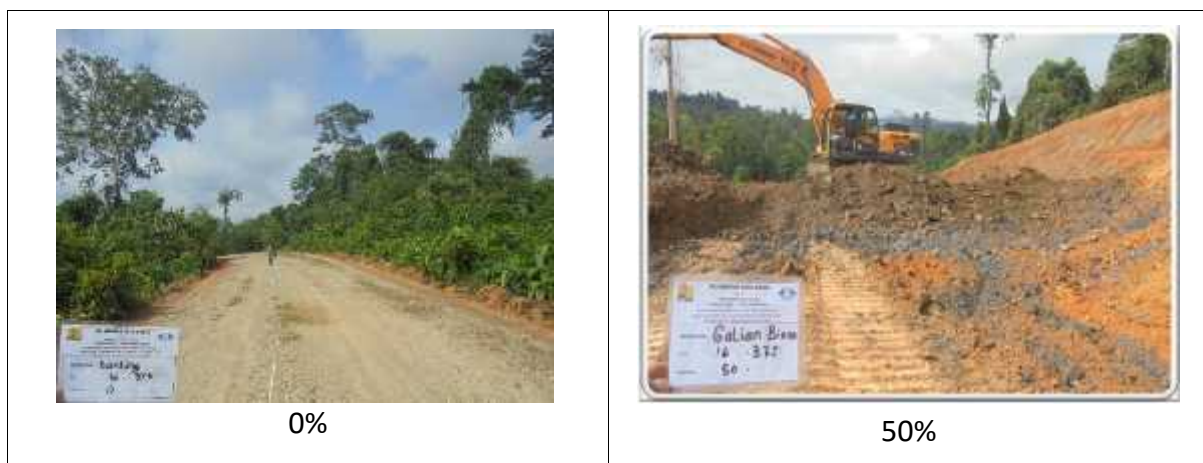
Gambar 3.16 Dokumentasi Pembangunan Jalan Tiong Ohang – Long Pahangai 3
