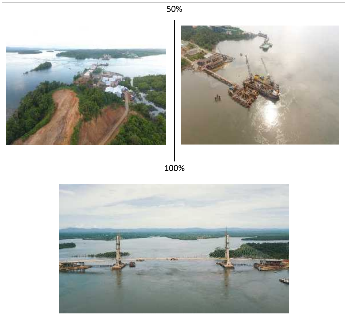
Gambar 3.8 Dokumentasi Pembangunan Jembatan Pulau Balang
