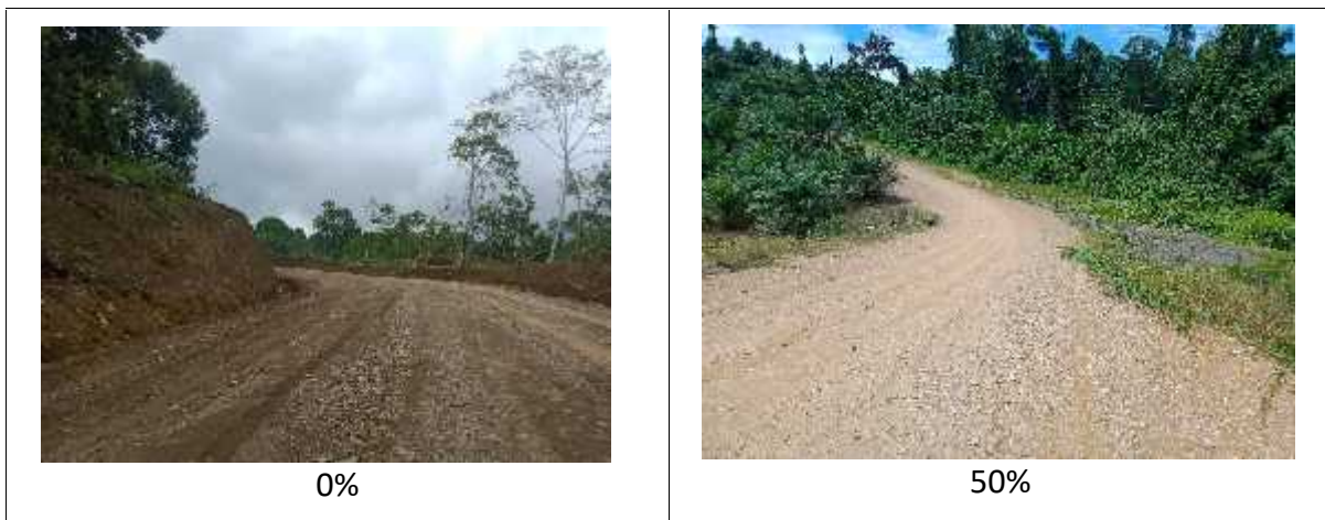
Gambar 3.17 Dokumentasi Pembangunan Jalan Long Bagun – Tering 1
