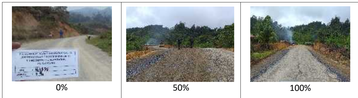
Gambar 3.15 Dokumentasi Pembangunan Jalan Tiong Ohang – Long Pahangai 2
