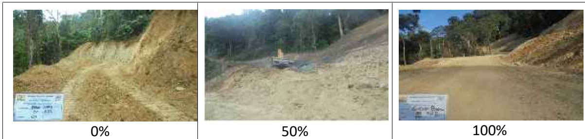
Gambar 3.20 Dokumentasi Jalan Tiong Ohang – Long Pahangai 1
