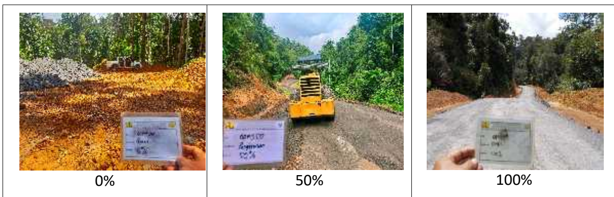
Gambar 3.23 Dokumentasi Pembangunan Jalan Long Pahangai – Long Boh 2
