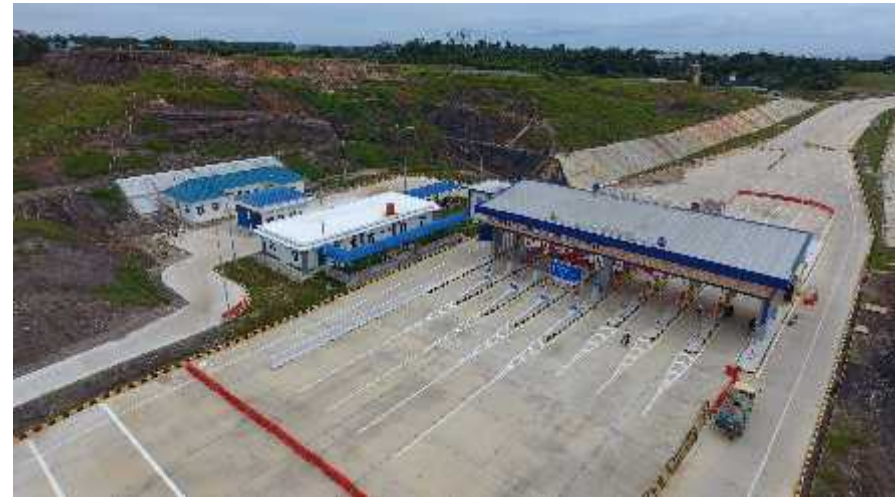
Gerbang Tol Manggar STA 9+200
