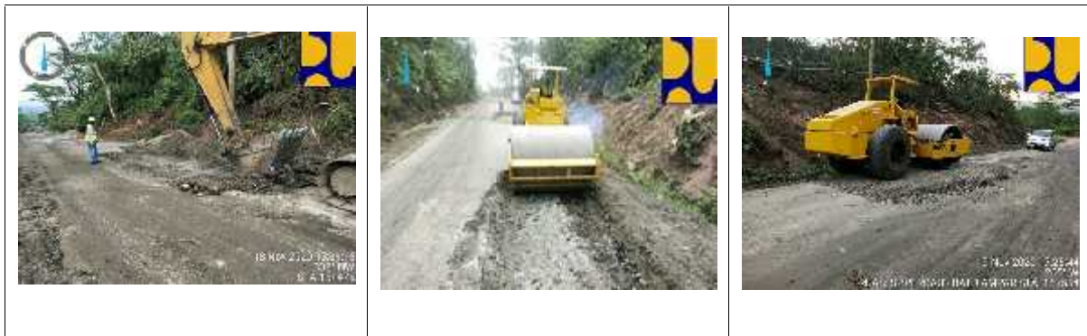
Gambar 3.12 Dokumentasi Preservasi Jalan Sp. Perdau – Batu Ampar
