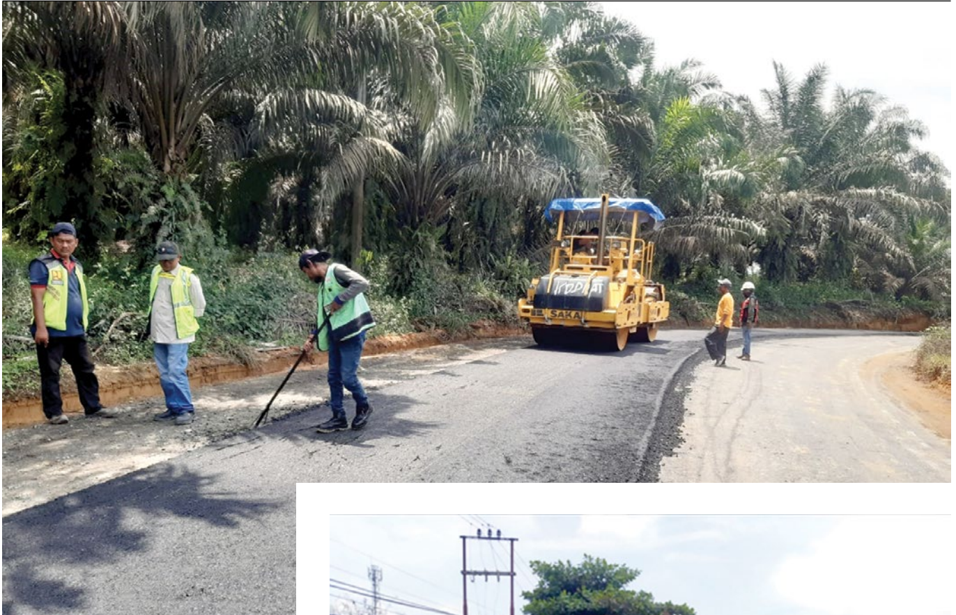
Peningkatan Jalan Lipat Kain - Lubuk Agung - Batu Sasak - Batas Sumbar (PPK 2.5 Provinsi Riau).
