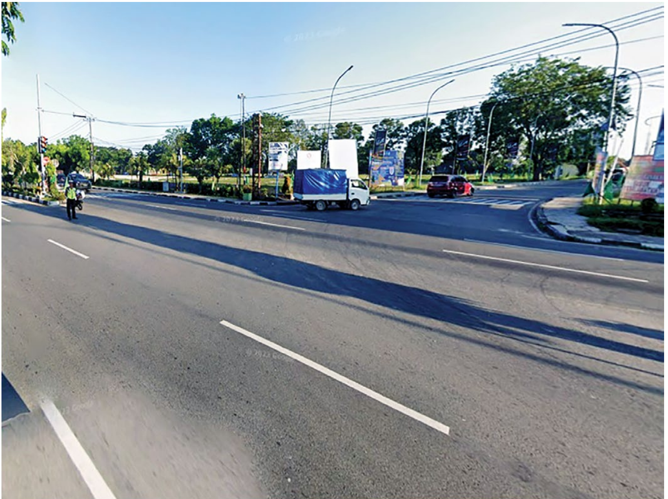
Bundaran pada Exit Tol Ruas Jalan Moh Yamin (Bangkinang)
