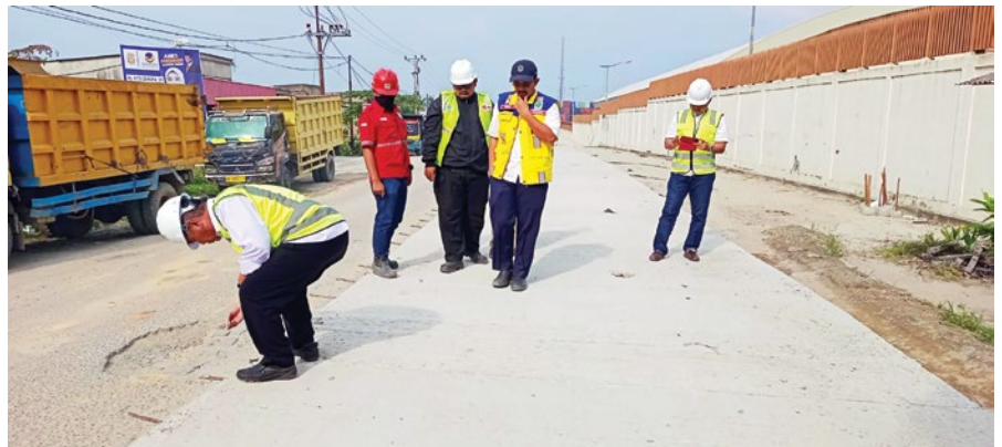
Kegiatan monitoring dan evaluasi pekerjaan pada ruas jalan PPK 1.3 Provinsi Riau.
