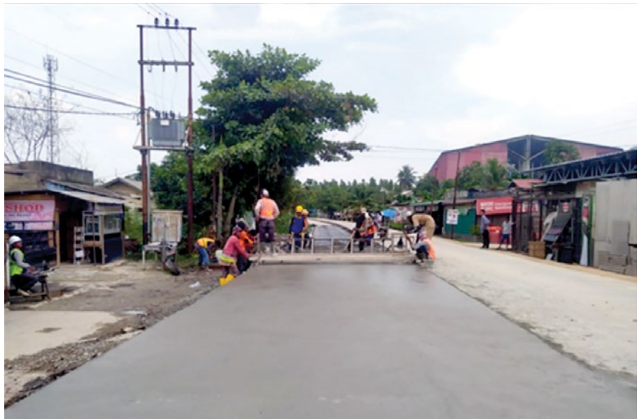
Peningkatan Jalan Simpang Pemda - Pelabuhan Pelindo (PPK 1.3 Provinsi Riau).
