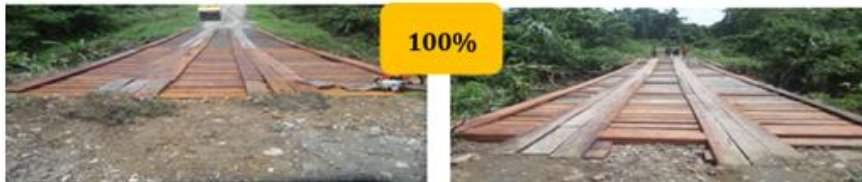
(a) Pekerjaan Pemeliharaan Rutin Transisi pada Jembatan Airu 4 di Kab. Jayapura STA 267+350, Bentangan 17 Meter
