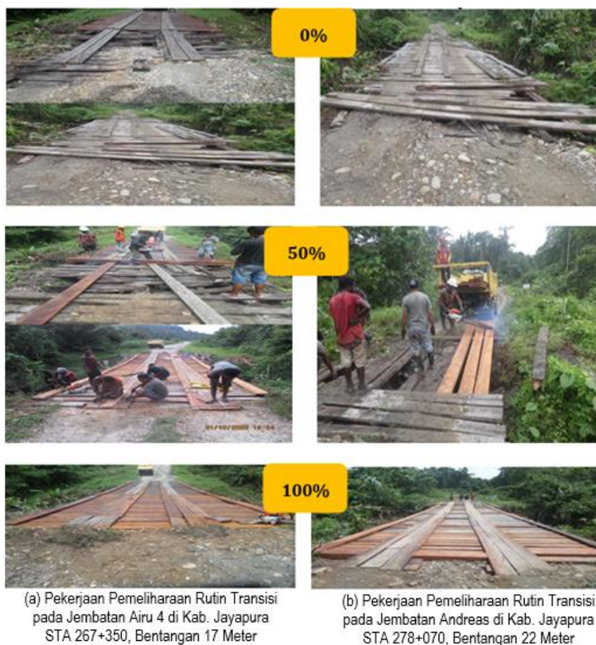
Gambar 4.2 Pekerjaan Pemeliharaan Rutin Transisi penanganan Satker BBPJN XVIII Jayapura
