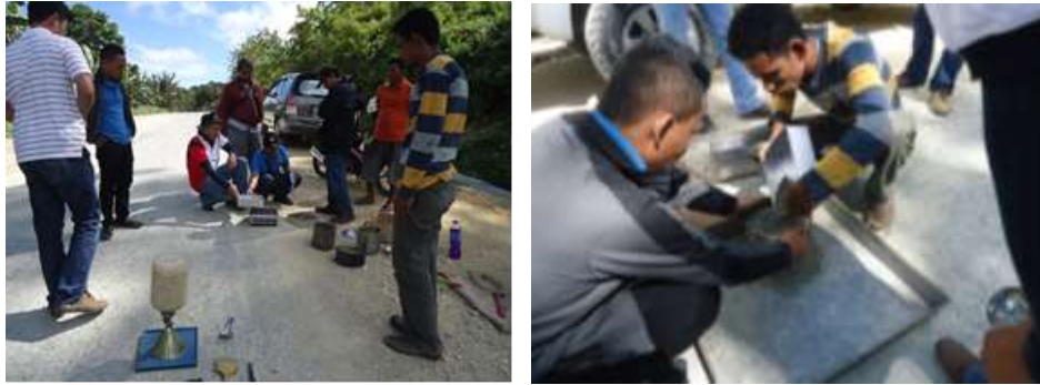
Gambar 4.4 Kegiatan uji petik yang dilakukan pada pekerjaan peningkatan ruas jalan
