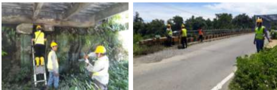
Gambar 4.1 Kegiatan Survei Kondisi Jembatan Ruas Nabire-Legare
