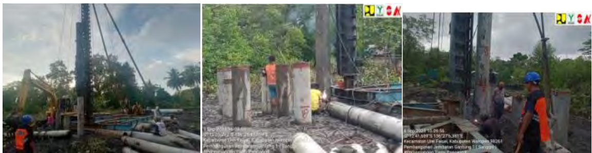
Gambar 4.9 Pembangunan Jembatan Gantung 1 (Sanggei)
