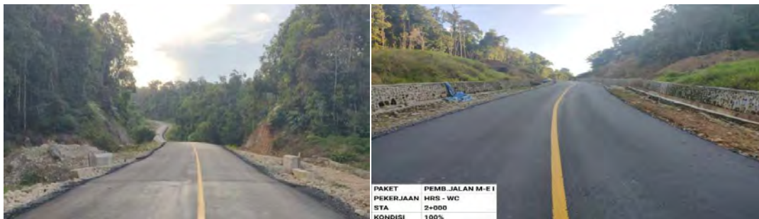
Pembangunan Jalan Mamberamo – Elelim I (MYC) (Trans Papua Segmen IV)
