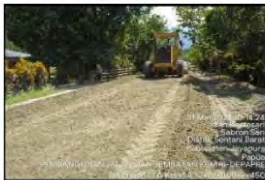
Gambar 4.6 Pembangunan Jalan dan Jembatan Kemiri-Depapre (MYC)
