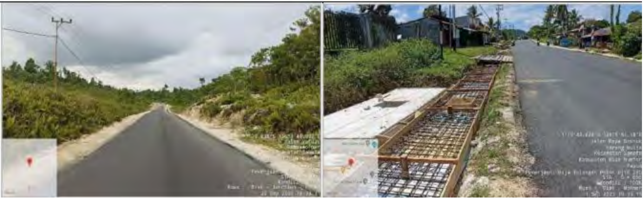
Gambar 4.27 Pengawasan Paket Preservasi Jalan Ruas Biak)
