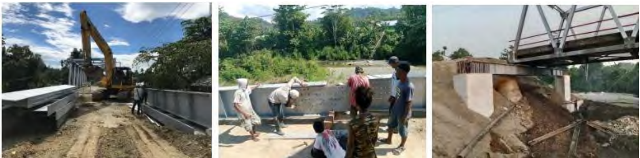
Gambar 4.20 Rehabilitasi Jembatan Ruas Bts. Kota Nabire-Wanggar
