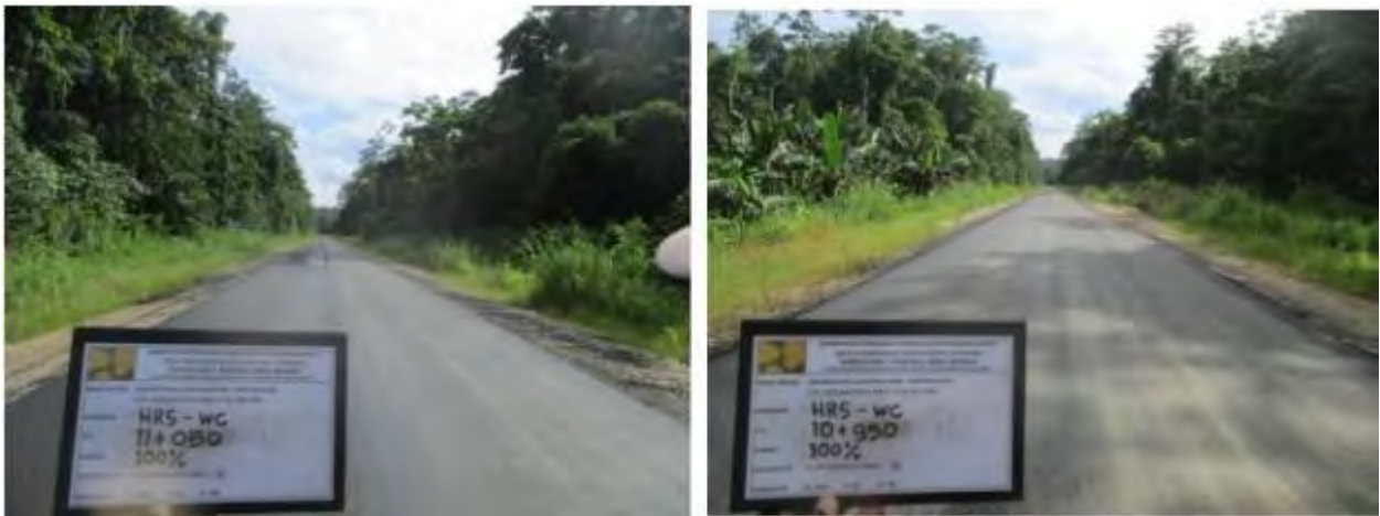
Gambar 4.4 Rekonstruksi Jalan Kwatisore-Kamp Muri (Bts.Provinsi Papua Barat) II
