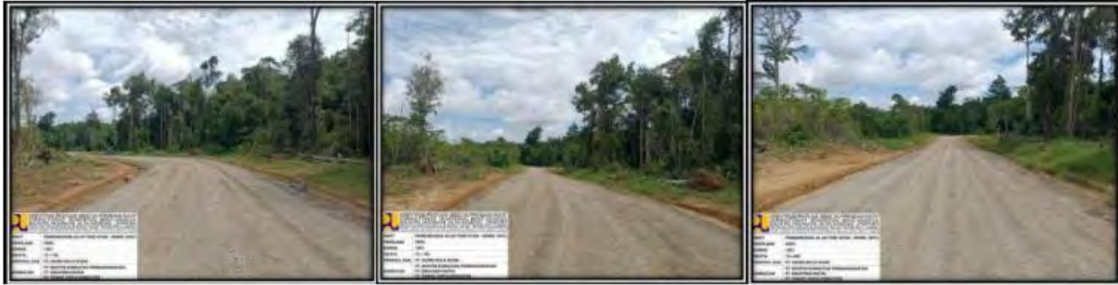
Gambar 4.5 Pembangunan Jalan Towe Hitam-Oksibil (MYC)
