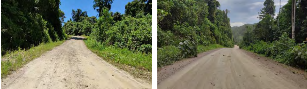
Rekonstruksi Jalan Kwatisore-Kamp. Muri- Kwatisore I (Bts. Provinsi Papua) (Trans Papua Segmen I)
