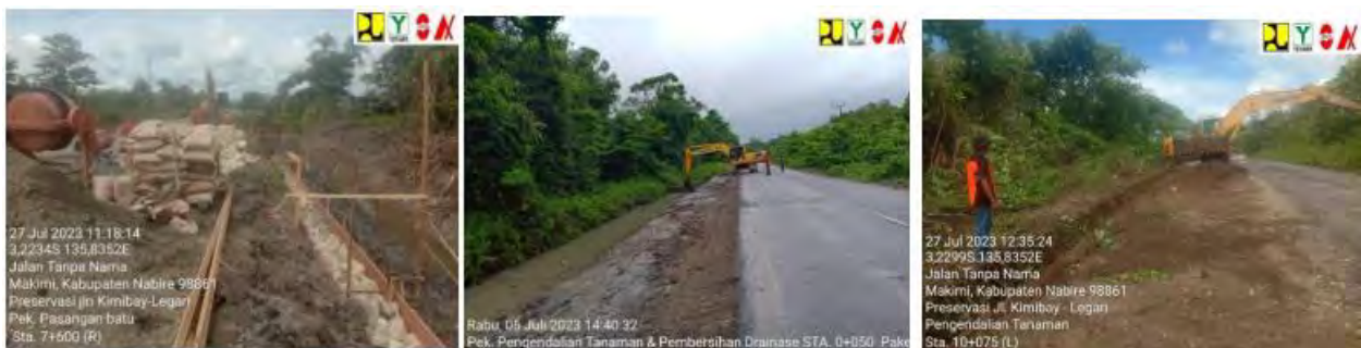
Gambar 4.13 Preservasi Jalan Kimibay-Legare
