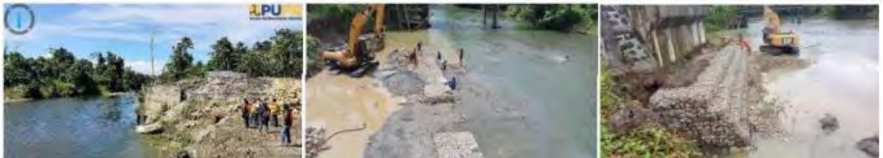
Gambar 4.7 Pembangunan Jembatan Legari Tahap II (Tuntas)
