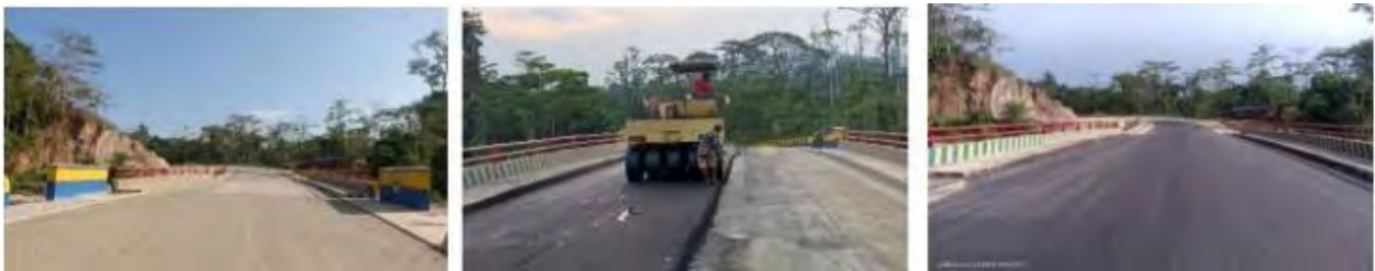
Gambar 4.8 Pembangunan Jembatan Aery 1 Tahap II (Tuntas)
