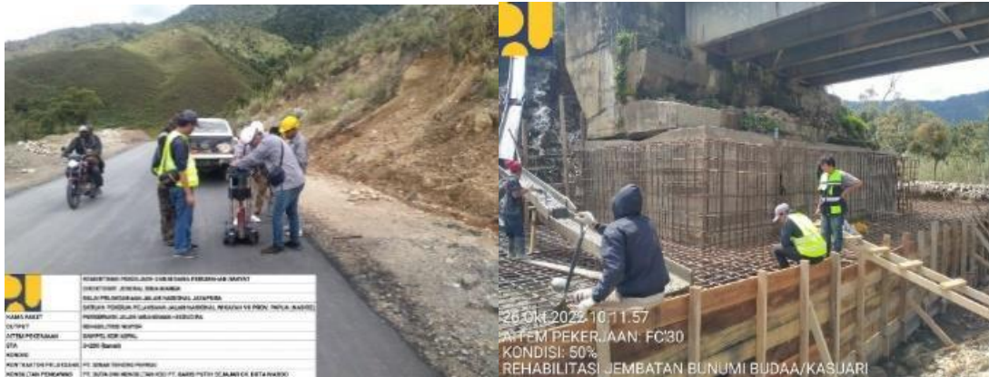
Gambar 4.38 Pengawasan Teknis Nabire 1.1 (Jalan Jembatan Ruas Moanemani-Bedudipa)
