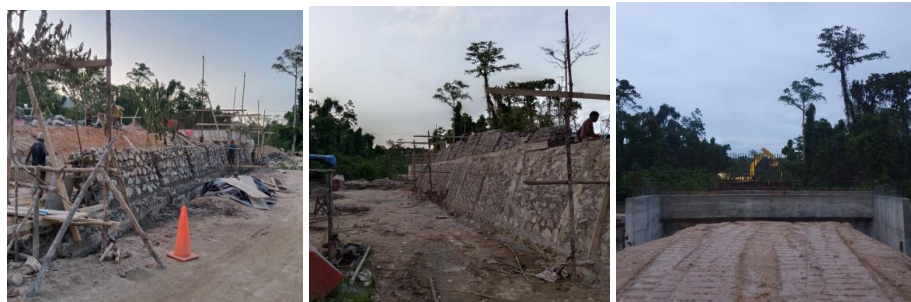
Gambar 4.9 Pembangunan Jembatan Aery 1 penanganan Satker PJN Wil. VII Prov. Papua (Nabire)
