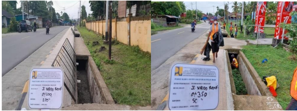
Gambar 4.14 Preservasi Pemeliharaan Rutin Jalan Ruas Jalan Pulau Biak penanganan Satker PJJN Wil. IX Provinsi Papua (Biak)
