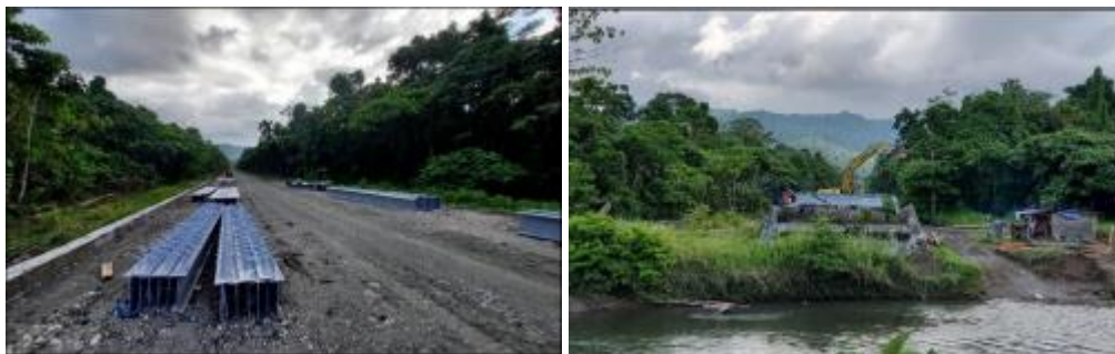
Gambar 4.7 Pembangunan Jembatan Legari Tahap II (Tuntas) penanganan Satker PJJN Wil. VII Prov. Papua (Nabire)
