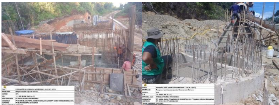
Gambar 4.37 Pengawasan Teknis Pembangunan Jembatan Mamberamo – Elelim II (UMYC)
