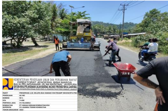
Gambar 4.30 Preservasi Jalan Jl. Kelapa dua-Hamadi-Holtekamp-Skouw/Bts.PNG penanganan Satker PJN Wil.I Provinsi Papua (Jayapura)
