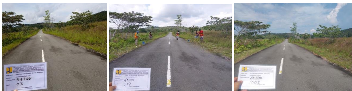
Gambar 4.21 Pemeliharaan Rutin Jalan Depapre-Bongrang penanganan Satker PJJN Wil. I Prov. Papua (Jayapura)
