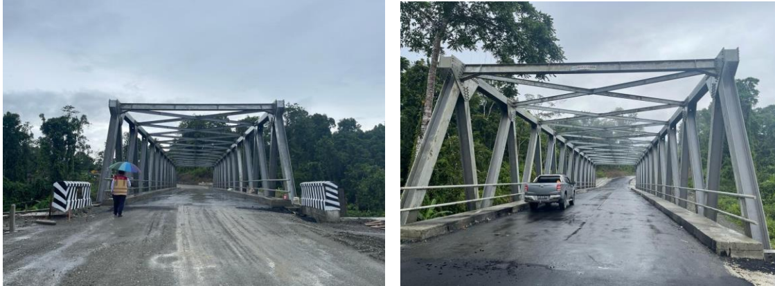
Pembangunan Jembatan Longsor I Dan Jembatan Longsor II (Myc) (Jalan Perbatasan)
