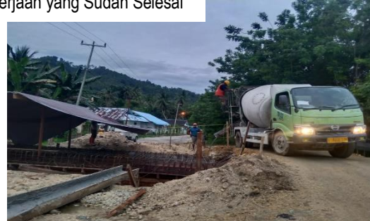
Dokumentasi Pekerjaan Box Culvert yang masih belum selesai (dikerjakan pada masa denda)
