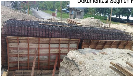
Dokumentasi Pekerjaan Box Culvert yang masih belum selesai (dikerjakan pada masa denda)
