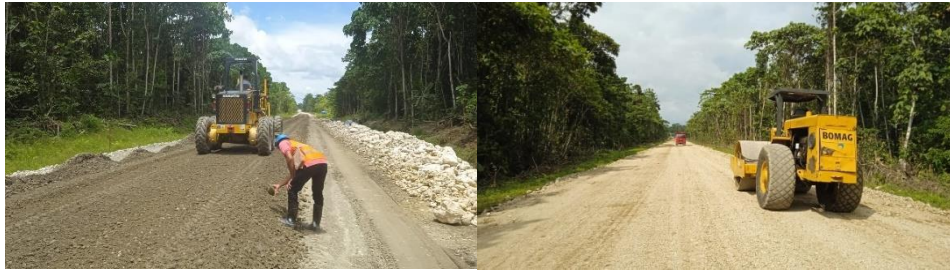
Gambar 4.5 Peningkatan Struktur Jalan Tanpa Penutup Nabire-Botawa penanganan Satker PJJN Wil. VII Prov. Papua (Nabire)
