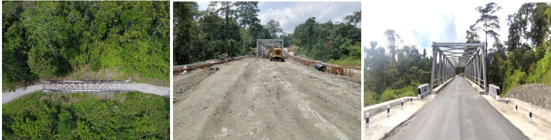
Gambar 4.11 Pembangunan Jembatan Longsoran I dan Jembatan Longsoran II(MYC) penanganan Satker PJJN Wil. I Prov. Papua (Jayapura)
