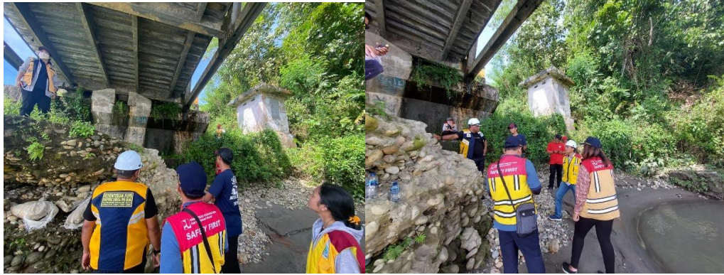
Gambar 4.36 Monitoring dan Evaluasi Jembatan Ruas Nabire-Wanggar
