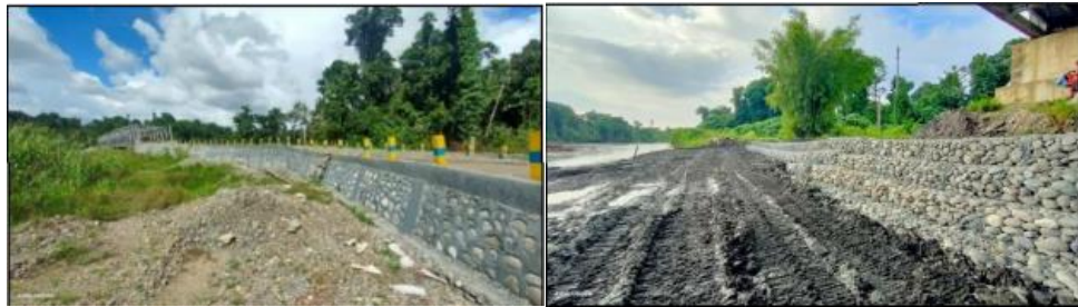
Gambar 4.8 Pembangunan Jembatan Botawa Tahap II (Tuntas) penanganan Satker PJJN Wil. VII Prov. Papua (Nabire)
