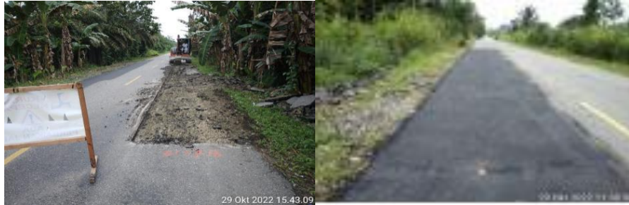
Gambar 4.15 Preservasi Jalan Abepura-Arso-Waris-Yetti penanganan Satker PJN Wil. I Provinsi Papua (Jayapura)
