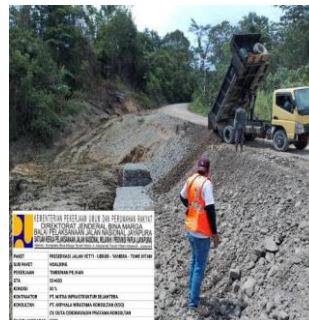
Gambar 4.31 Preservasi Jalan Yetti-Ubrub-Yambra-Towe Hitam penanganan Satker PJN Wil.I Provinsi Papua (Jayapura)
