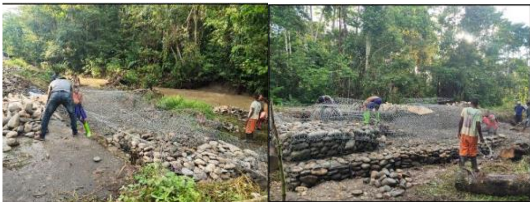
Gambar 4.22 Pemeliharaan Rutin Jalan Wapoga-Lagari penanganan Satker PJN Wil. VII Prov. Papua (Nabire)
