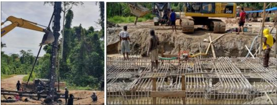
Gambar 4.10 Pembangunan Jembatan Aery 2 penanganan Satker PjN Wil. VII Prov. Papua (Nabire)
