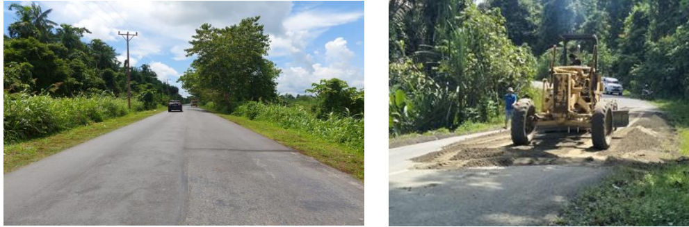
Gambar 4.23 Preservasi Jalan Abepura-Arso-Waris-Yetti penanganan Satker PJN Wil. I Provinsi Papua (Jayapura)
