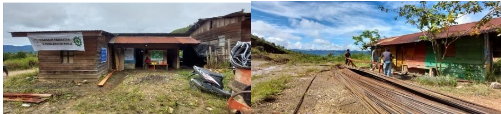
Gambar 4.29 Rehabilitasi Jembatan Bunumi 2/Budaa/Kasuari penanganan Satker PJJN Wil.VII Provinsi Papua (Nabire)
