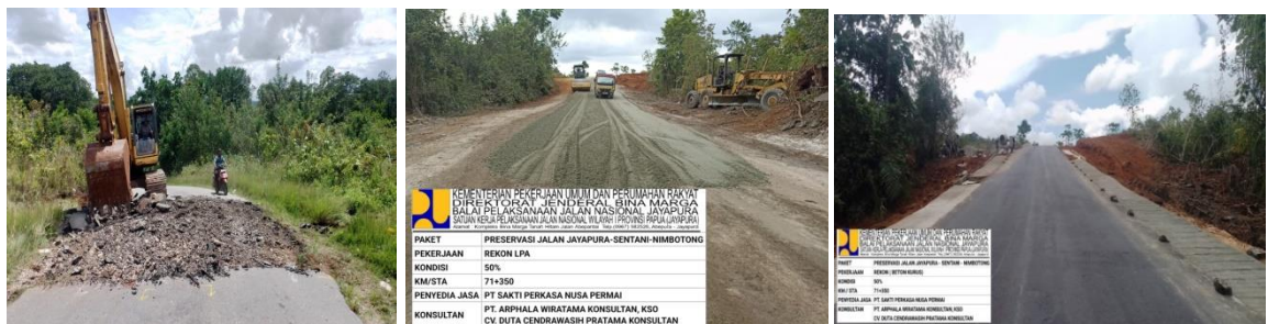
Gambar 4.32 Preservasi Jalan Jayapura-Sentani-Nimbotong penanganan Satker PJN Wil.I Provinsi Papua (Jayapura)
