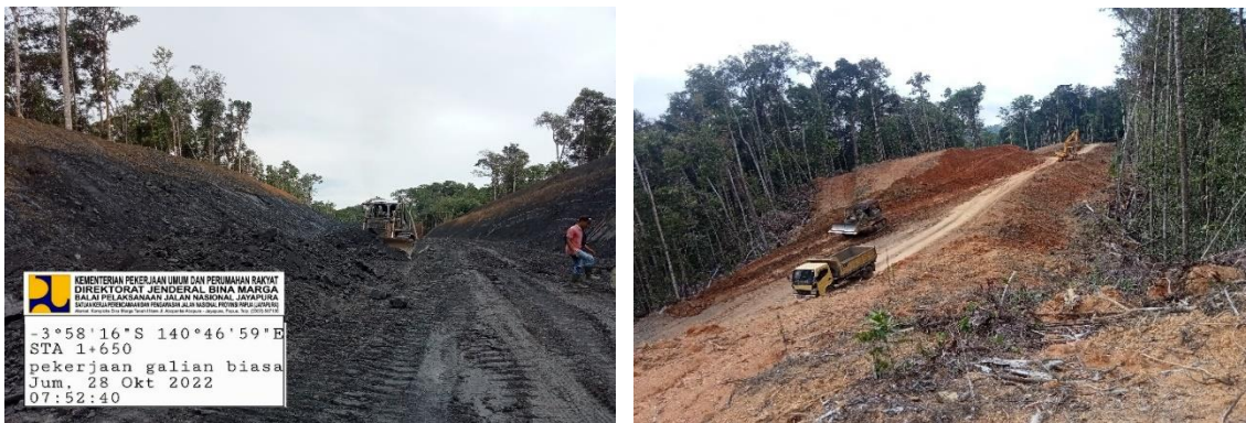
Pembangunan Jalan Towe Hitam – Oksibil (MYC) (Jalan Perbatasan)
