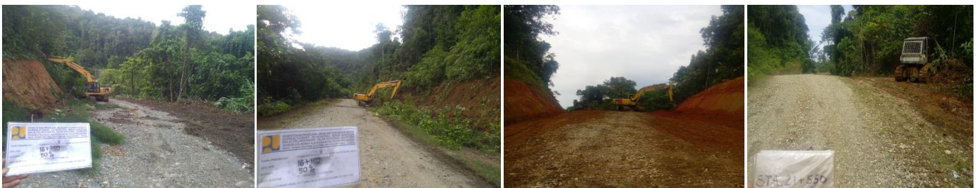
Gambar 4.37 Pembangunan Jalan Mamberamo – Elelim I (MYC)
