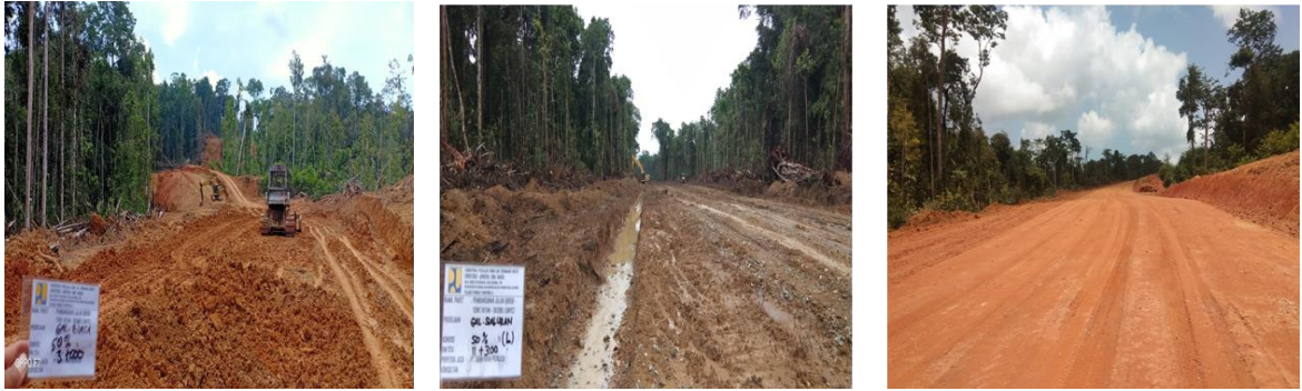
Gambar 4.12 Pembangunan Jalan Ubrub - Towe Hitam – Oksibil (MYC) penanganan Satker PJN Wil. I Prov. Papua (Jayapura)
