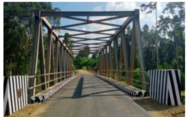
(b) Penggantian Jembatan Kali Web II (Tuntas)/PN 008
