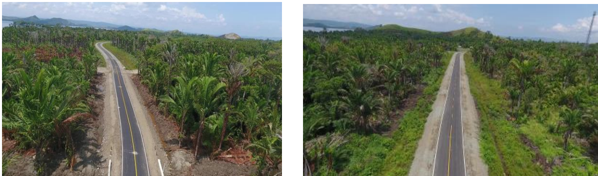
Gambar 4.14 Pembangunan Jalan Telaga Ria –Khalkote - Dapur Papua (MYC) penanganan Satker PJN Wil. I Prov. Papua (Jayapura)
