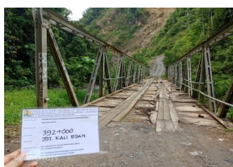
Jembatan Kali Edan (Km 392+000)
