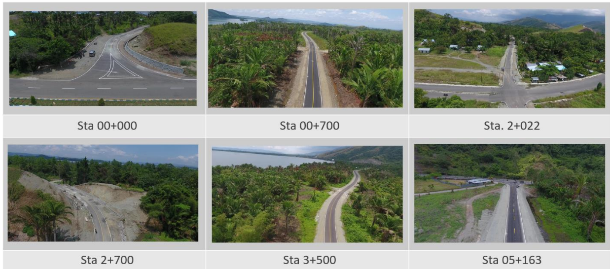
Gambar 4.32 Peta dan Dokumentasi Lokasi Pekerjaan Pembangunan Jalan Telaga Ria – Khalkote – Dapur Papua (MYC) di Kabupaten Jayapura
