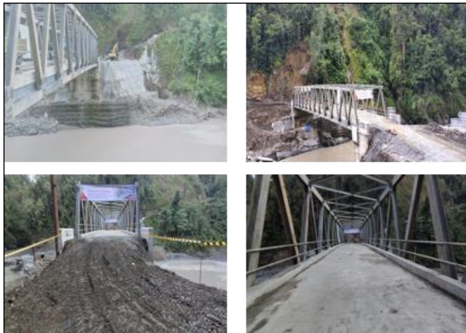
Gambar 4.35 Progress Pembangunan Jembatan Yahuli
