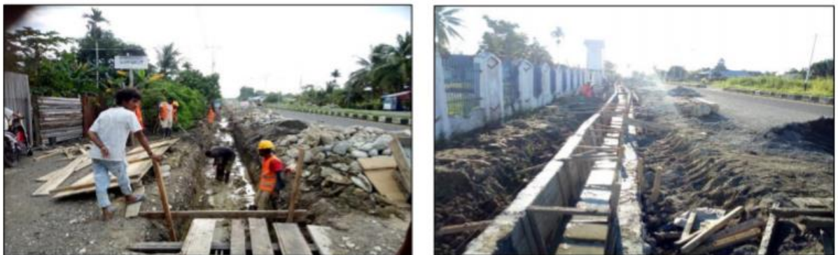
Gambar 4.21 Revitalisasi Drainase Ruas Jalan Bts. Kota Nabire-Kimibay penanganan Satker PJJN Wil. VII Prov. Papua (Nabire)
