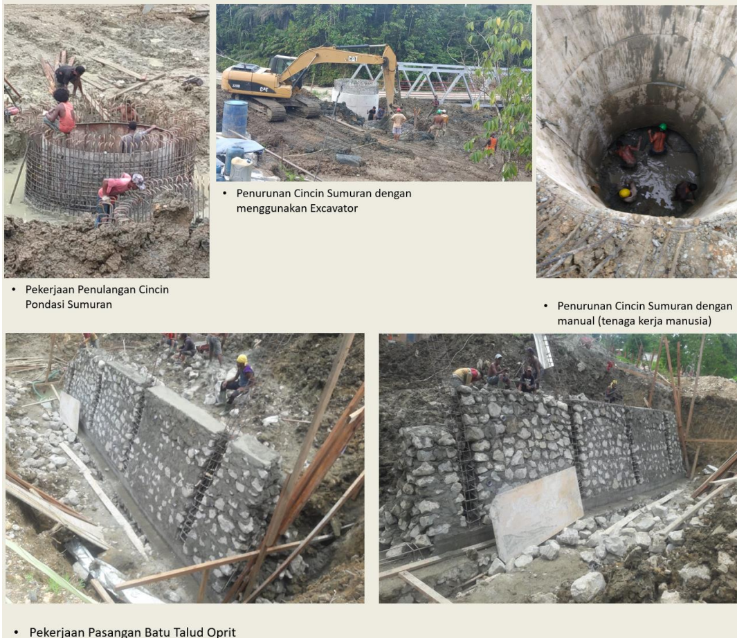
Gambar 4.26 Penggantian Jembatan Sawitami V (Tahap I) penanganan Satker PJN Wil. I Provinsi Papua (Jayapura)
