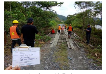
Jembatan Air Terjun (Km 350+190)
