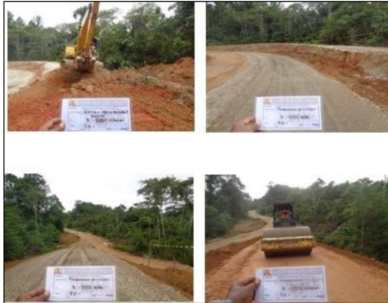
Gambar 4.38 Pembangunan Jalan Mamberamo – Elelim II (MYC)
