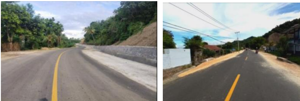
Gambar 4.19 Pekerjaan Preservasi dan Penanganan Longsor Ruas Jalan Abepura-Arso-Waris-Yetti penanganan Satker PjN Wil. I Provinsi Papua (Jayapura)
