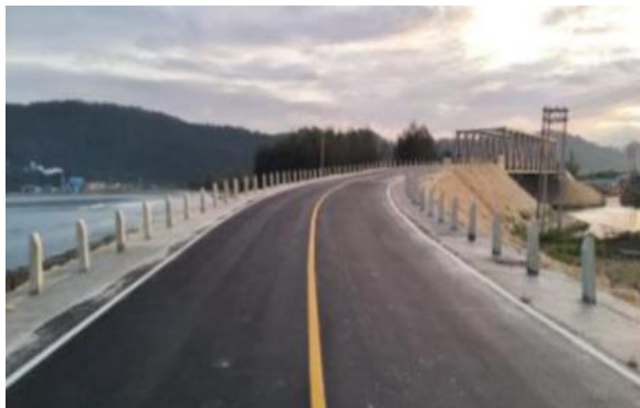
(a) Penggantian Jembatan Kali Buaya
