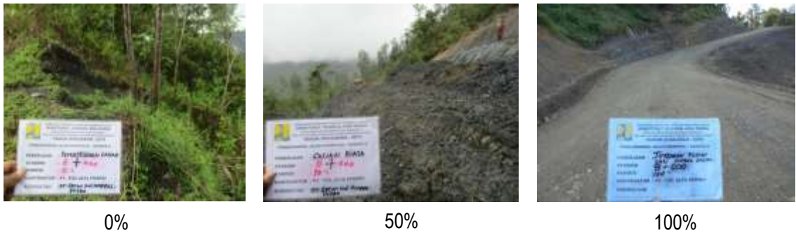
Gambar 4.37 Pembangunan Jalan Enarotali-Sugapa II
