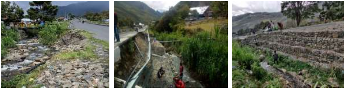
Gambar 4.23 Pemeliharaan Rutin Jalan Beoga - Ilaga – Mulia oleh Satker PJN Wil. V Provinsi Papua (Puncak Jaya) berupa Galian Biasa, Timbunan Pilihan, Bronjong Pemeliharaan Rutin Saluran Air dan Pengendalian Tanaman
