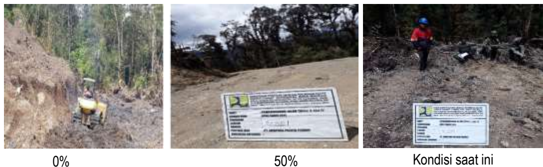
Gambar 4.31 Pembangunan Jalan Sinak - Ilaga IV
