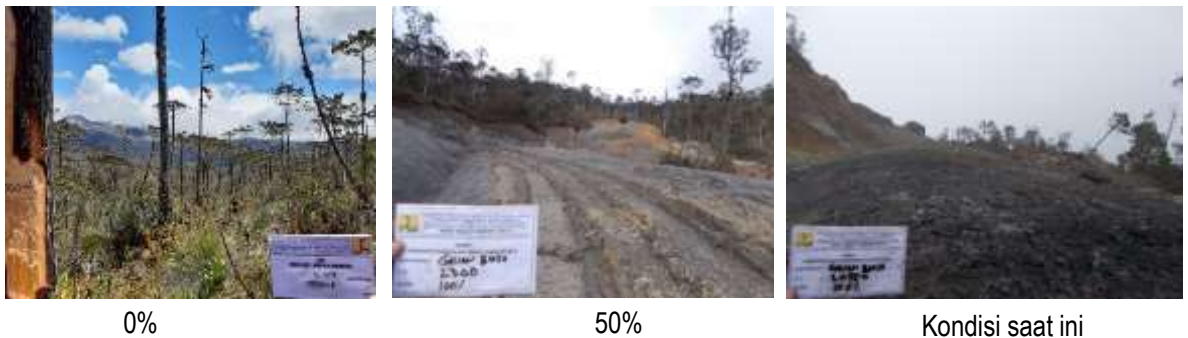
Gambar 4.30 Pembangunan Jalan Sinak - Ilaga III
