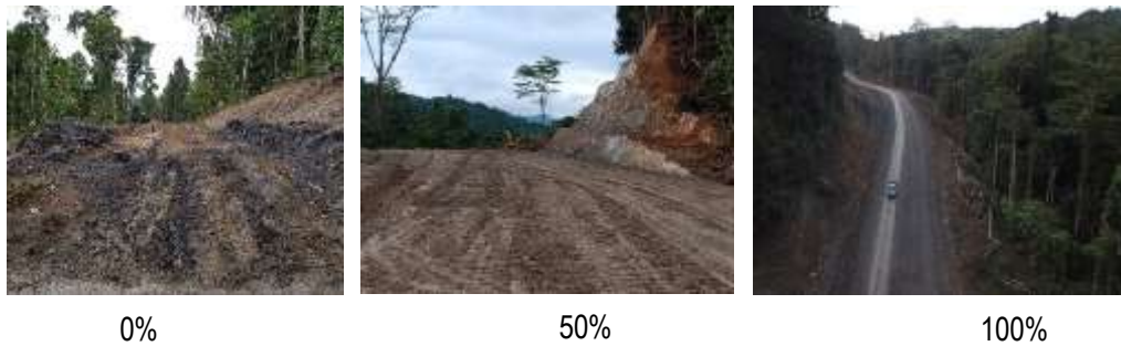
Gambar 4.34 Pembangunan Jalan Wanggar - Kwatisore - Kamp. Muri 1 dan 2 Lanjutan
