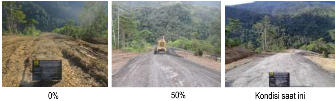
Gambar 4.36 Pembangunan Jalan Enarotali-Sugapa I
