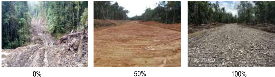
Gambar 4.32 Pembangunan Jalan Dekai - Kenyam (MYC Lanjutan)
