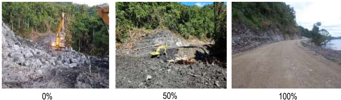
Gambar 4.33 Pembangunan Jalan Wanggar - Kwatisore - Kamp. Muri 1 dan 2 Lanjutan
