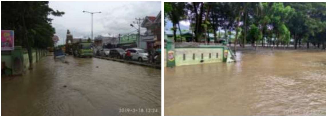
Gambar 4.3 Kejadian Banjir Bandang yang berdampak pada tidak berfungsinya jalan dan runtuhnya tembok-tembok pagar sepanjang ruas jalan di Kabupaten Sentani
