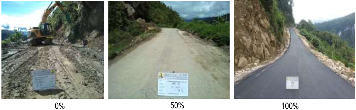
Gambar 4.13 Kegiatan Rekonstruksi Peningkatan Struktur Jalan Passvaleley – Elelim ( MYC) oleh Satker PJN Wil. IV Provinsi Papua (Jayawijaya)
