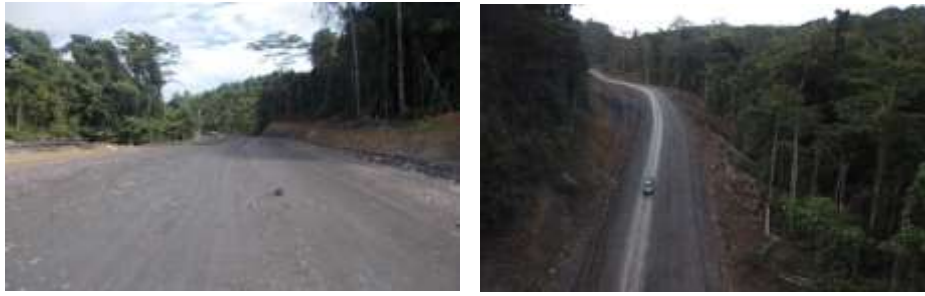
Gambar 4.25 Pembangunan Jalan Wanggar - Kwatisore - Kamp. Muri III oleh Satker PJN Wil. VII Provinsi Papua (Nabire)
