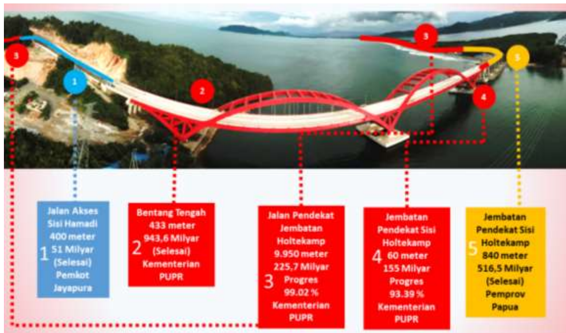
Gambar 4.40 Pembangunan Jembatan Holtekamp
