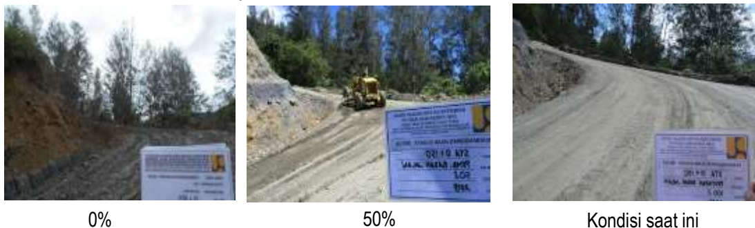
Gambar 4.35 Pembangunan Jalan Sugapa-Beoga
