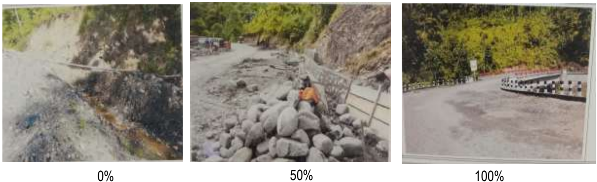
Gambar 4.16 Kegiatan Penggantian Jembatan Huplike II (Tahap III ) Tuntas yang dilakukan oleh Satker PJN Wil. IV Provinsi Papua (Jayawijaya)
