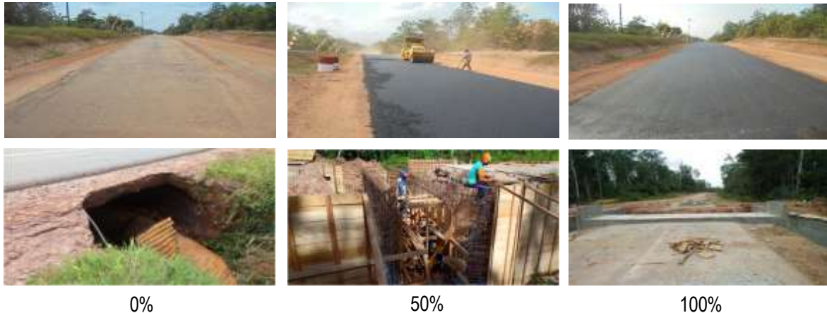
Gambar 4.6 Rehabilitasi Jalan berupa Overlay HRS-WC dan pemasangan Box Culvert di ruas Bupul-Erambu-Sota oleh Satker PJN Wil. II Merauke
