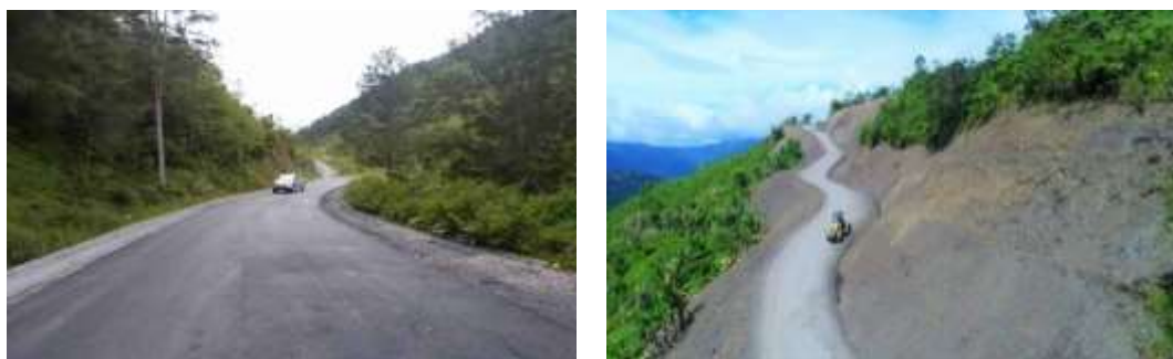
Gambar 4.56 Rekonstruksi Jalan Elelim-Passvaley
