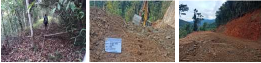
Gambar 4.39 Pembangunan Jalan Mamberamo - Elelim II
