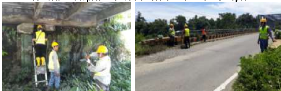
Gambar 4.13 Kegiatan Survei Kondisi Jembatan Ruas Nabire-Legare
