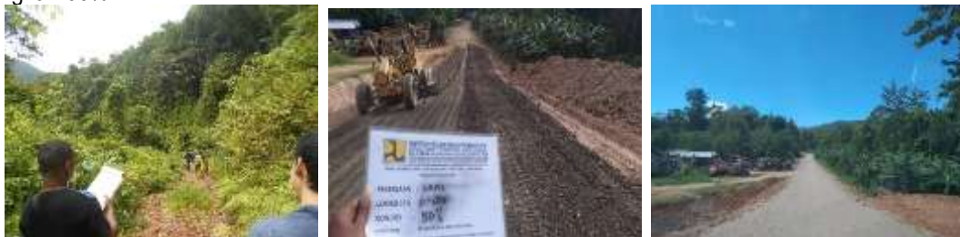
Gambar 4.45 Pembangunan Jalan Wanggar - Kwatisore - Kamp. Muri II
