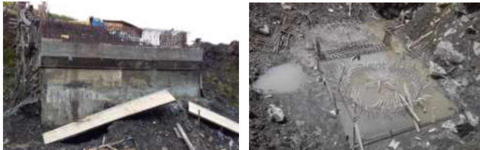
Gambar 4.25 Kondisi Paket Pembangunan Jembatan Ruas Jalan Mugi – Batas Batu – Mumugu sebelum Penembakan
