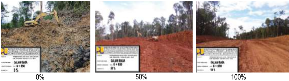
Gambar 4.19 Pembangunan Jalan Dekai-Kenyam (MYC Lanjutan) oleh Satker PJN Wil. V Provinsi Papua (Puncak Jaya)
