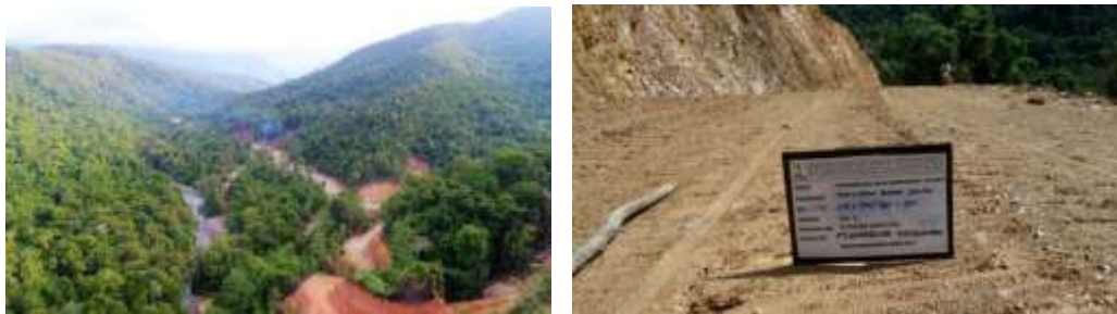
Gambar 4.53 Pembangunan Jalan Mamberamo - Elelim III
