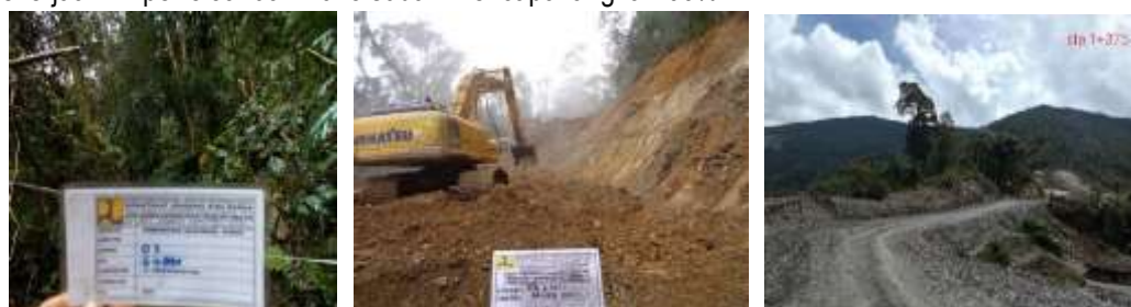
Gambar 4.49 Pembangunan Jalan Beoga - Sugapa
