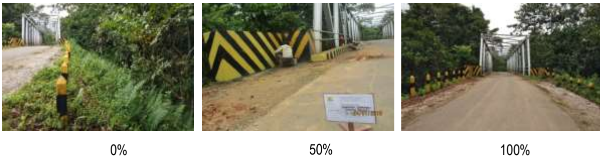
Gambar 4.8 Pemeliharaan Rutin Jembatan di ruas jalan nasional (025) (STA 351+800 – 494+700) berupa Pengecatan kembali Bangunan Pelengkap Jembatan dan Patching pada Oprit oleh Satker PJN III Prov. Papua (Tanah Merah)
