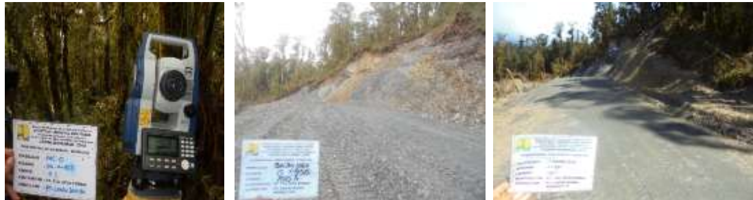
Gambar 4.48 Pembangunan Jalan Sugapa – Beoga
