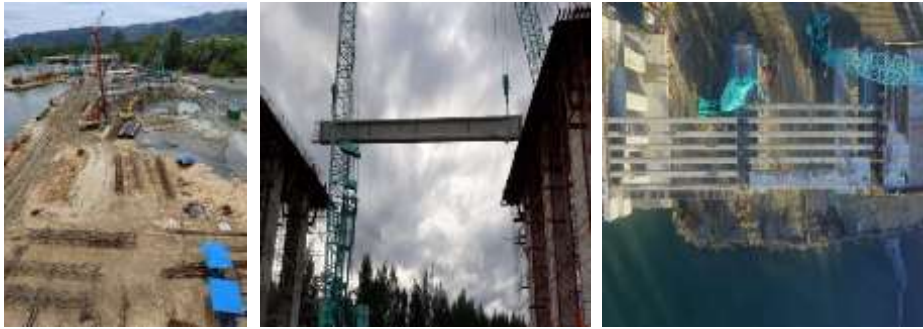
Gambar 4.54 Pembangunan Jembatan Pendekat Holtekamp (P5-P6-P7)
