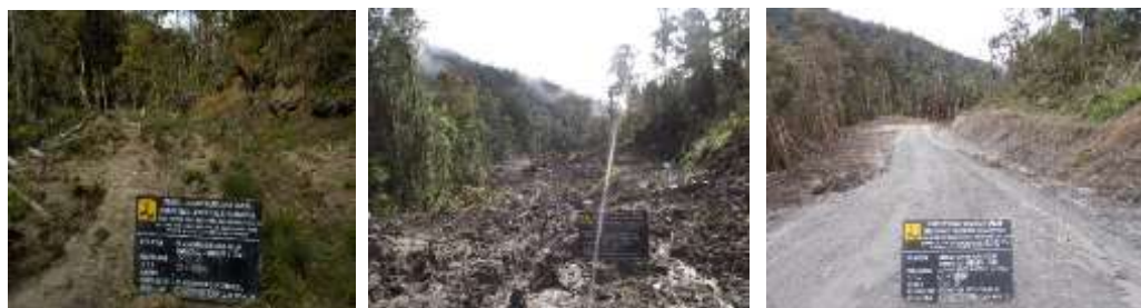
Gambar 4.46 Pembangunan Jalan Enarotali - Sugapa I
