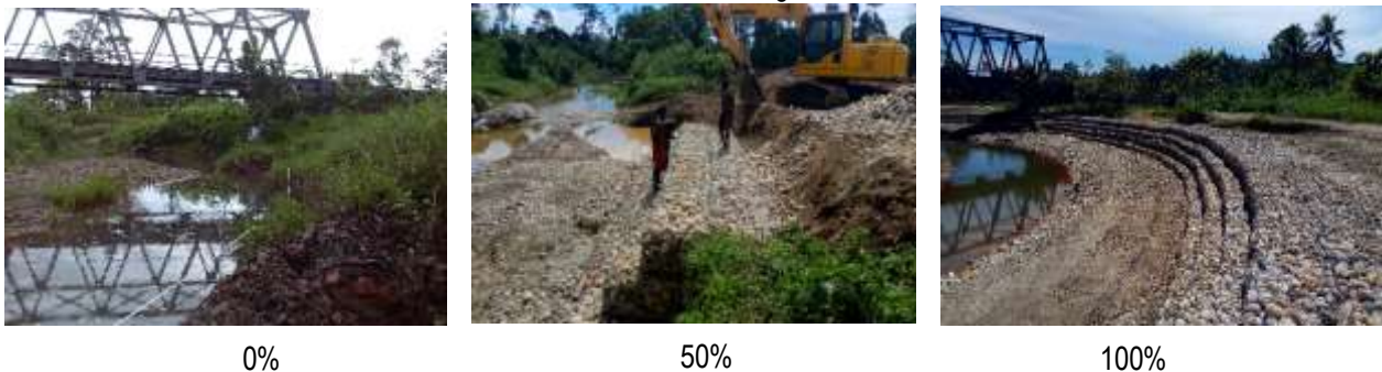
Gambar 4.10 Rehabilitasi Jembatan Matoa (Penanganan Scouring) oleh Satker PJN Wil. VII Provinsi Papua (Nabire)
