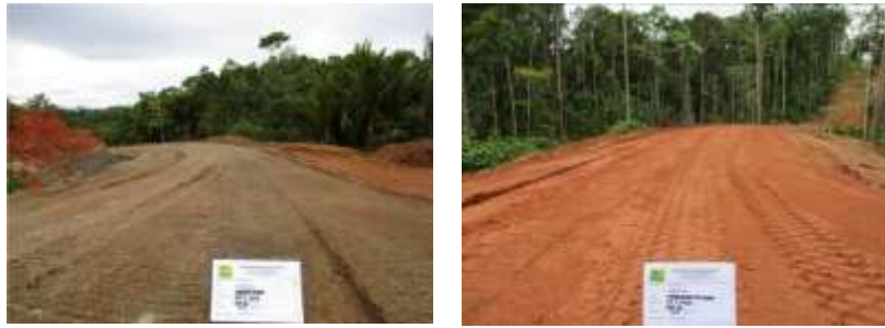
Gambar 4.52 Kondisi 100% Pembangunan Jalan Waropko -Iwur (MYC)
