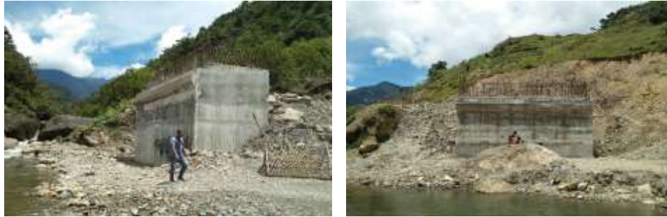
Gambar 4.24 Kondisi Paket Pembangunan Jembatan Ruas Jalan Habema – Mugi sebelum Penembakan
