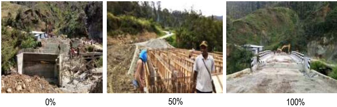
Gambar 4.11 Kegiatan Penggantian Jembatan Kali Nggoa/Poga Tahap II di ruas Jalan Nasional Usilimo-Karubaga yang dilakukan oleh Satker PJJN Wil. IV Provinsi Papua (Puncak Jaya)
