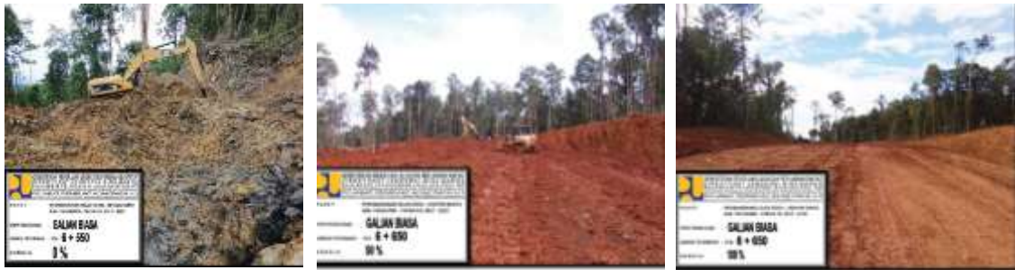
Gambar 4.42 Pembangunan Jalan Dekai - Kenyam (MYC Lanjutan)
