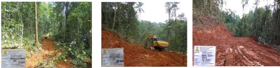
Gambar 4.31 Lokasi Pembangunan Jalan Ubrub - Towe Hitam – Oksibil
