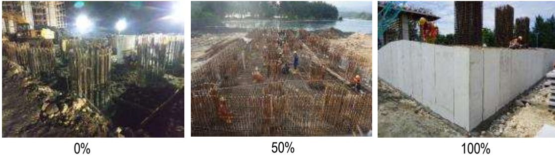
Gambar 4.27 Pembangunan Jembatan Pendekat Holtekamp (P5-P6-P7) (MYC) (Baja Tulangan U 39 Ulir - PileCap (P7)) oleh Satker PJN Wil. I Provinsi Papua (Jayapura)
