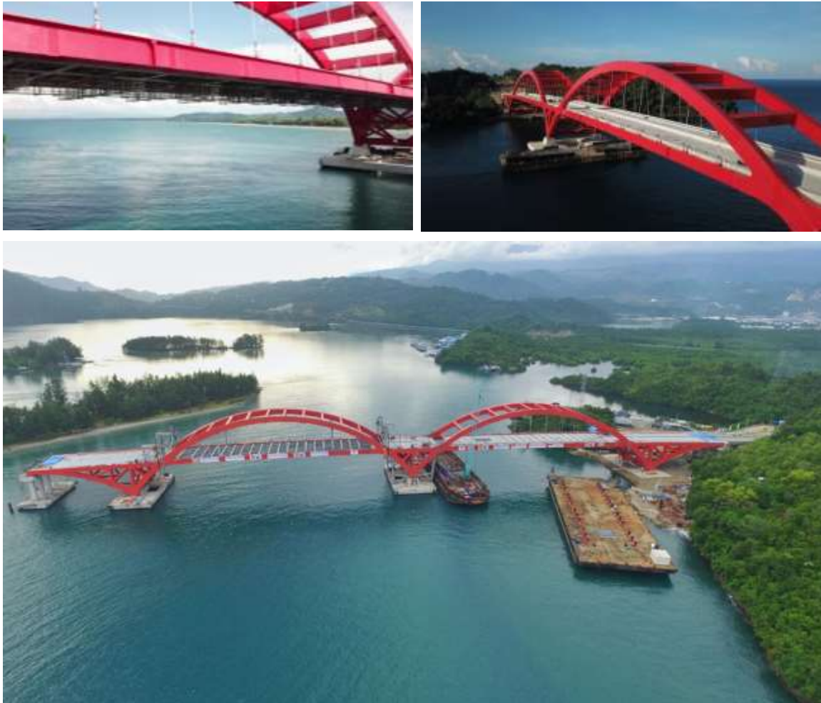
Gambar 4.36 Pembangunan Jembatan Holtekamp
