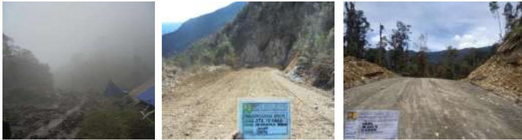
Gambar 4.50 Pembangunan Jalan Ilaga - Beoga
