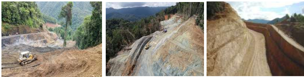
Gambar 4.38 Pembangunan Jalan Mamberamo - Elelim I
