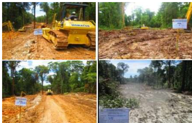
Gambar 4.51 Pembangunan Jalan Kenyam - Gearek - Dekai (MYC)
