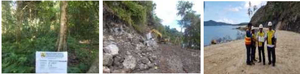
Gambar 4.44 Pembangunan Jalan Wanggar - Kwatisore - Kamp. Muri I
