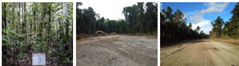
Gambar 4.43 Pembangunan Jalan Dekai - Kenyam II
