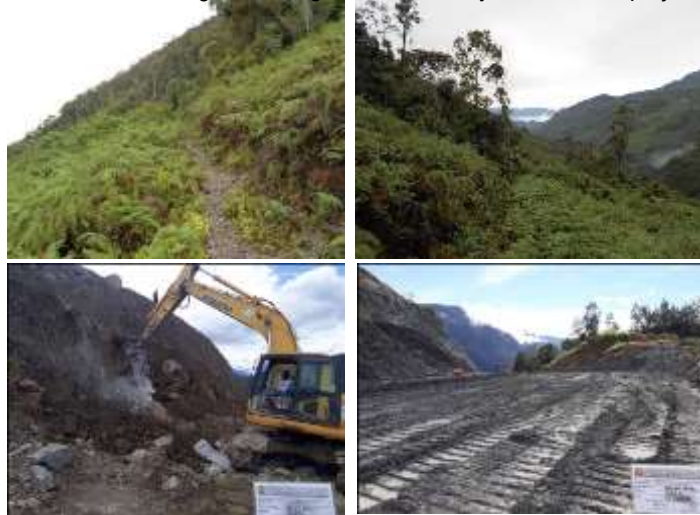
Gambar 4.33 Pelaksanaan Pekerjaan Paket Pembangunan Jalan Oksibil – Towe Hitam
