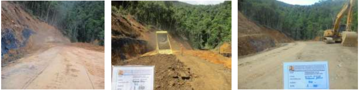
Gambar 4.37 Pembangunan Jalan Mamberamo - Elelim III
