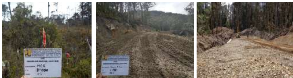
Gambar 4.41 Pembangunan Jalan Sinak-Ilaga II
