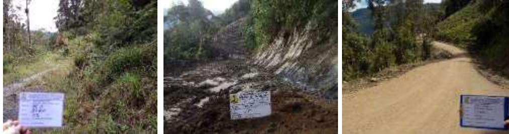
Gambar 4.47 Pembangunan Jalan Enarotali - Sugapa II
