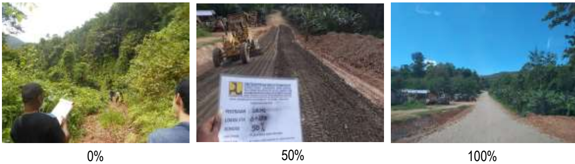
Gambar 4.20 Pembangunan Jalan Wanggar - Kwatisore - Kamp. Muri II (PN) oleh Satker PJN Wil. VII Provinsi Papua (Nabire)
