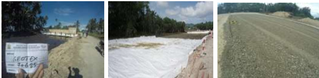
Gambar 4.55 Pembangunan Jalan Akses Jembatan Holtekamp
