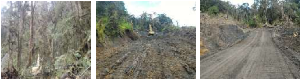
Gambar 4.40 Pembangunan Jalan Sinak-Ilaga I
