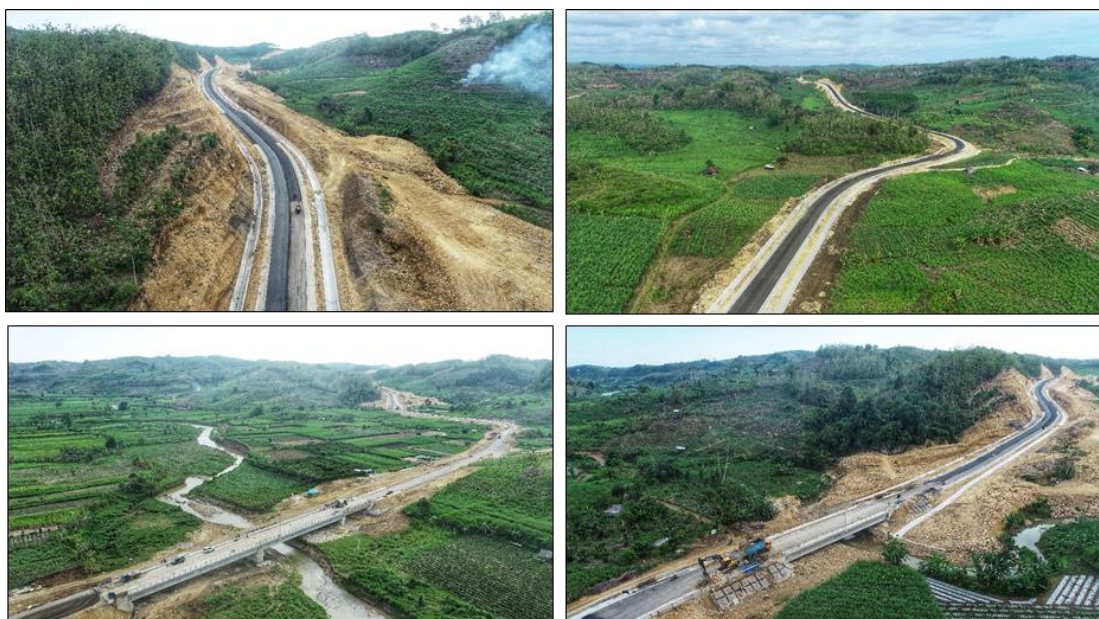
Gambar 52 Dokumentasi Pembangunan Jalan dan Jembatan Bts. Tulungagung/Blitar/P. Molang – Bululawang
