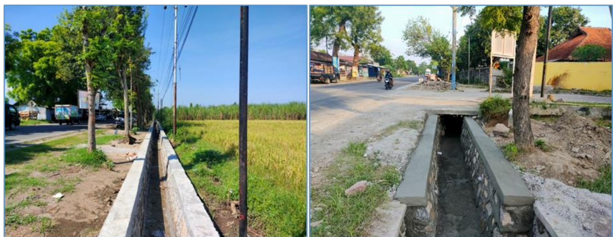
Gambar 34 Penanganan Drainase, Trotoar, dan Fasilitas Keselamatan Jalan (PEN) Wilayah II Jatim
