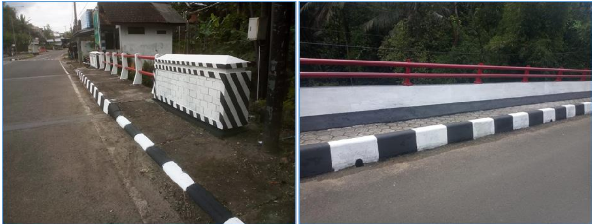
Gambar 37 Dokumentasi Pekerjaan Preservasi Rutin Jembatan (PEN)
