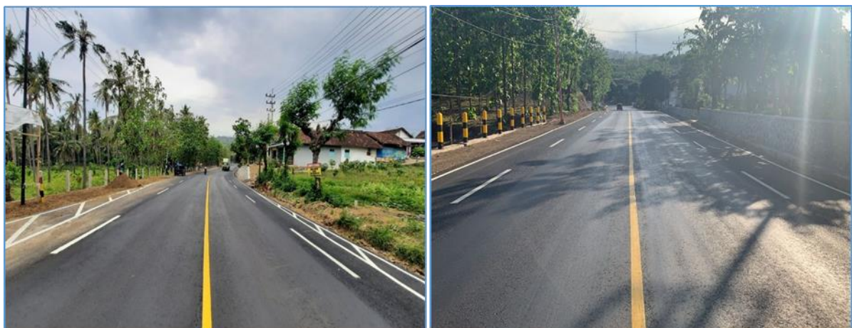
Gambar 63 Pelebaran Jalan Menambah Lajur Situbondo - Ketapang - Banyuwangi
