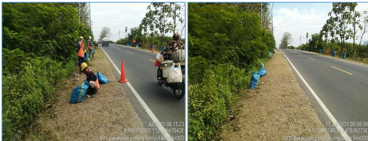
Gambar 26 Dokumentasi Pekerjaan Rutin Jalan
