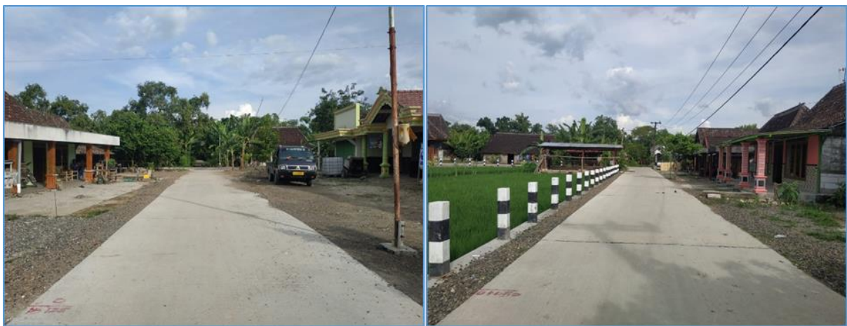
Gambar 17 Dokumentasi Pekerjaan Pembangunan Jalan Bojonegoro Barat
