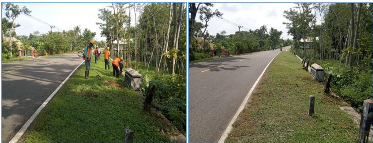
Gambar 25 Dokumentasi Pekerjaan Rutin Jalan Glonggong - Pacitan - Hadiwarno - bts. Kab. Trenggalek
