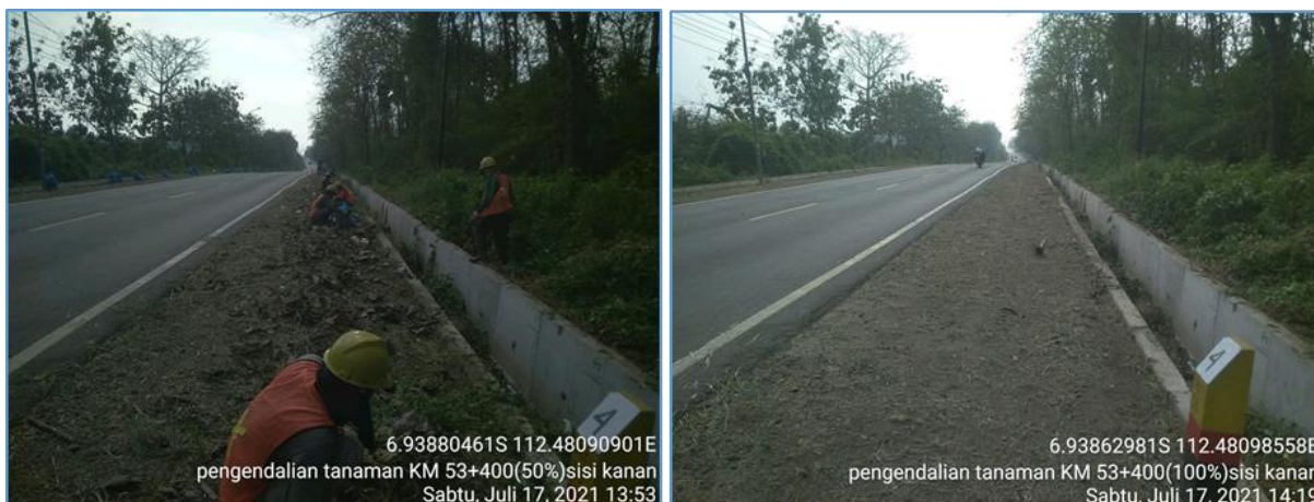
Gambar 27 Dokumentasi Pekerjaan Rutin Jalan Pengendalian Tanaman
