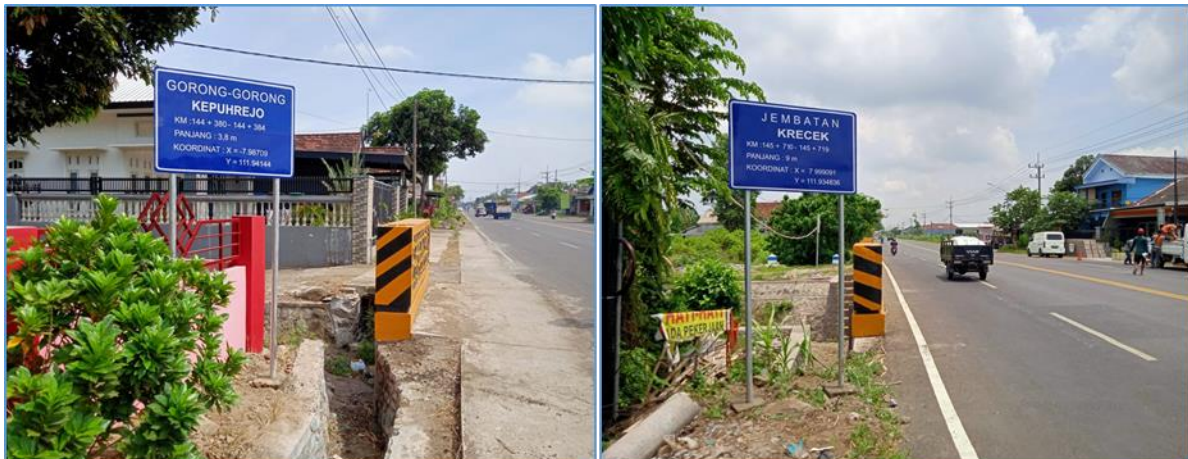
Gambar 40 Dokumentasi Pemeliharaan Rutin Jembatan di Jalan Baru
