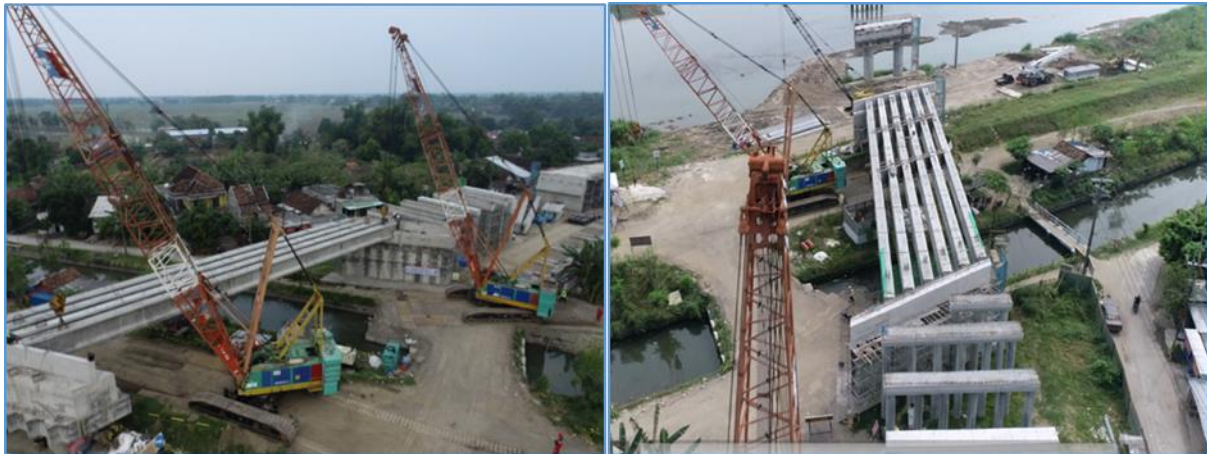
Gambar 22 Dokumentasi Pekerjaan Pembangunan Jembatan Ploso Kab. Jombang (MYC)
