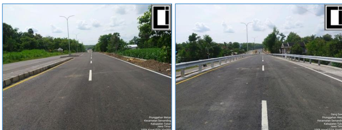
Gambar 19 Pembangunan Jalan Lingkar Tuban
