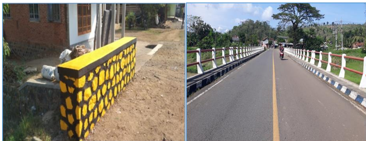
Gambar 36 Preservasi Rutin Jembatan
