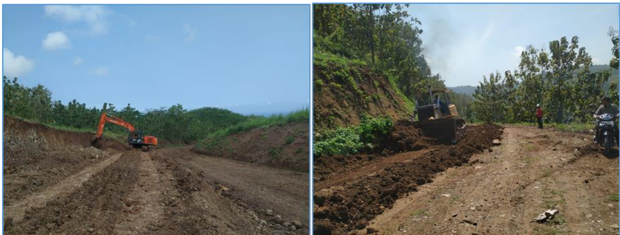
Gambar 18 Pembangunan Jalan pembangunan Jalan Ringinrejo - bts. Kab. Malang
