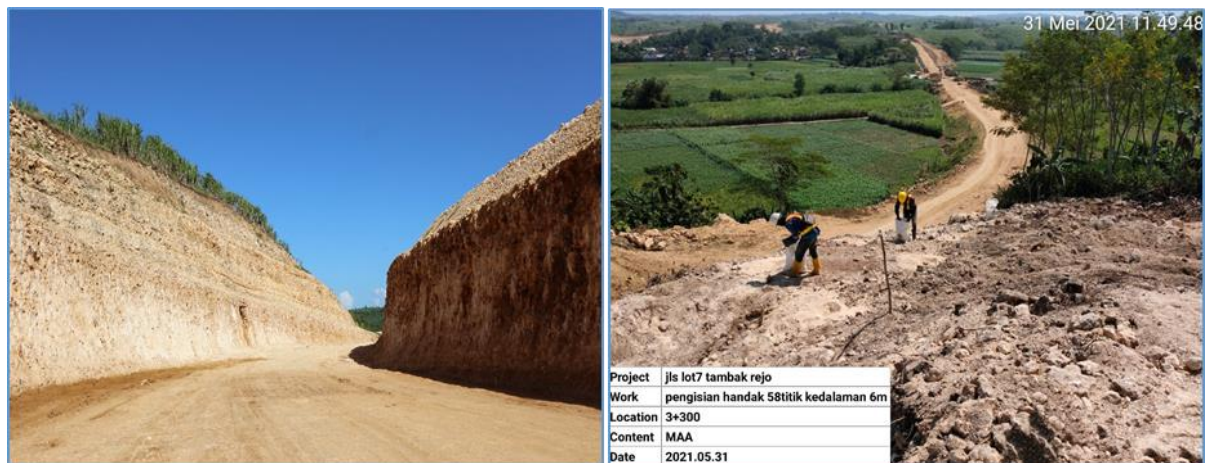
Gambar 64 Pembangunan Jalan LOT 7
