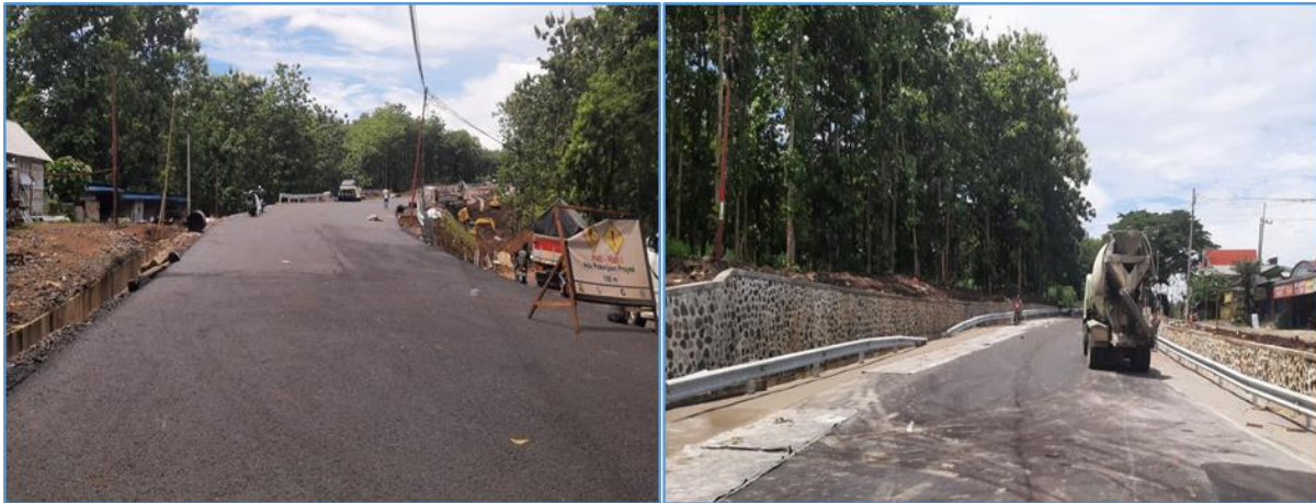
Gambar 23 Dokumentasi Pekerjaan Pembangunan Jembatan Kali Tuwuh
