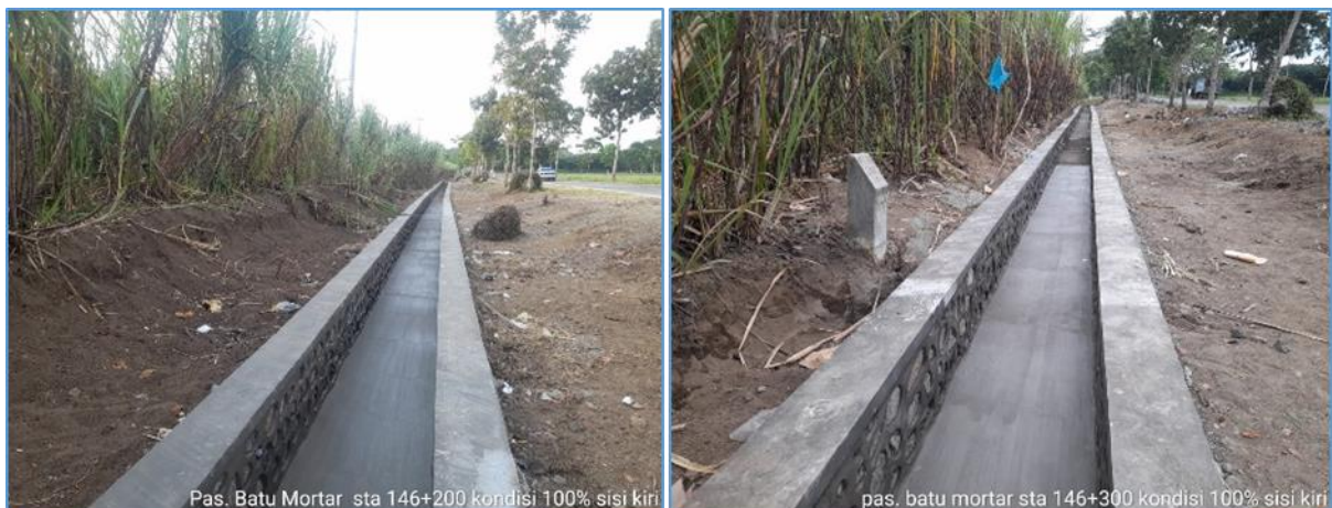
Gambar 32 Penanganan Drainase, Trotoar, dan Fasilitas Keselamatan Jalan (PEN)
