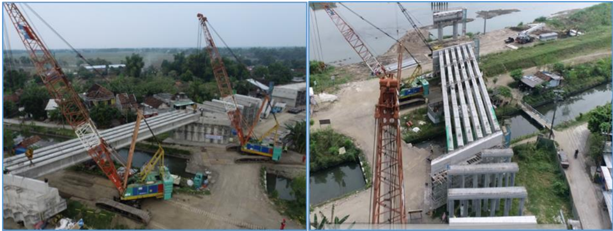
Gambar 59 Dokumentasi Pekerjaan Pembangunan Jembatan Ploso, Kab. Jombang
