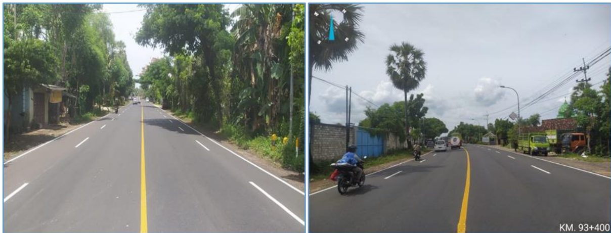
Gambar 28 Dokumentasi Pekerjaan Preservasi Jalan Widang/Bedahan - Bts.Kota Lamongan
