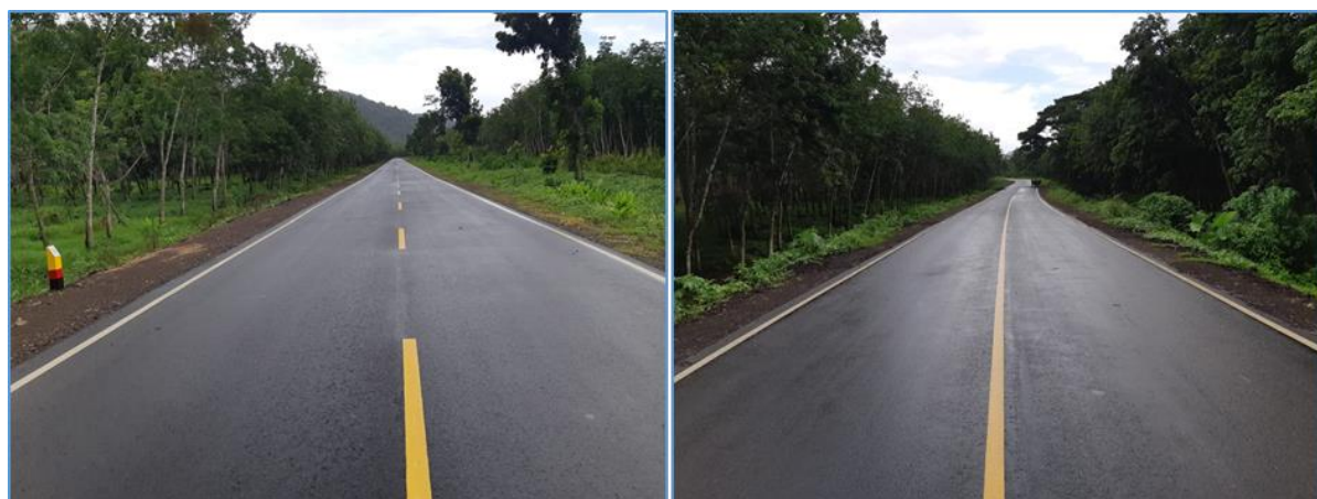
Gambar 20 Dokumentasi Pekerjaan Pembangunan Jalan Sidodadi – Sumberejo
