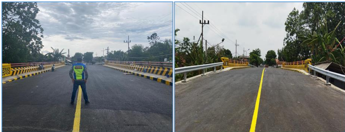
Gambar 39 Dokumentasi Penggantian Jembatan Kedung Asem
