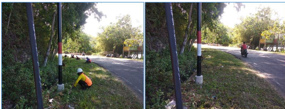
Gambar 35 Pemeliharaan Rutin Jalan Baru
