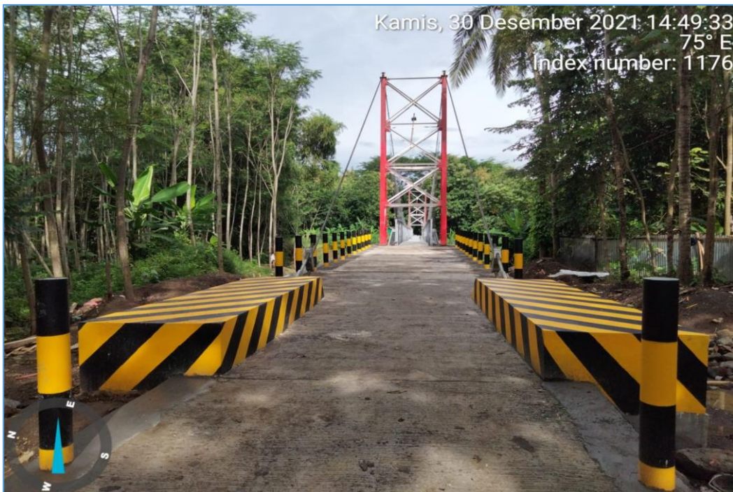
Gambar 50 Jembatan Gantung Sabrang, Kab. Jember
