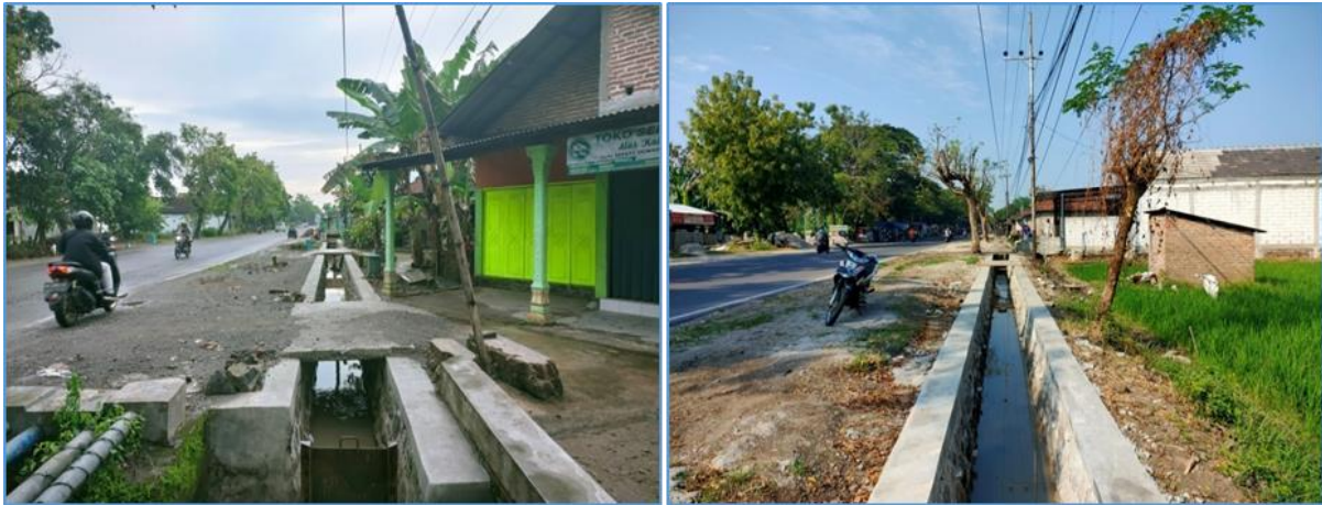
Gambar 33 Penanganan Drainase, Trotoar, dan Fasilitas Keselamatan Jalan (PEN) Tahap I
