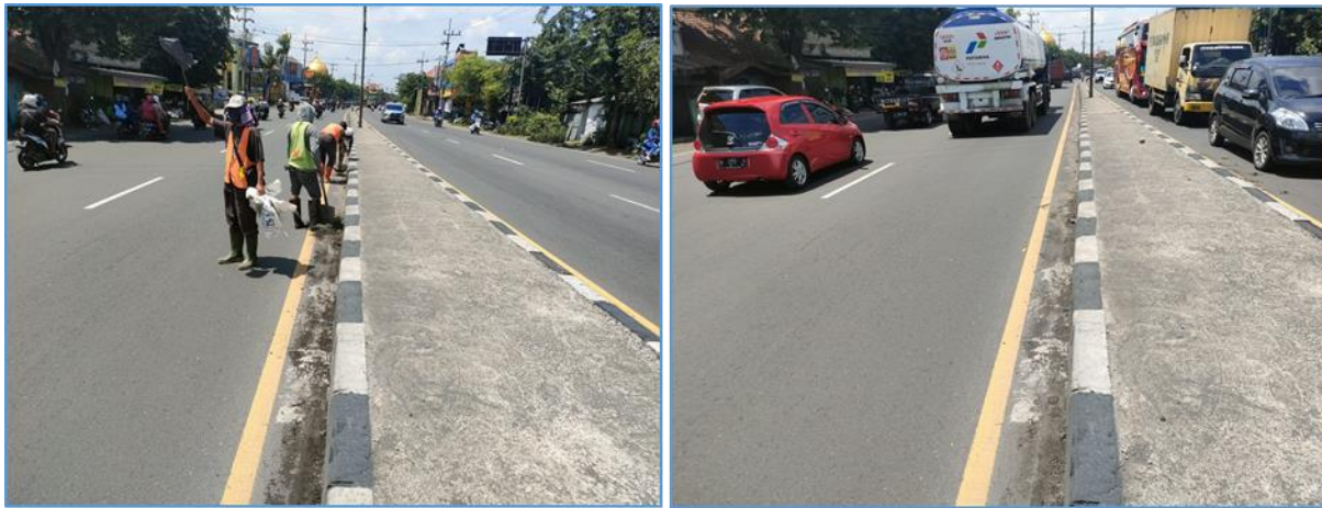
Gambar 24 Dokumentasi Pekerjaan Rutin Jalan Taman – Krian
