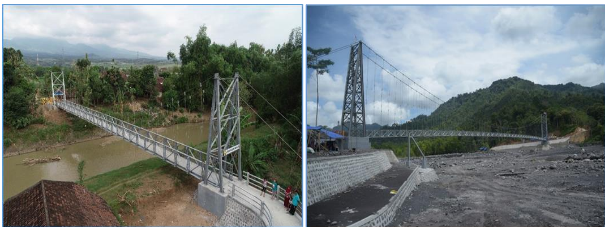
Gambar 21 Pembangunan Jembatan Gantung
