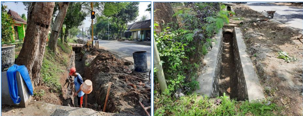
Gambar 31 Pekerjaan Revitalisasi Drainase
