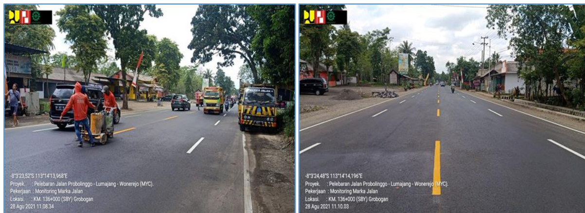
Gambar 30 Dokumentasi Pekerjaan Pelebaran Jalan Menambah Lajur
