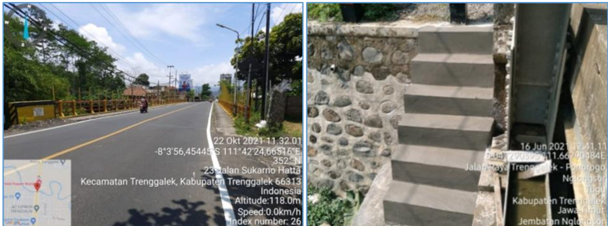
Gambar 38 Dokumentasi Pekerjaan Preservasi Jembatan
