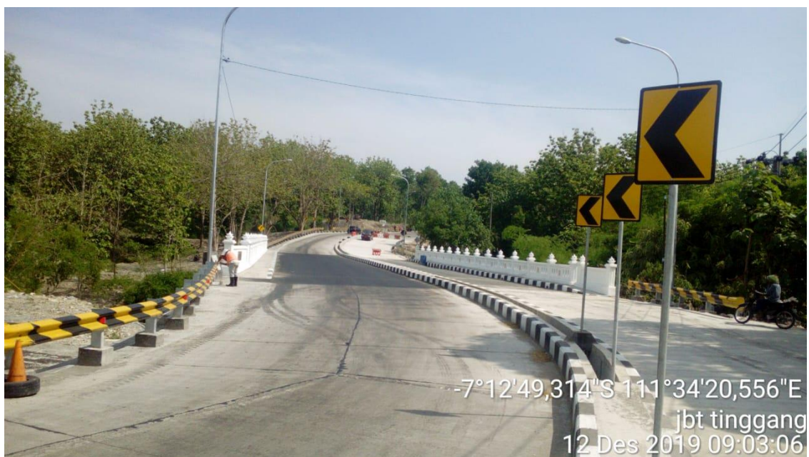
Gambar 23 Dokumentasi Pekerjaan Penggantian Jembatan
