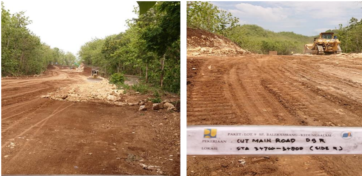
Gambar 35 Pembangunan Sp. Balekambang – Kedungsalam
