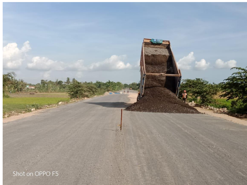
Gambar 36 Pembangunan Jarit - Puger
