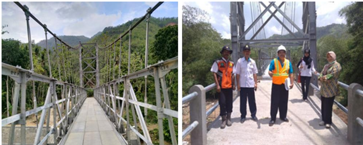
Gambar 26 Dokumentasi Pembangunan Jembatan Gantung
