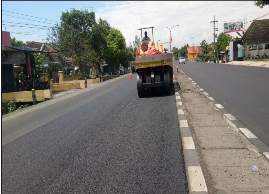
Gambar 48 Dokumentasi Pekerjaan SBSN Bts. Kota Jombang – Bts. Kab. Mojokerto
