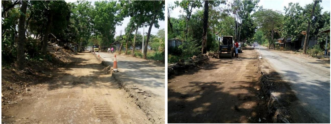
Gambar 51 Dokumentasi Pekerjaan Rehab Mayor Jalan Laweyan - Sukapura
