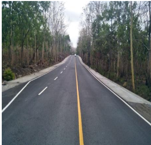
Gambar 24 Dokumentasi Pekerjaan Pelebaran Jalan Menambah Lajur
