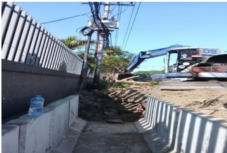
Gambar 44 Foto Dokumentasi Pekerjaan Uditch
