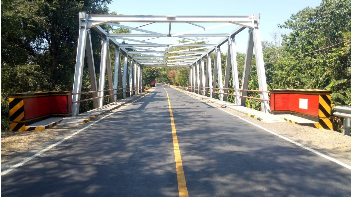
Gambar 22 Dokumentasi Pekerjaan Preservasi Jembatan
