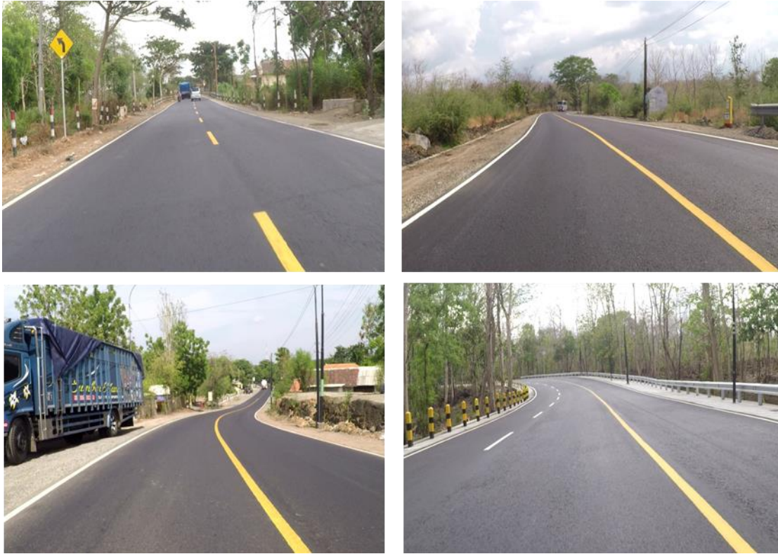
Gambar 20 Dokumentasi Pekerjaan Rekon Rehab Jalan
