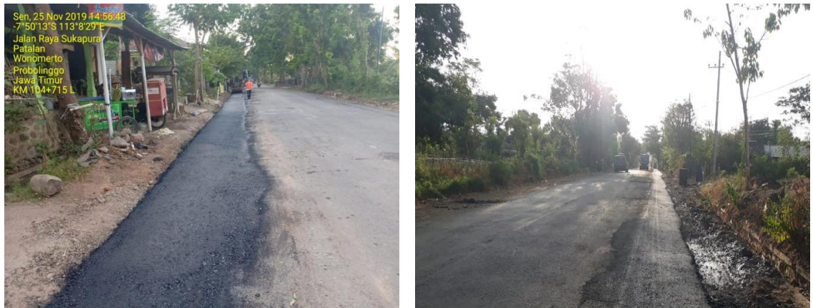
Gambar 52 Dokumentasi Pekerjaan Pelebaran Jalan Laweyan - Sukapura
