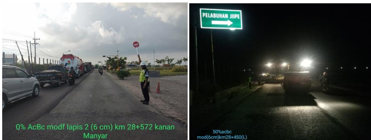
Gambar 38 Dokumentasi Pekerjaan di Kawasan JIPE
