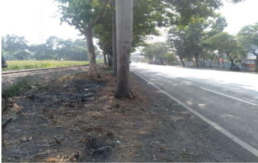
Gambar 25 Dokumentasi Pekerjaan Pemeliharaan Rutin Jalan Baru
