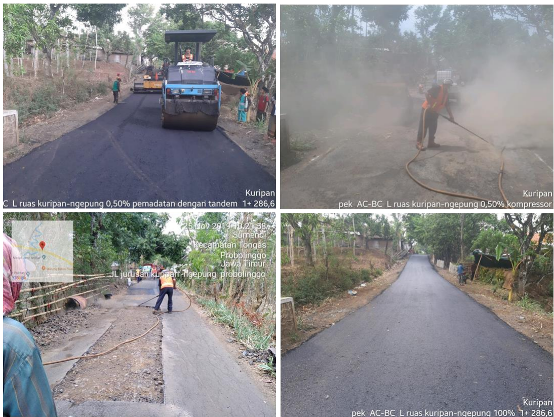
Gambar 55 Dokumentasi Pekerjaan Preservasi Rehabilitasi Jalan Ruas Kuripan - Ngepung dan Ruas Sepuh Gembol - Purut Kabupaten Probolinggo
