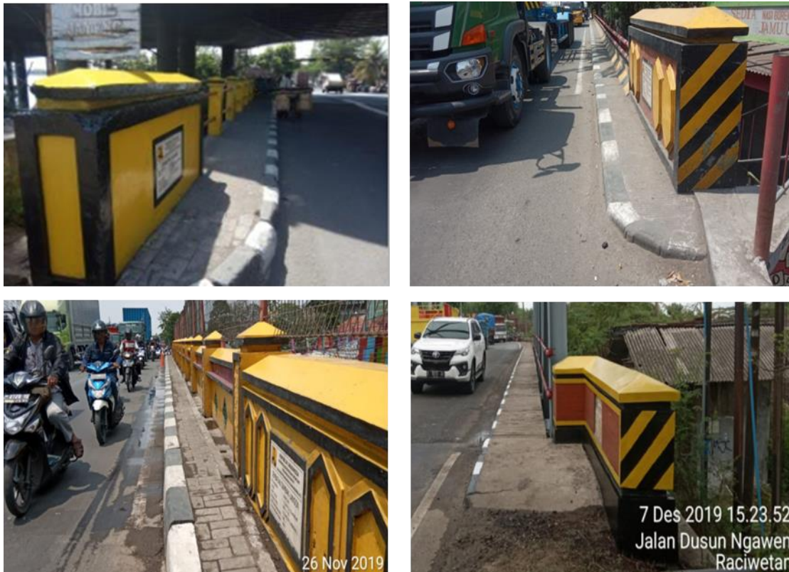
Gambar 21 Dokumentasi Pekerjaan Rutin Jembatan
