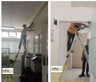
Pemeliharaan Gedung Kantor
