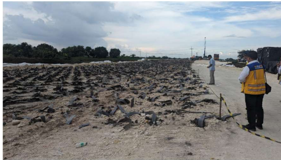
Kunjungan Lapangan Pembangunan Jalan Lingkar Utara Lamongan
