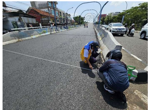
Pemeriksaan Hasil Pekerjaan Overlay Aspal di Flyover Jaksa Agung R.Soeprapto, Antapani, Bandung
