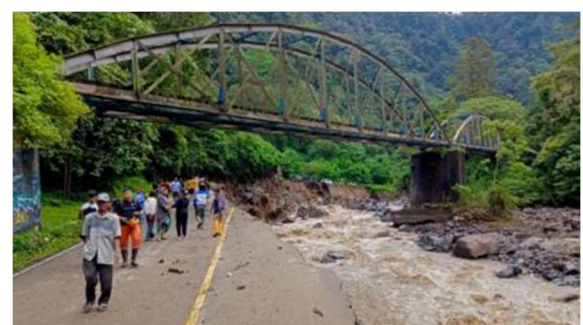
Tinjauan Lapangan Kejadian Bencana Alam Ruas Bts. Kota Padang Panjang – Sicincin
