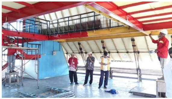
Perbaikan Rumah Apung Semarang
