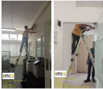
Pemeliharaan Gedung Kantor
